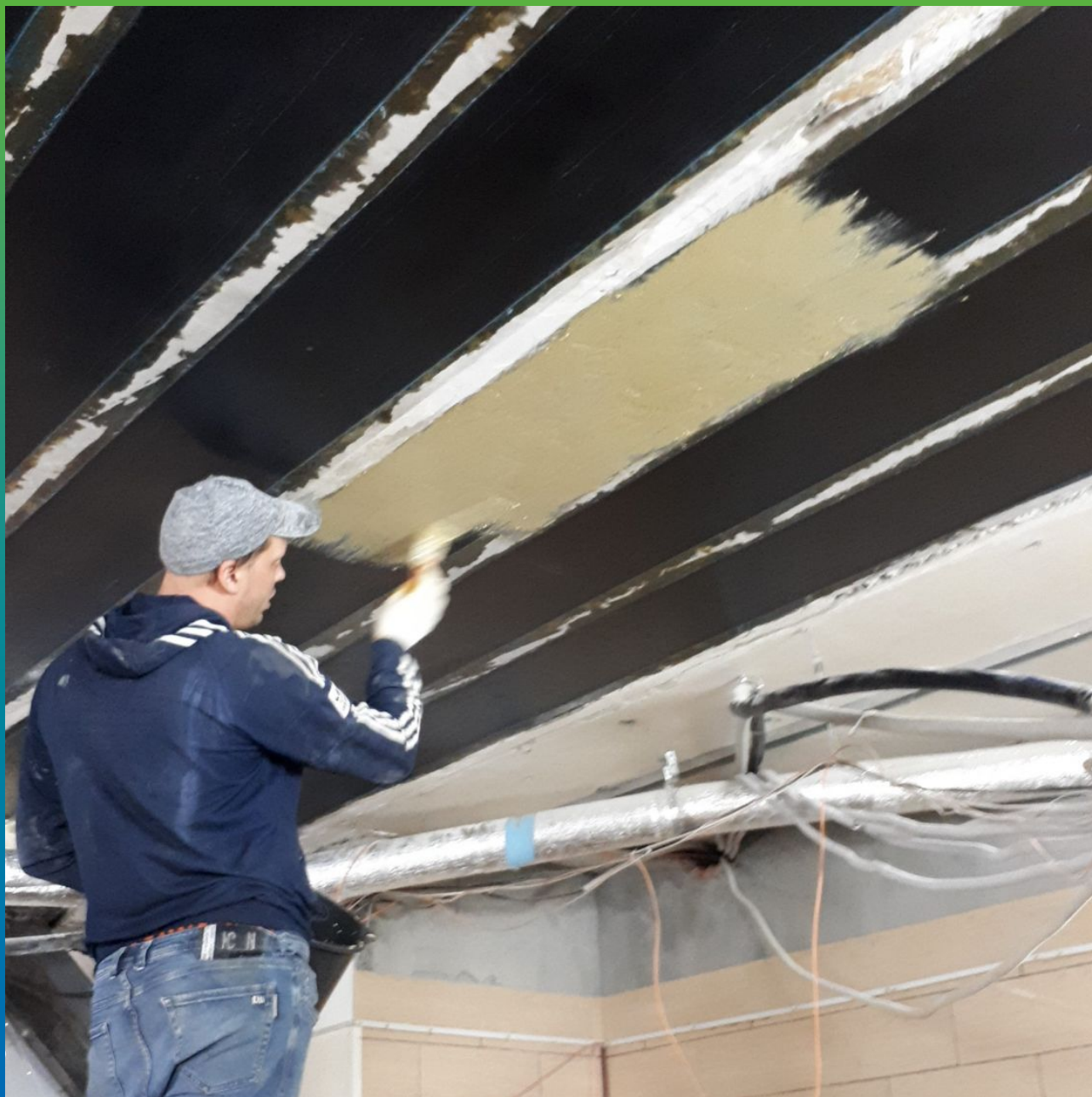
Грунтование Пирошел Бонд по углеволокну
