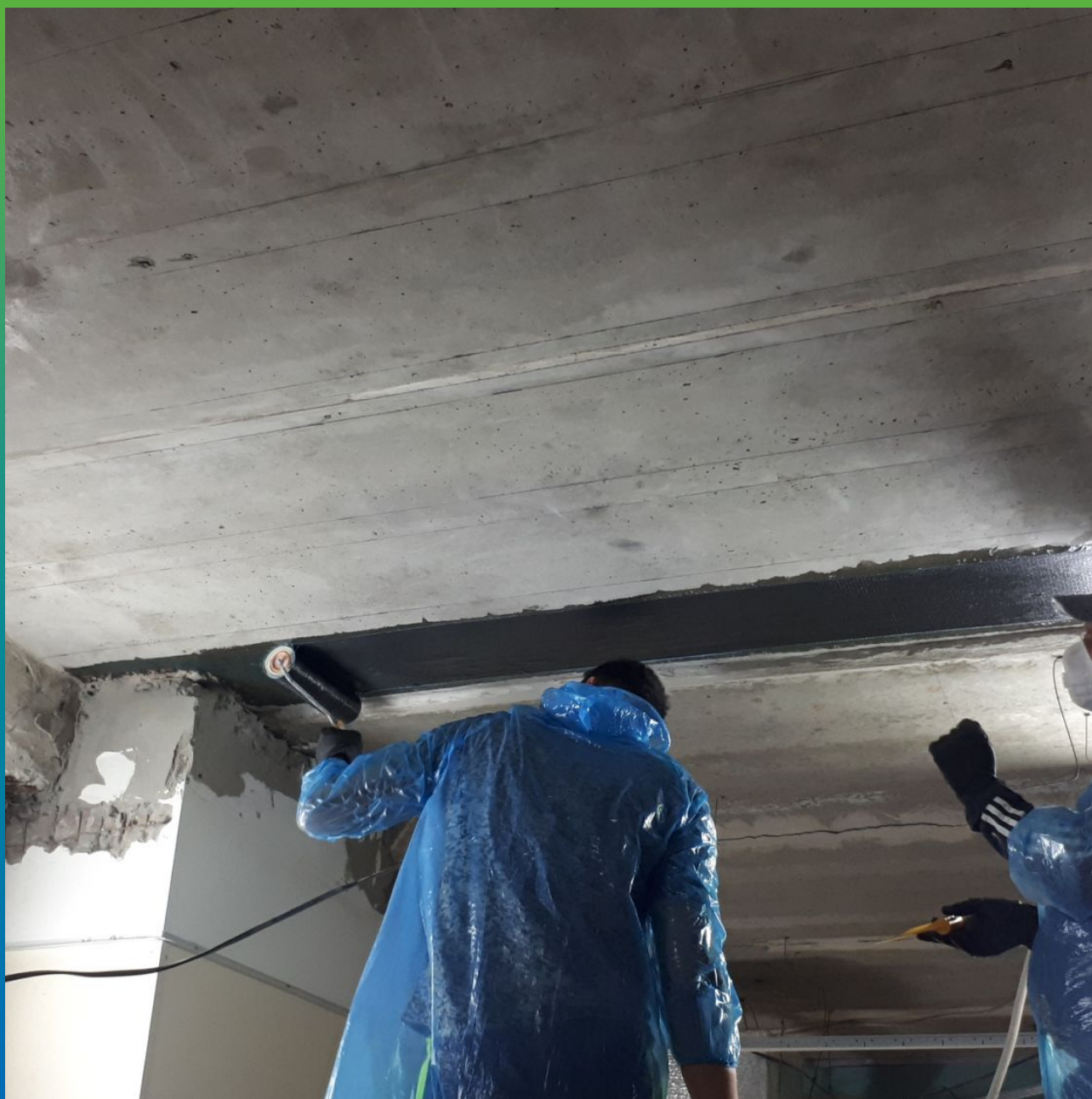
Нанесение загущенного Манопокс 372 перед приклейкой холста
