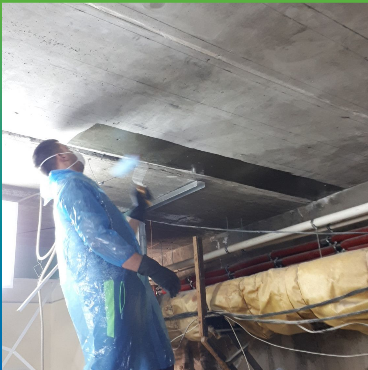
Грунтование потолочной поверхности составом Манопокс 372 перед нанесением углеволокна
