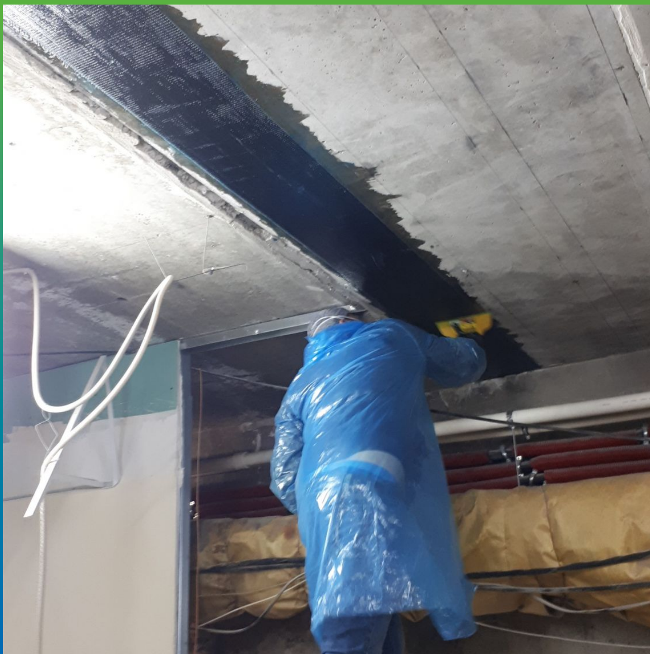
Заглаживание полотна. Убираются пузырьки воздуха
