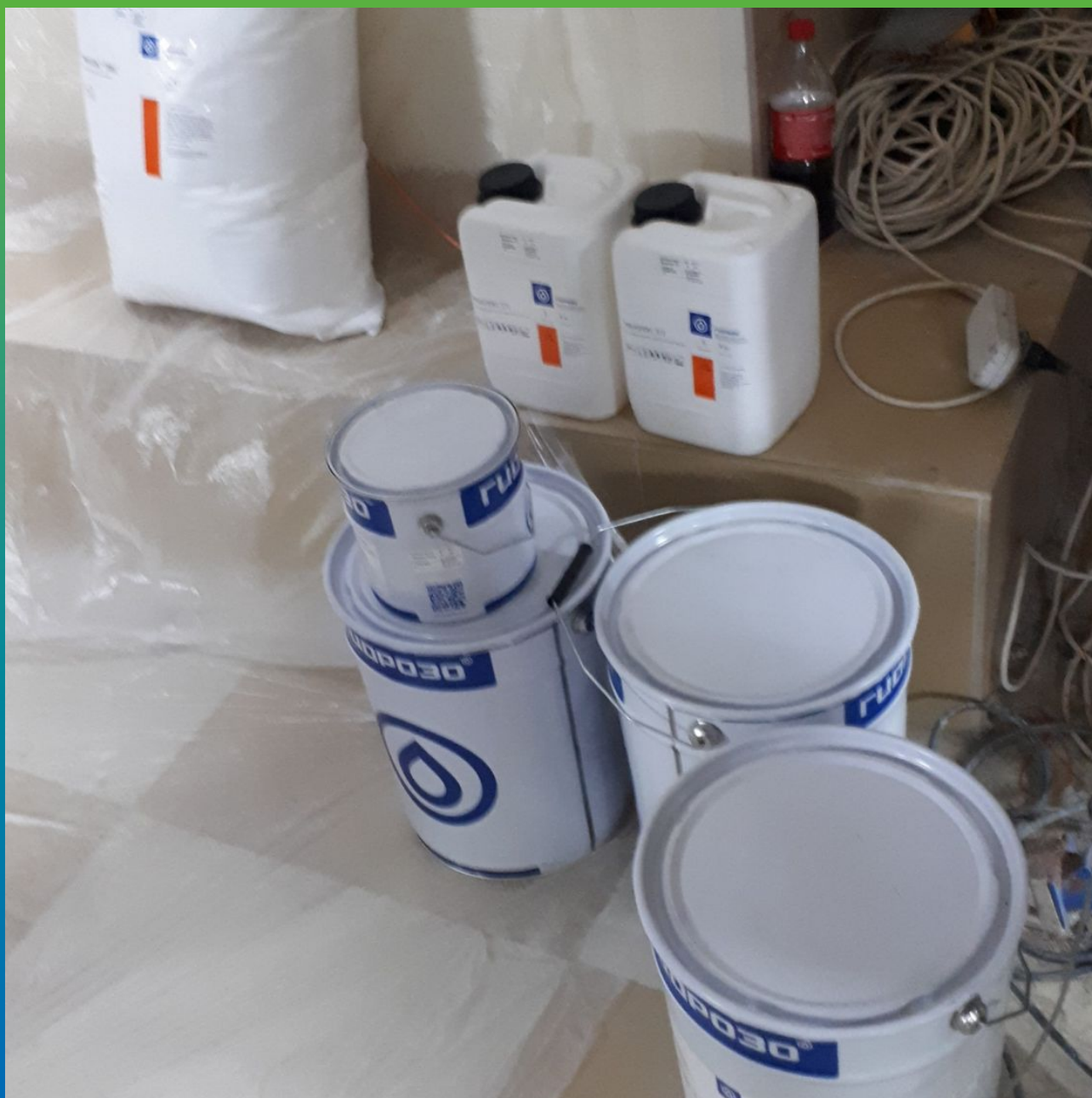
Материалы Гидрозо на объекте
