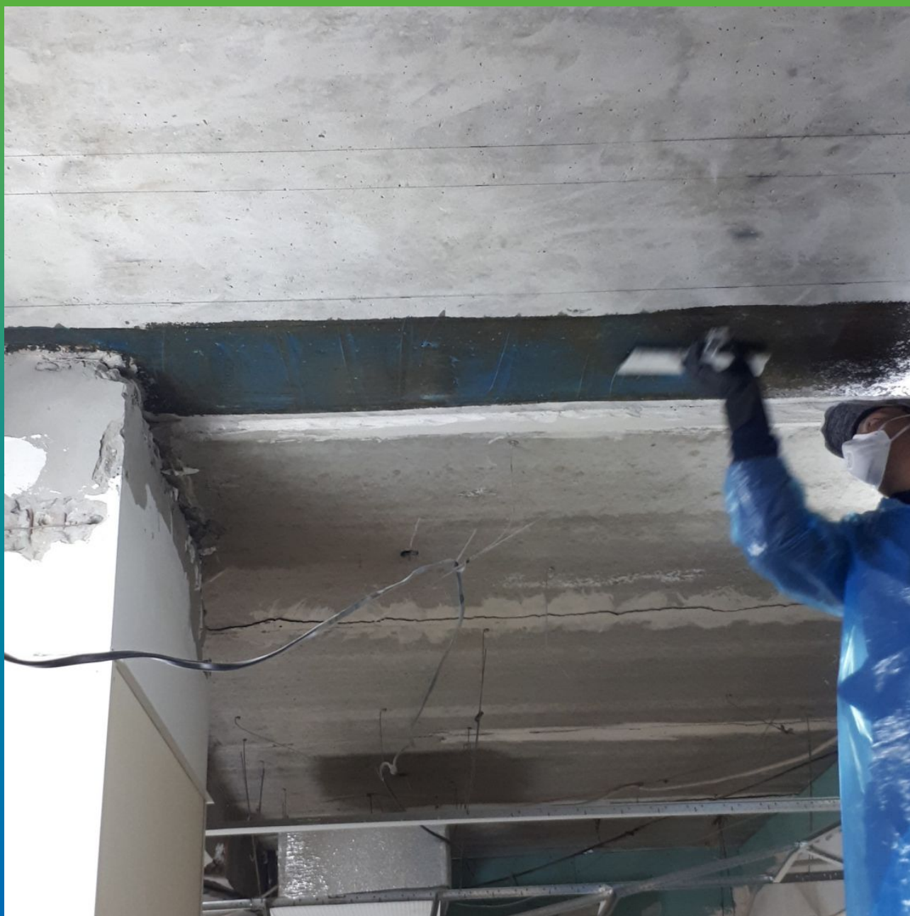
Замешивание клея Манопокс 372 с загустителем Манопокс Тикс
