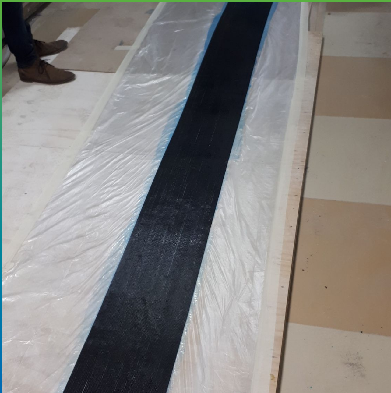
Пропитывание клеем Манопокс 372 холста Армошел КВ 200
