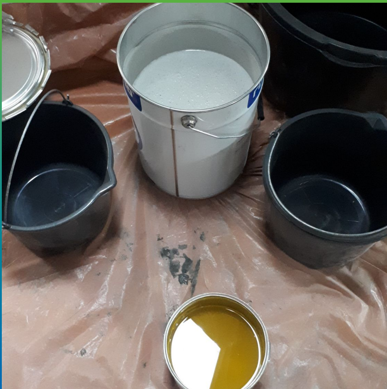
Приготовление грунтовки для огнезащиты Пирошел Бонд
