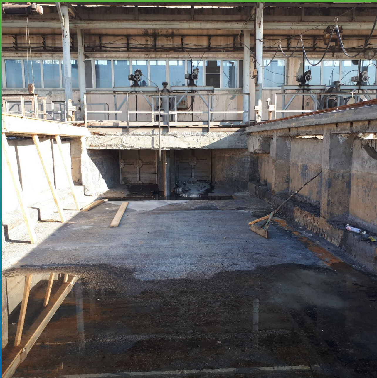
Состояние песколовки до ремонтных работ
