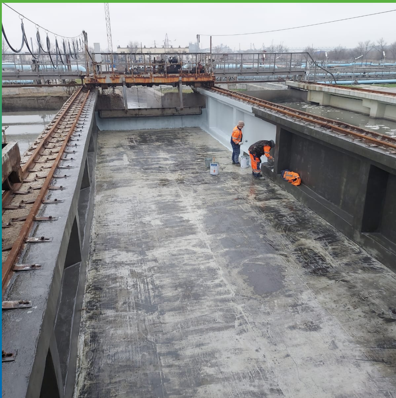
Нанесение эпоксидного водонепроницаемого состава ДенТоп ЭП 202
