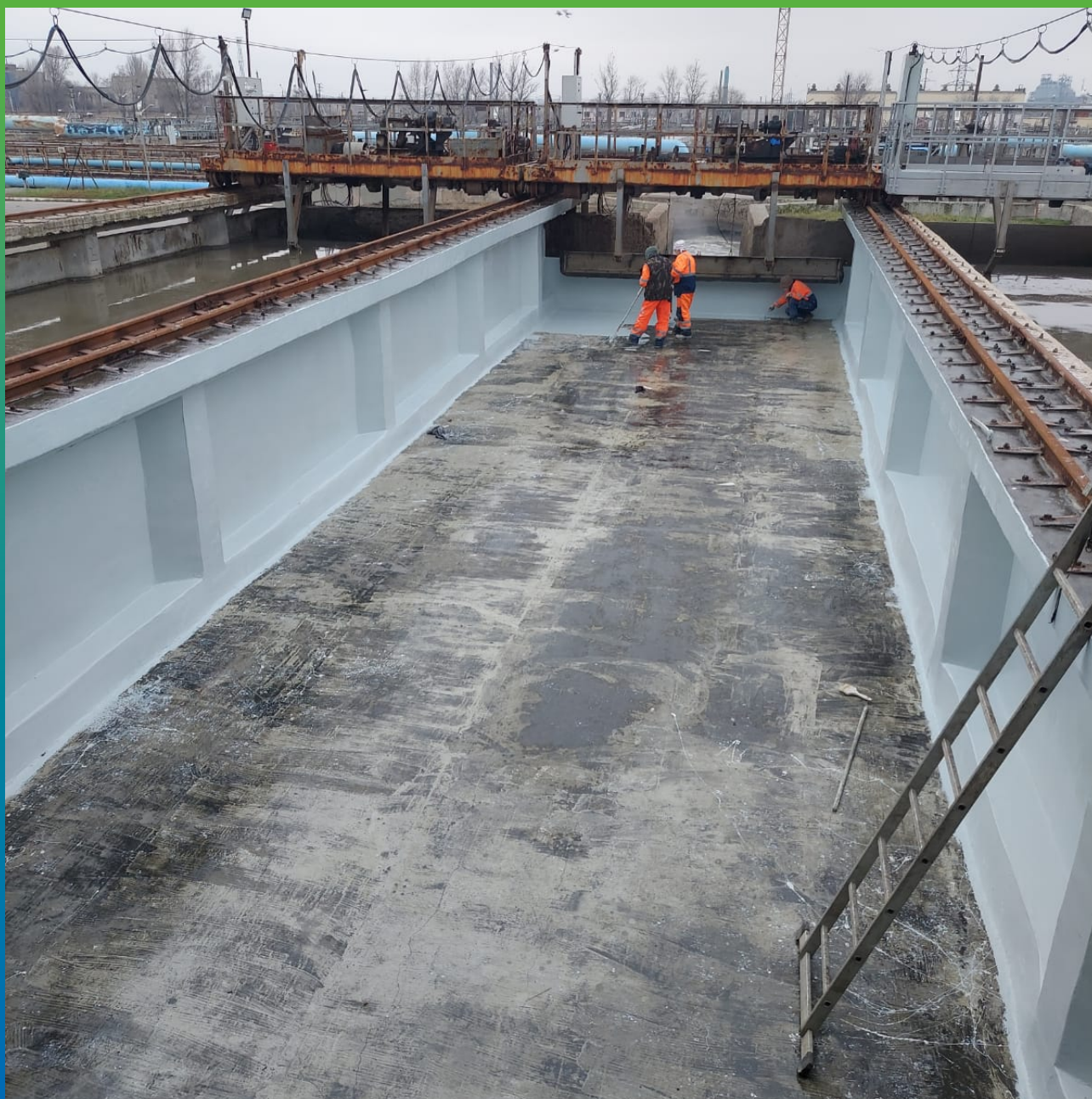
Нанесение эпоксидного состава ДенсТоп ЭП 202
