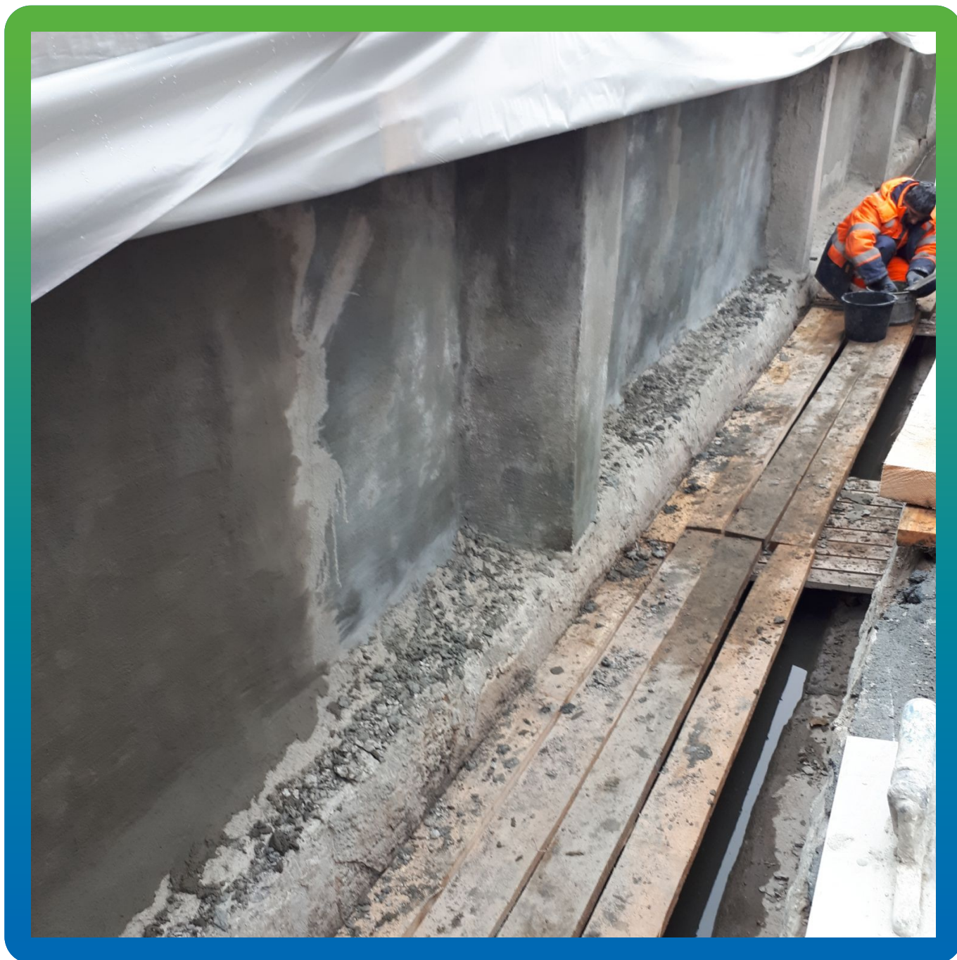
Отремонтированная составом Стармекс РМЗ стена
