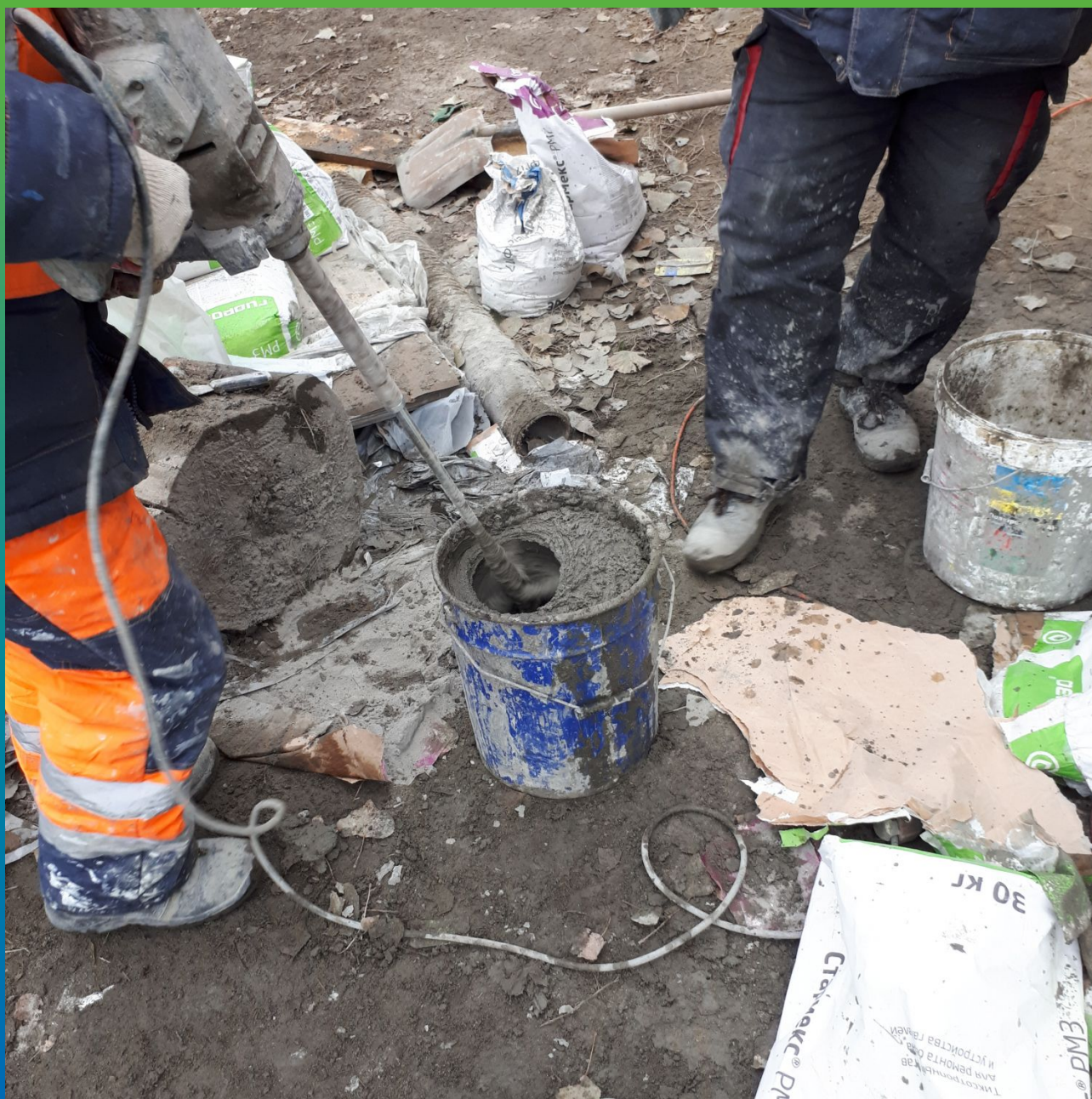
Приготовление ремсостава Стармакс РМ3
