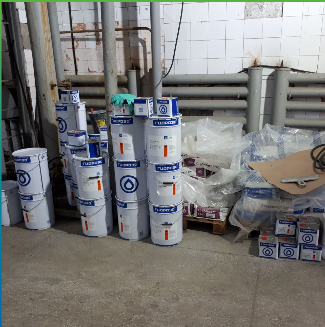
Материалы Гидрозо на объекте
