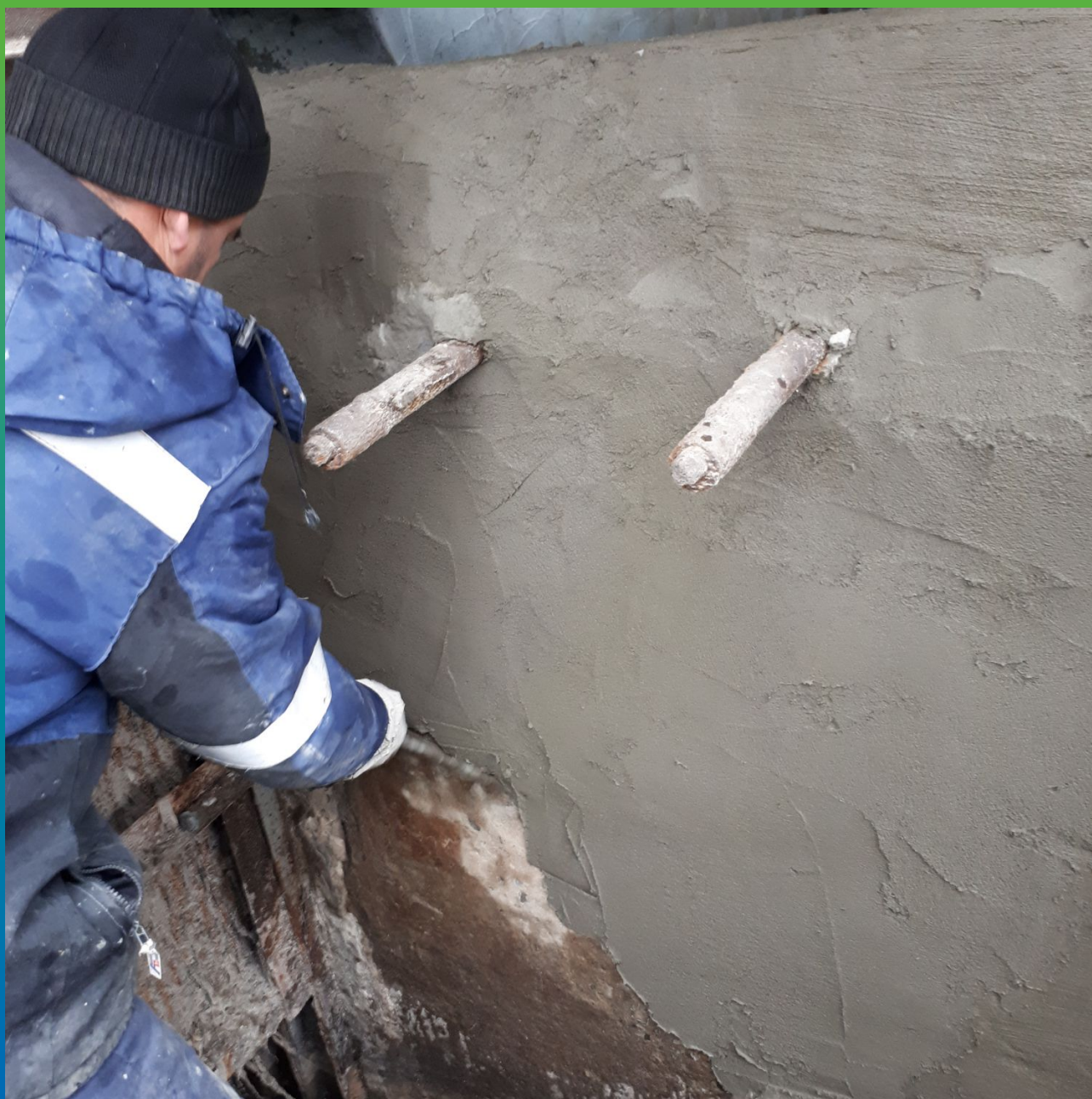
Ремонт стен составом Стармекс РМЗ
