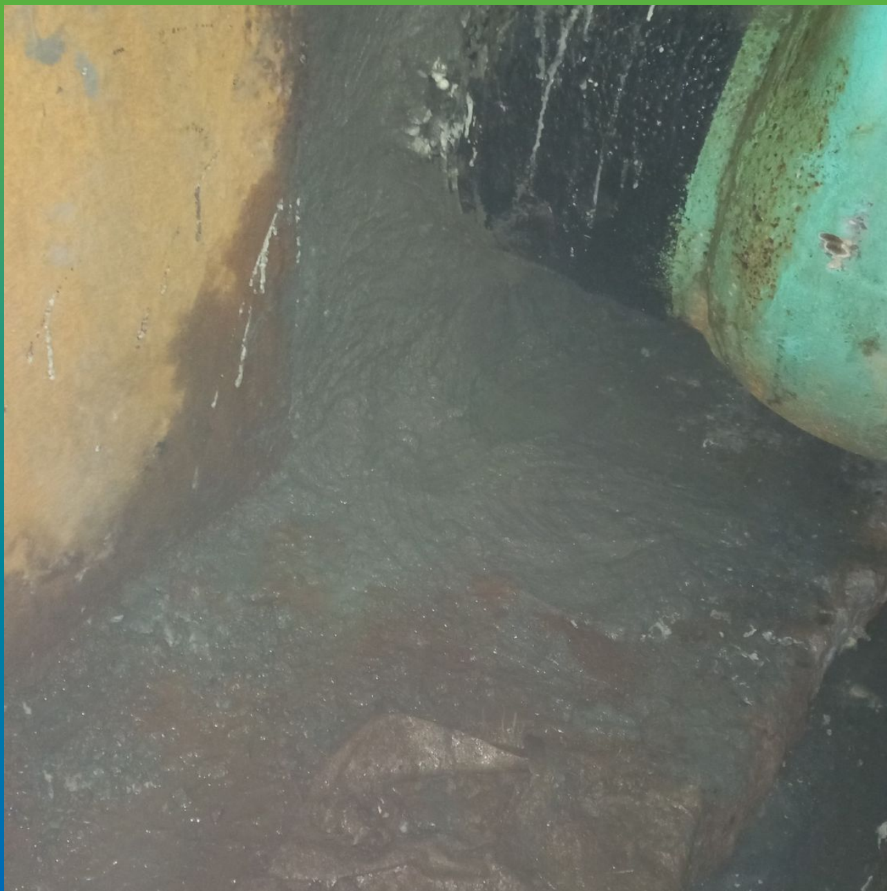
Ввод герметизирован Стармекс Плаг и Манопур 15
