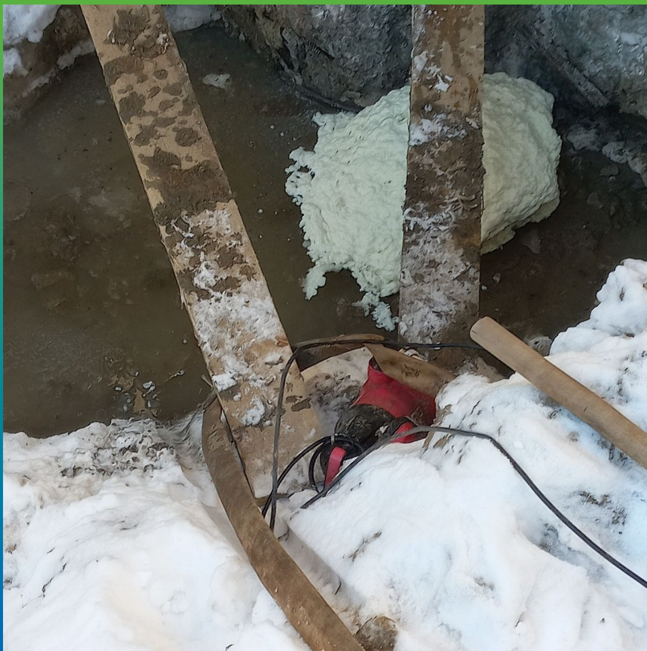
Манопур 15 в полимеризовавшемся виде. Протечка остановлена.
