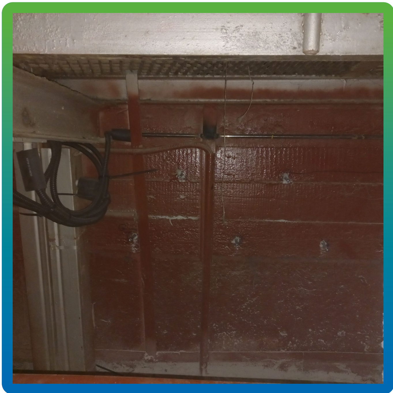
Установка пакеров в соответствии с техническим решением.
