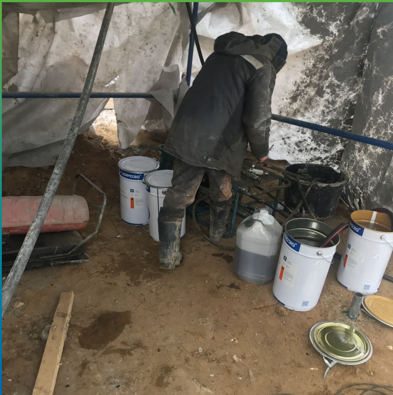
Подготовка к инъектированию Манопур 207
