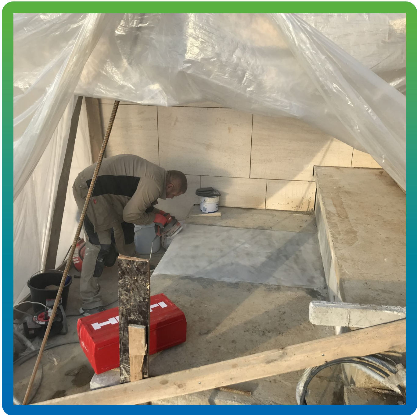
Шлифовка и выравнивание нанесенного ремонтного состава Стармекс РМ2
