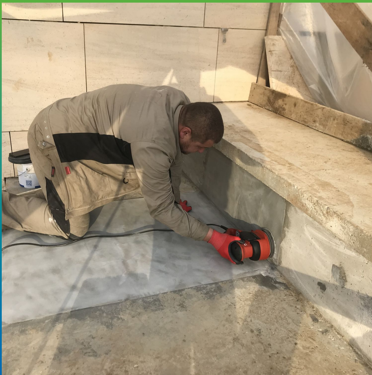
Шлифовка основания перед нанесение ДенсТоп АК 220
