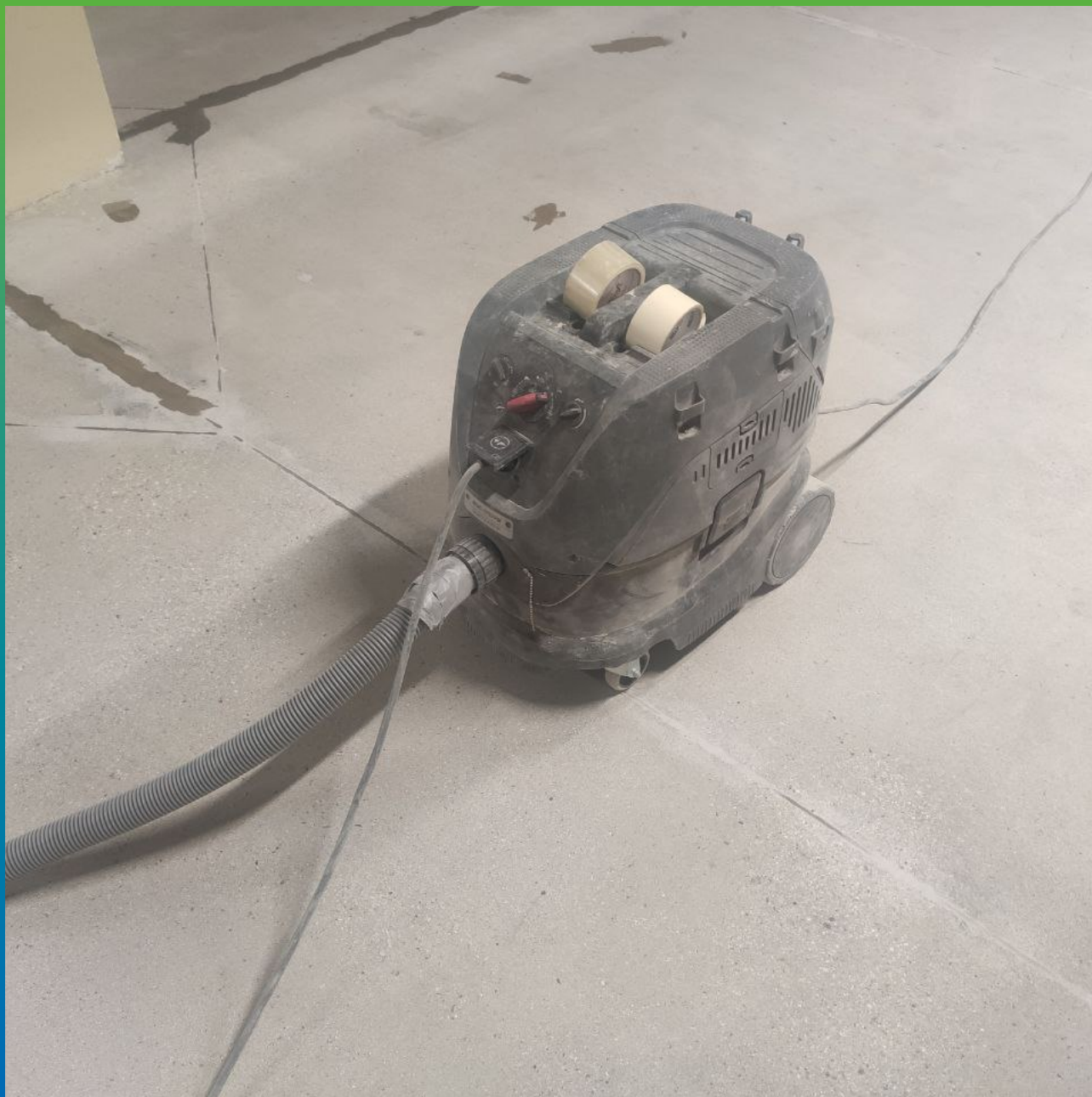
Нарезка штроб и подготовка основания
