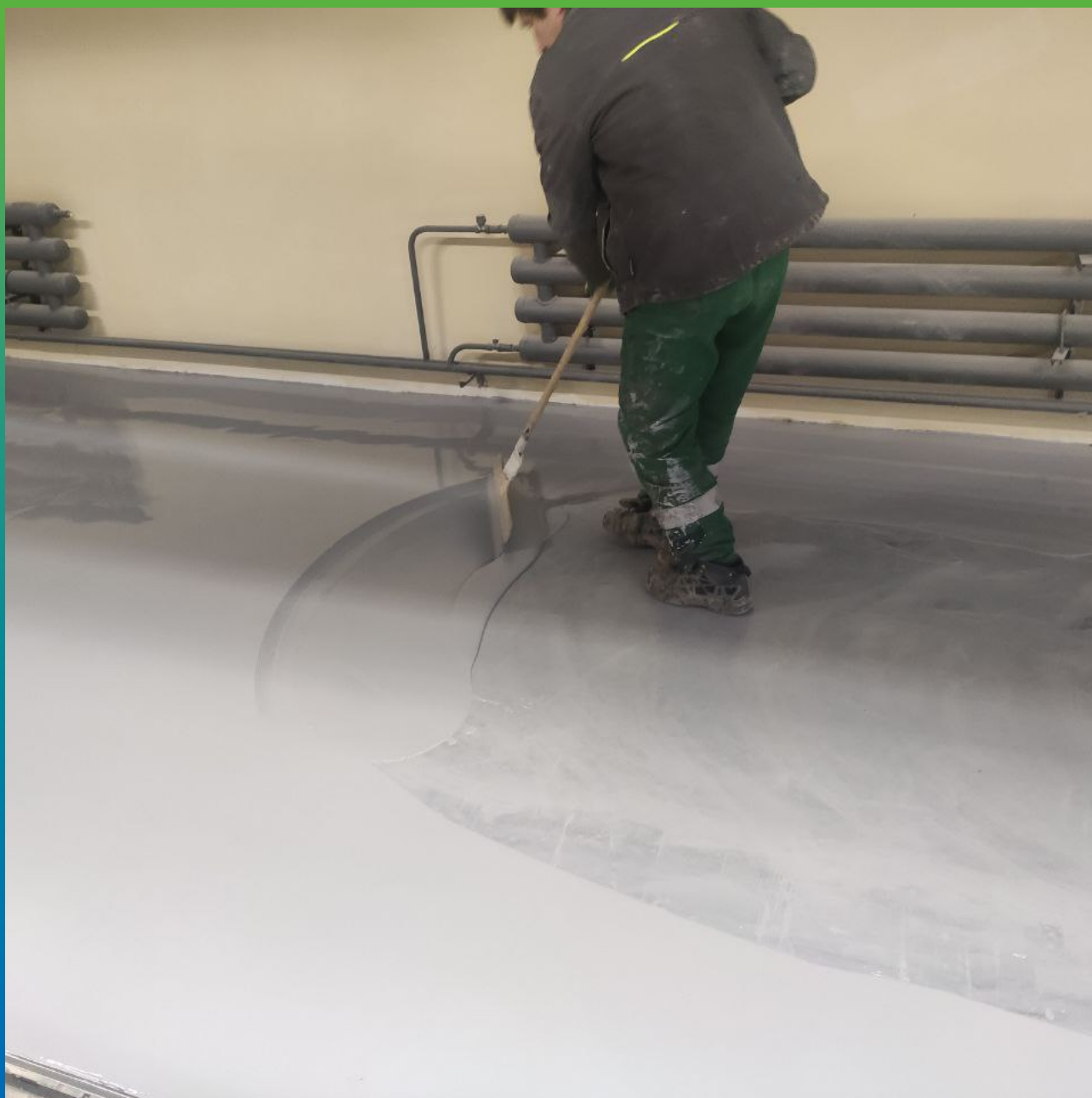
Распределение состава по поверхности
