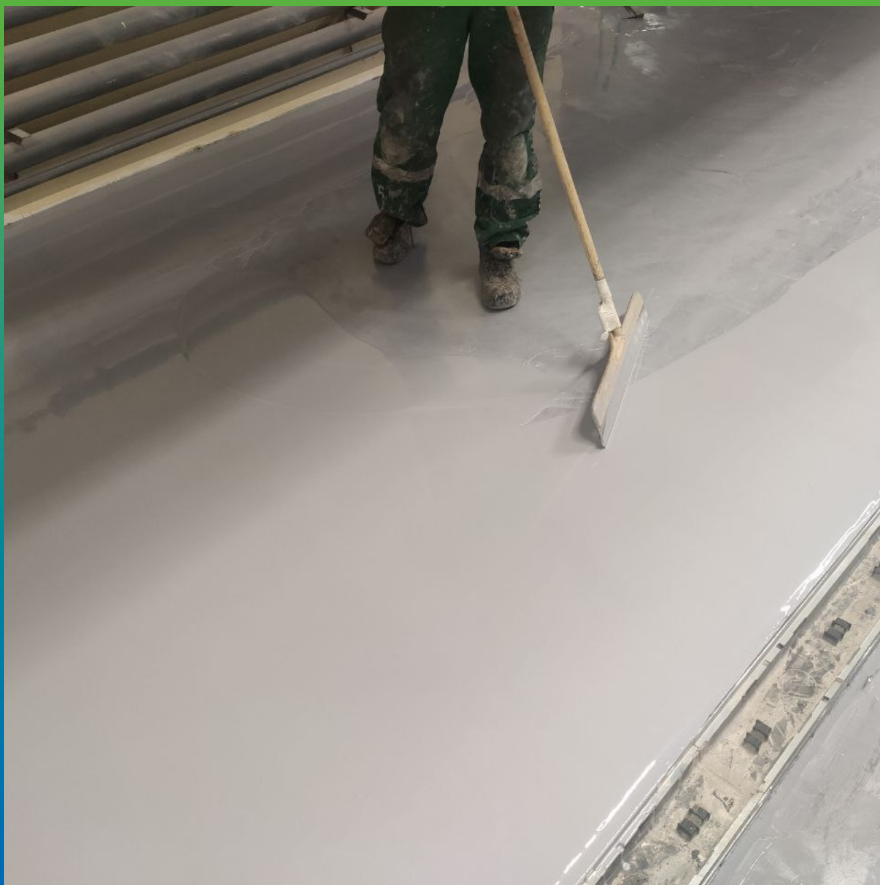
Распределение состава по поверхности с помощью ракли
