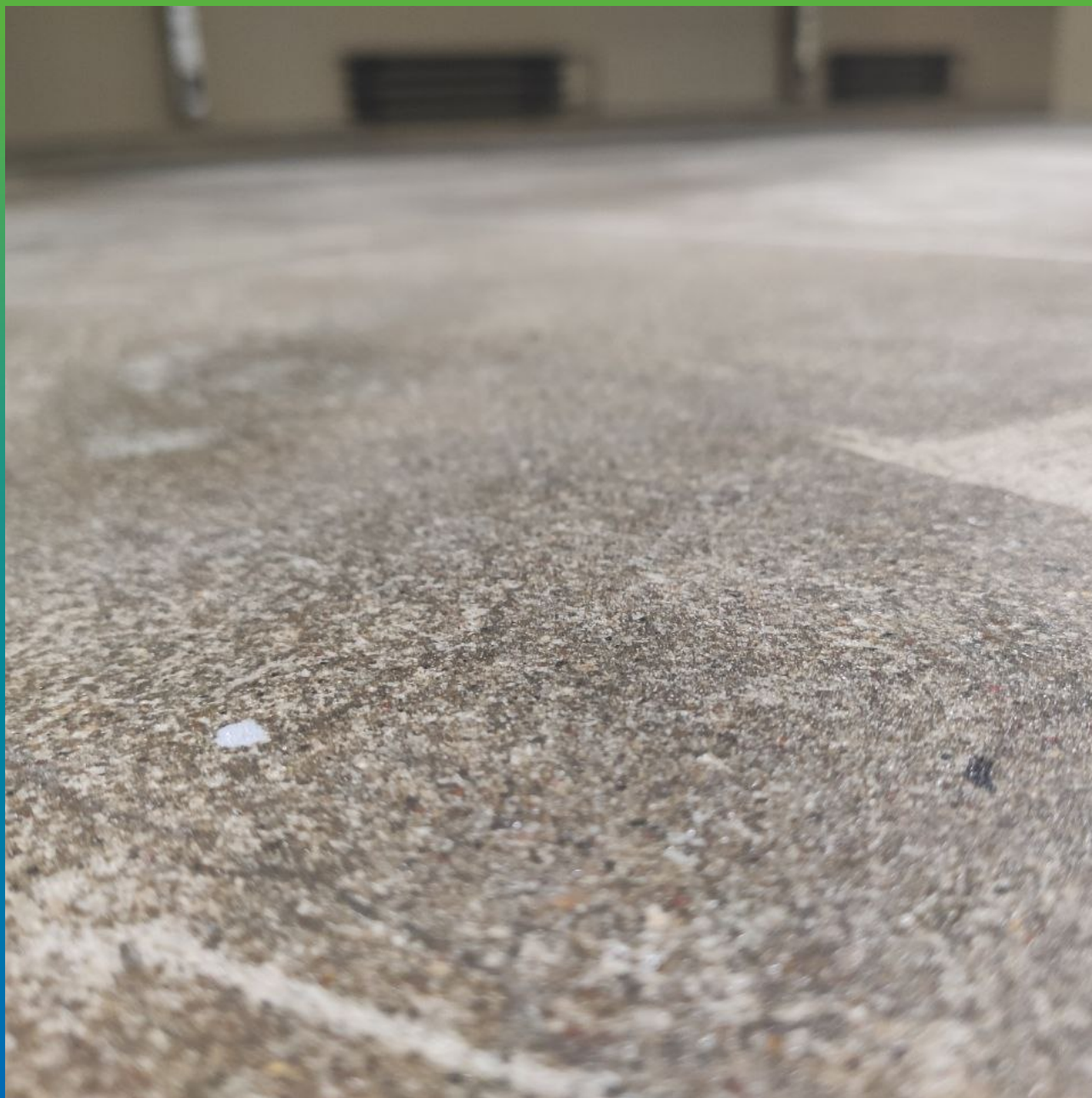
Внешний вид грунтовки с песком
