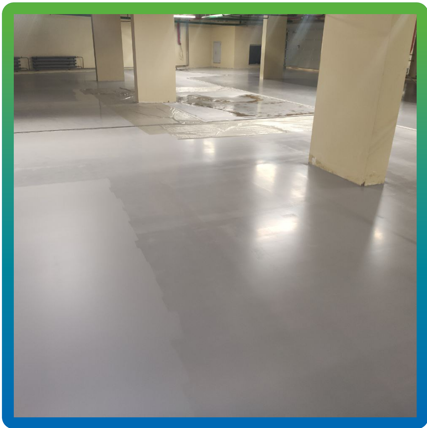
Сравнение поверхностей с матовым лаком и без лака
