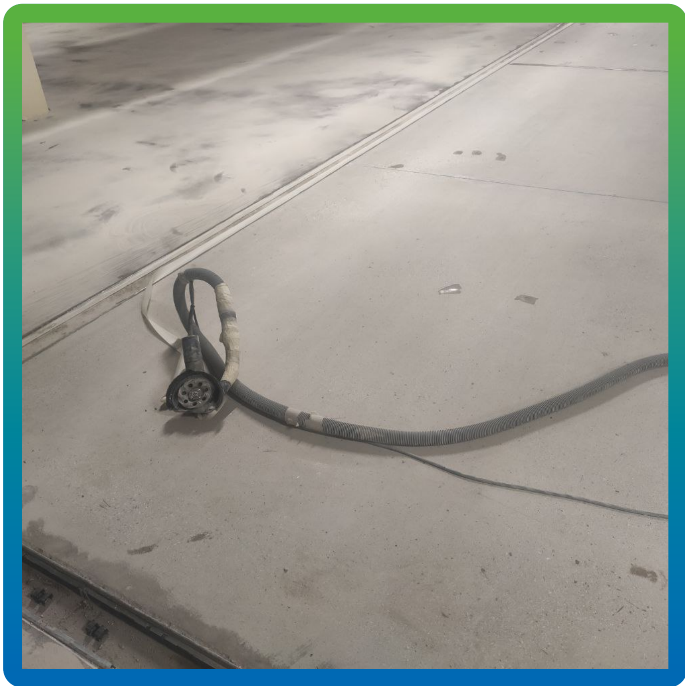
Подготовка основания перед нанесением грунтовочного слоя
