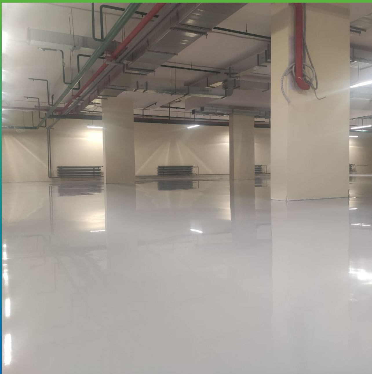
Внешний вид поверхности после укладки основного покрытия
