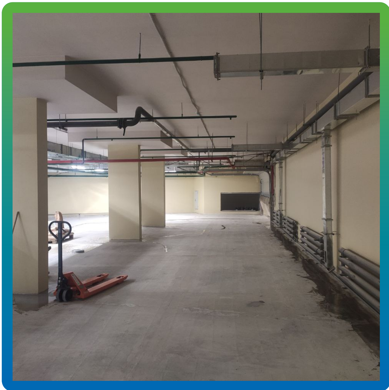
Внешний вид парковки до начала работ
