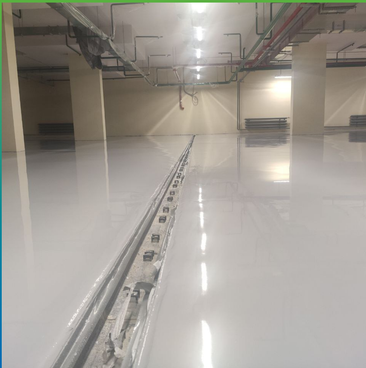
Внешний вид поверхности после укладки основного покрытия
