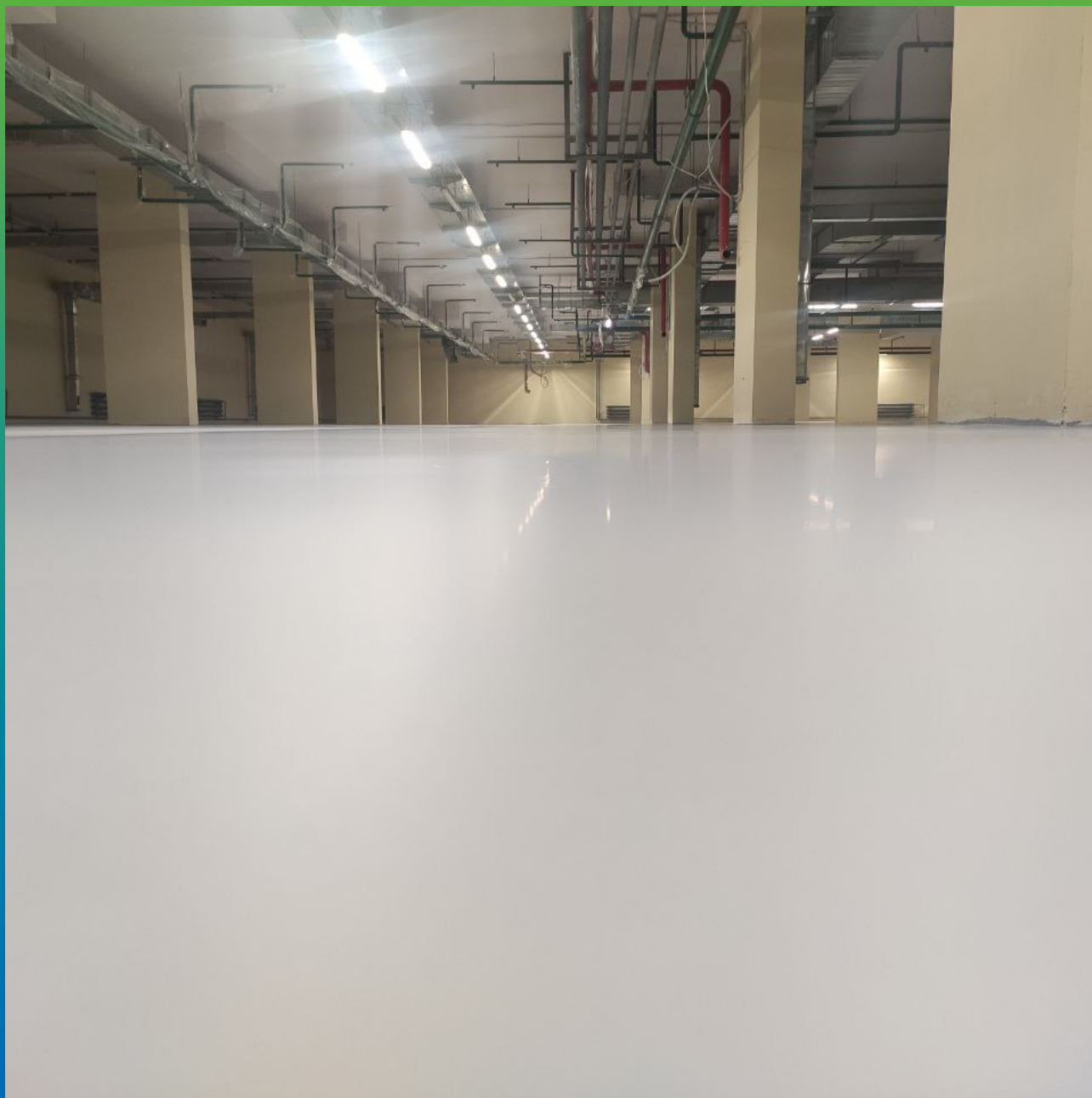
Финишный вид напольного покрытия
