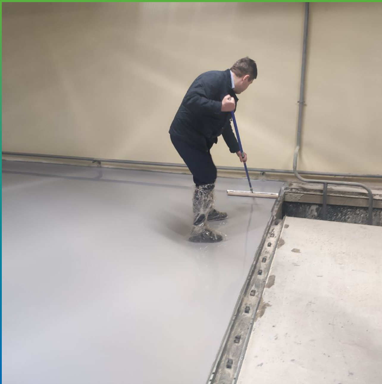
Распределение лака ДенТоп ЭП 310 по поверхности
