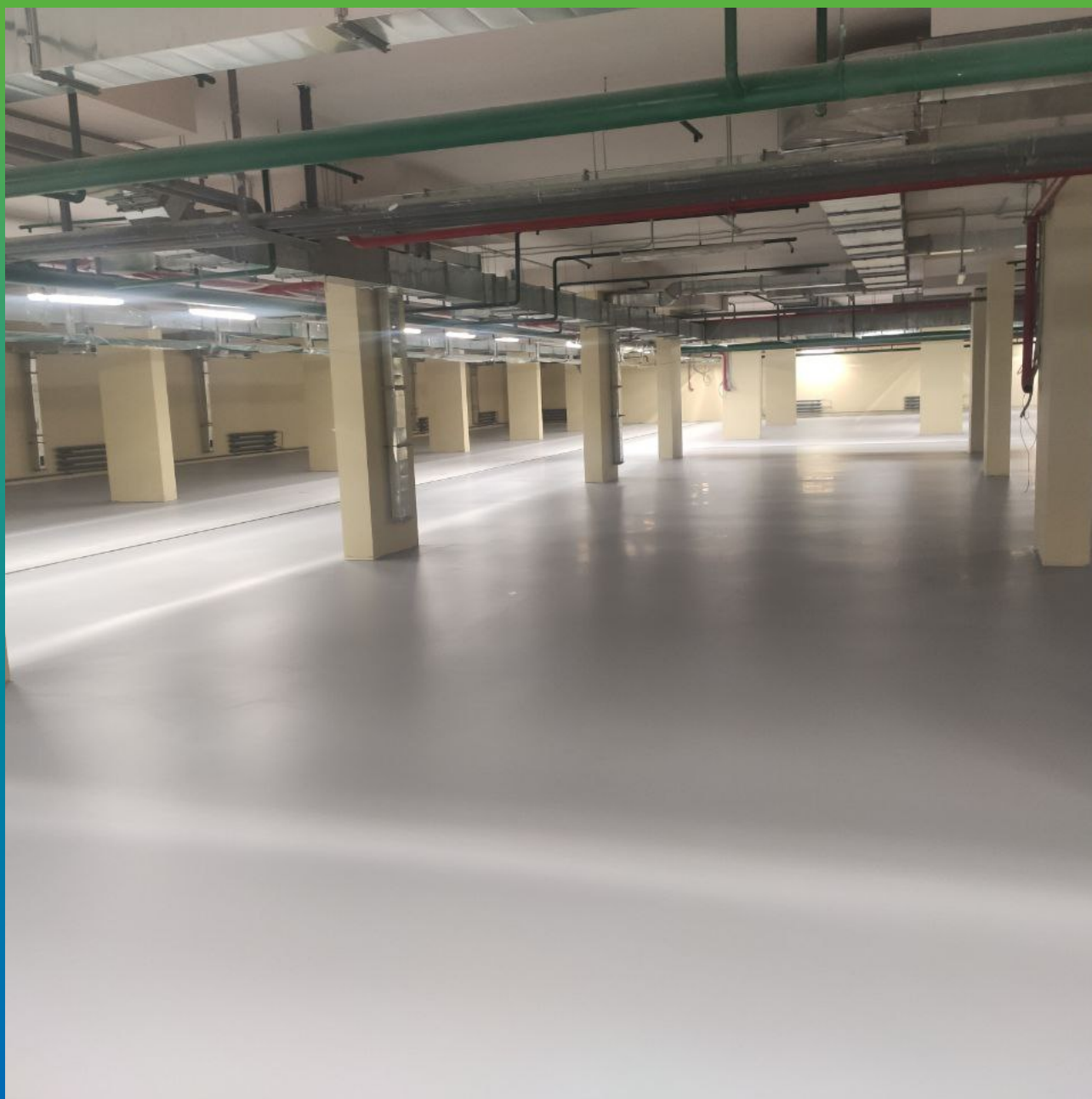
Финишный вид напольного покрытия
