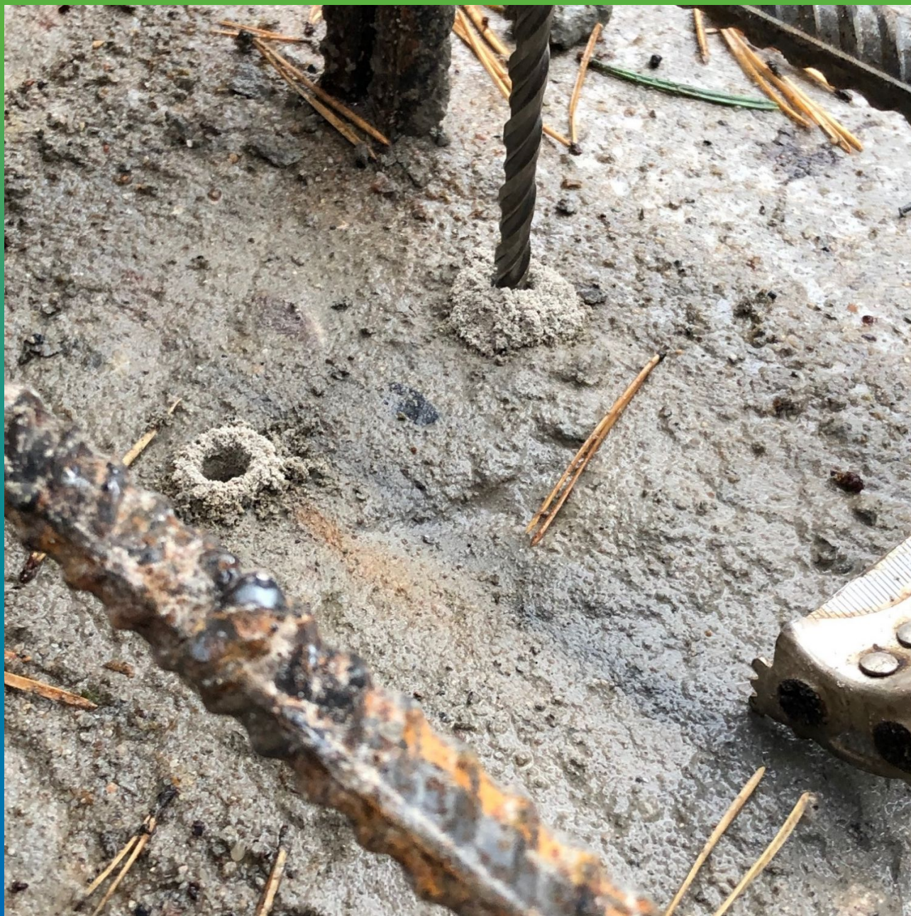
Бурение отверстий под дюбель гвозди
