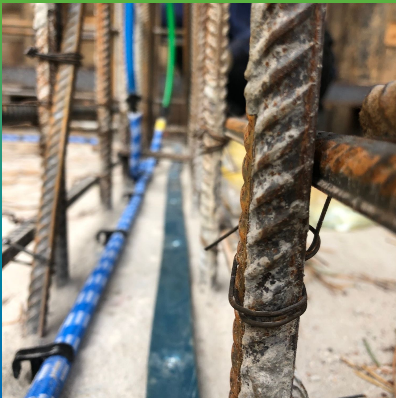
Монтаж системы Инжпайп и Манодил Свелл ХК-2507 в холодный шов бетонирования
