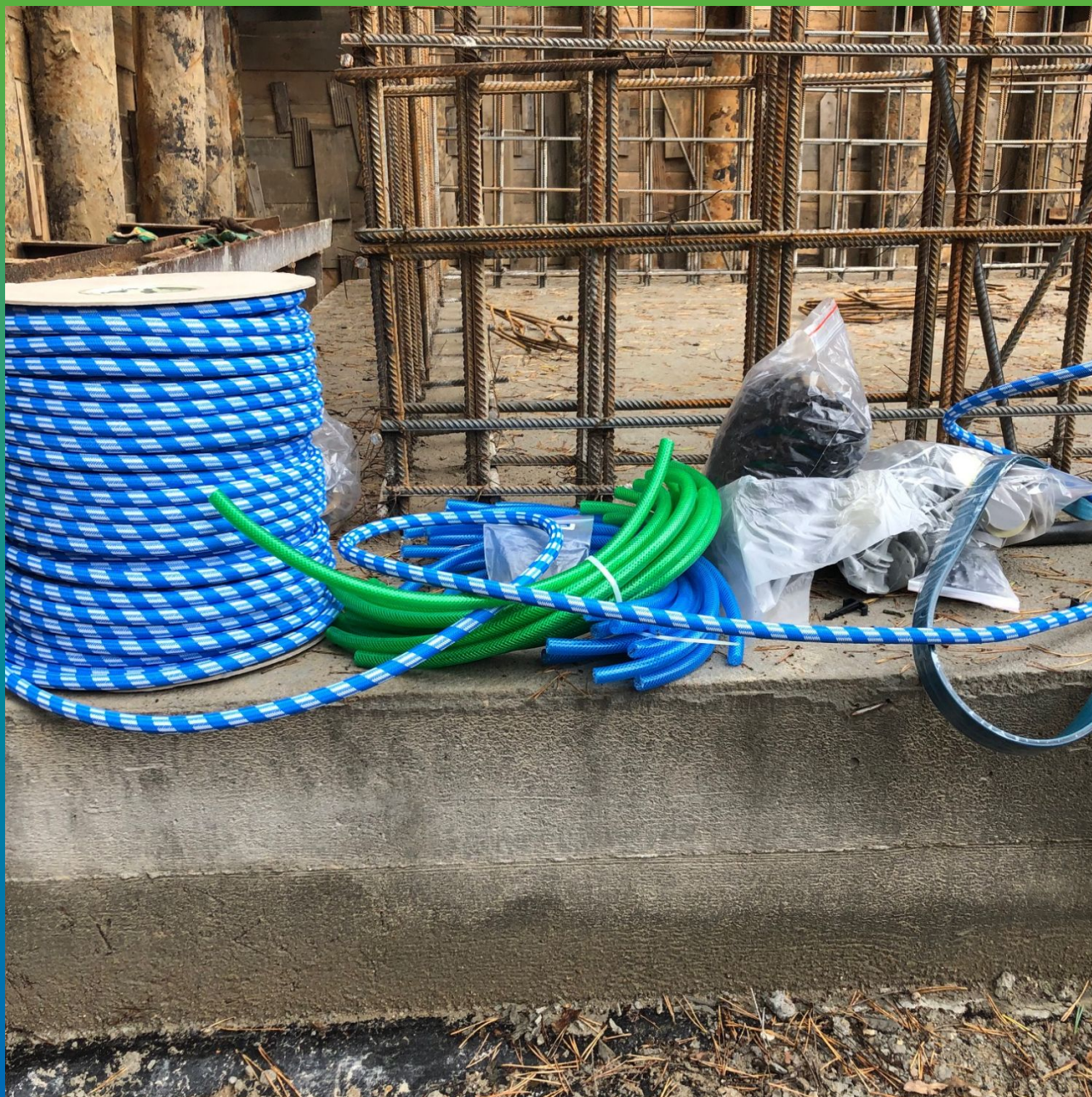
Система Инжпайп на объекте
