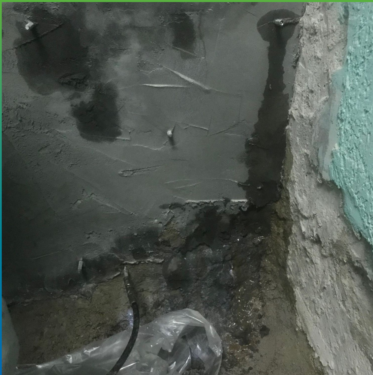
Последовательная закачка Манокрил Гель Р в пакера
