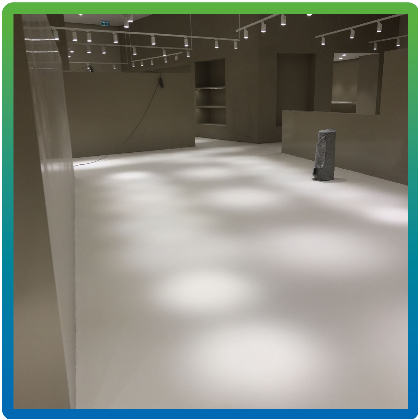
Общий вид покрытия Стармекс ФФ до покрытия защитного слоя Маногард Топ 115
