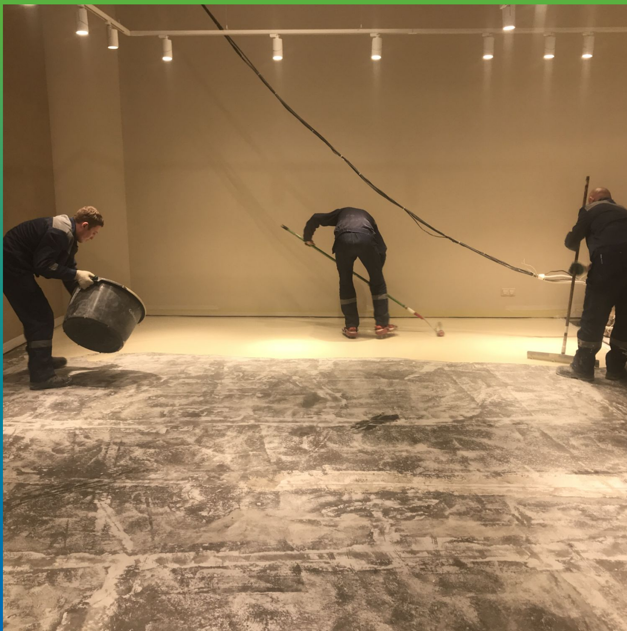
Нанесение состава Стармекс ФФ на поверхность
