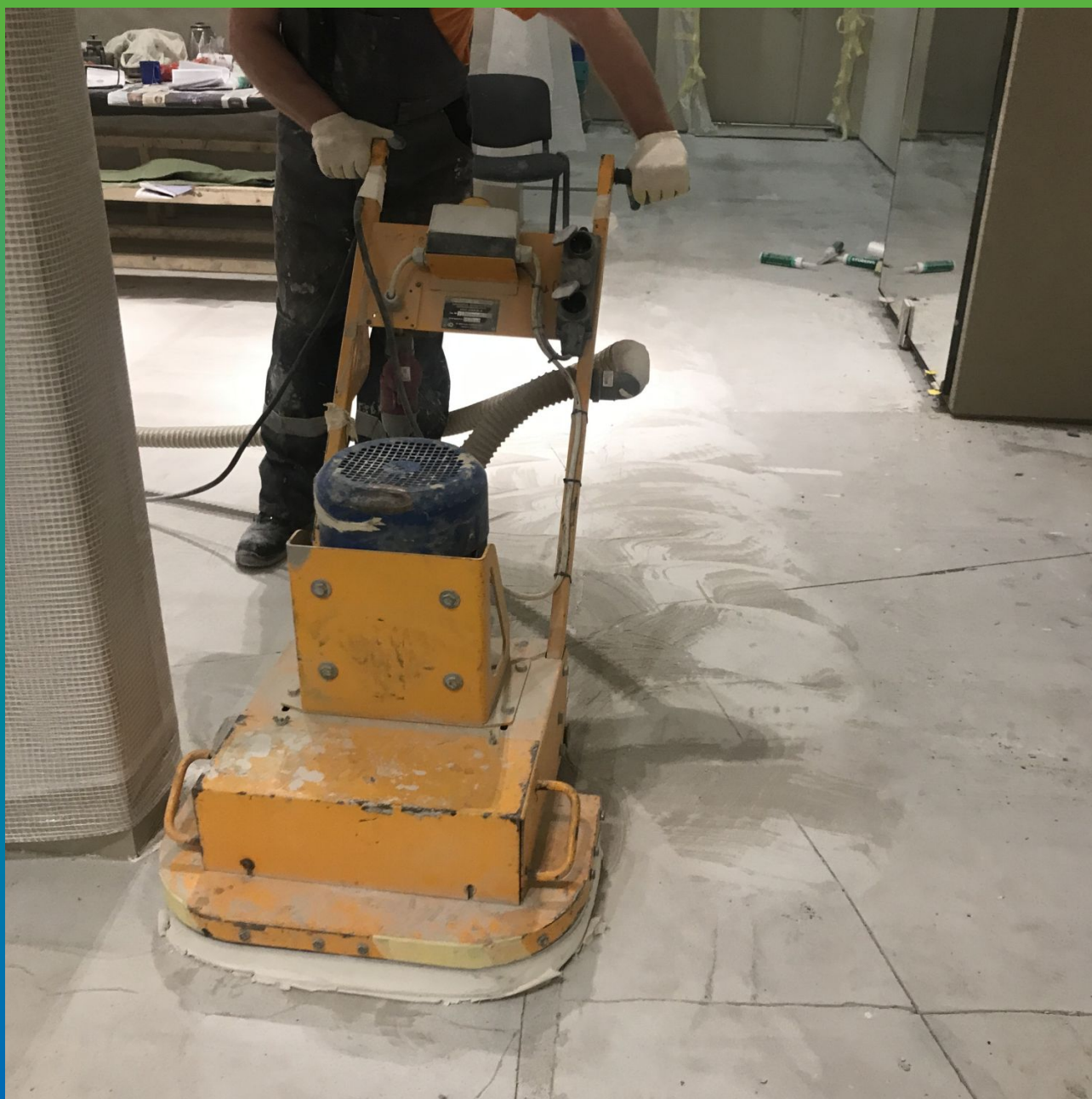
Подготовка поверхности бетона с помощью шлифовальной машины
