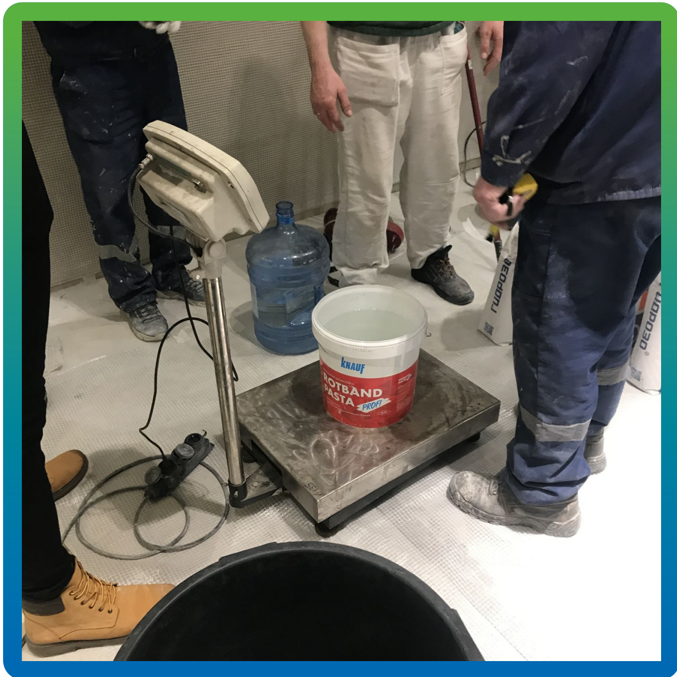
Весовой контроль в соотношении воды с сухой смесью
