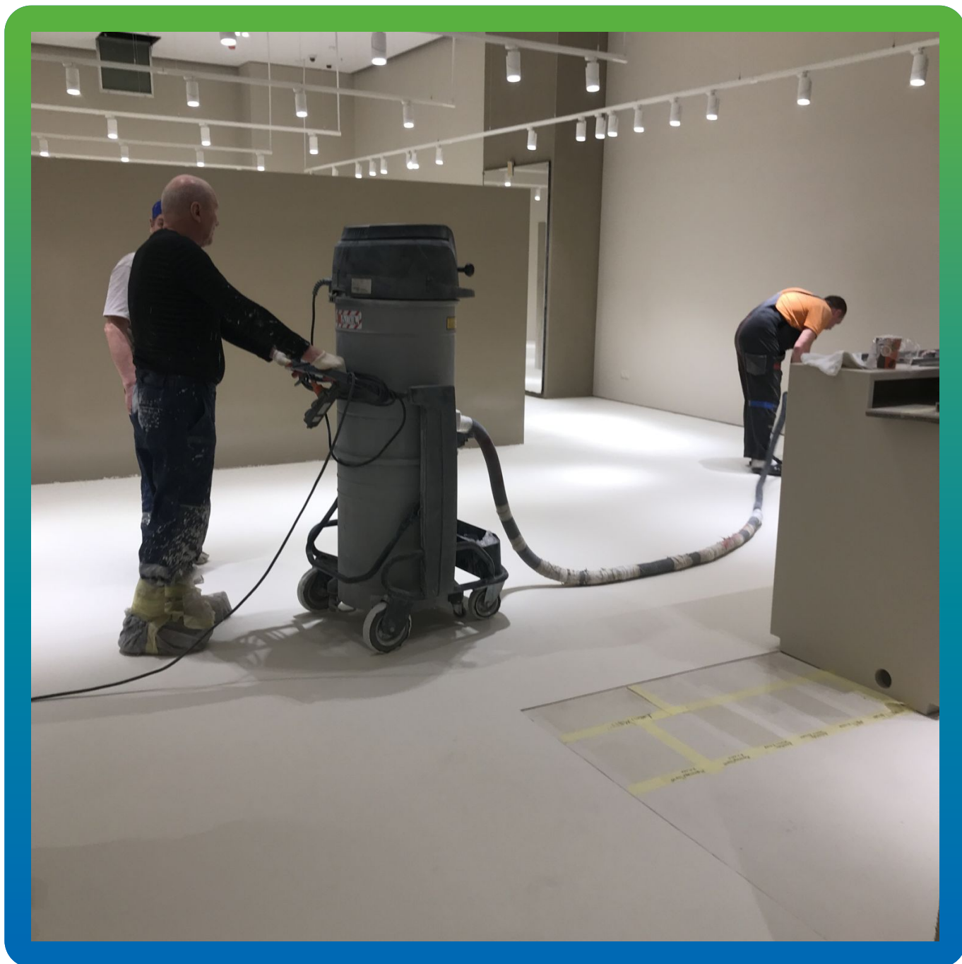
Обеспыливание поверхности перед нанесением пропитки Маногард Топ 115
