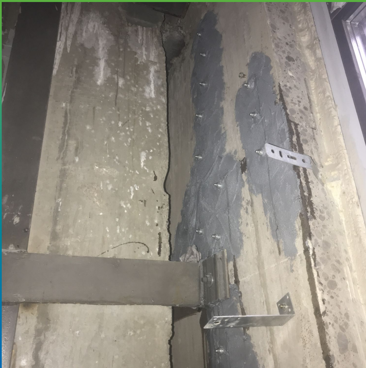
Общий вид стены после инъектирования
