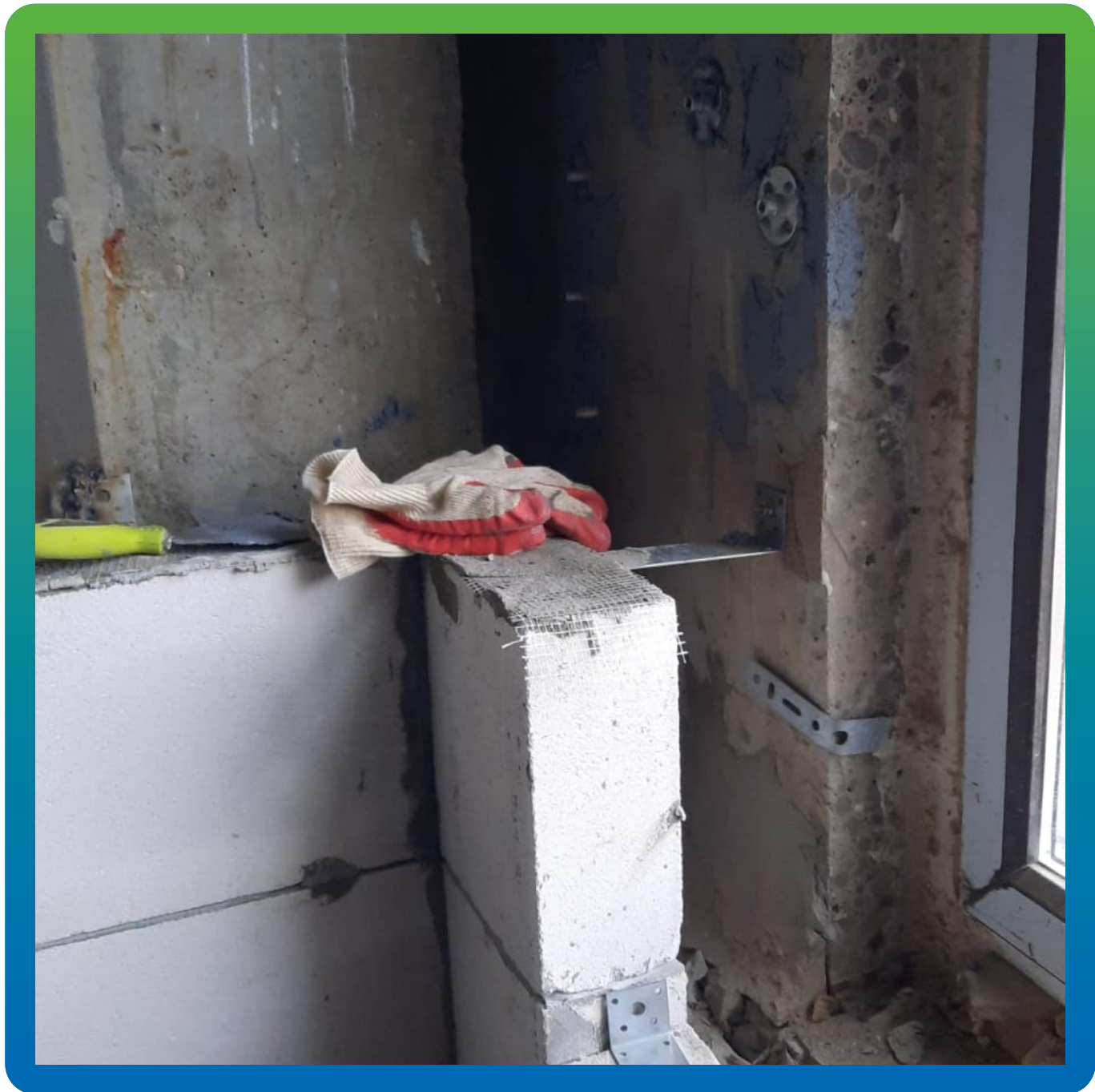
Подготовка трещины к инъектированию Манопокс 331
