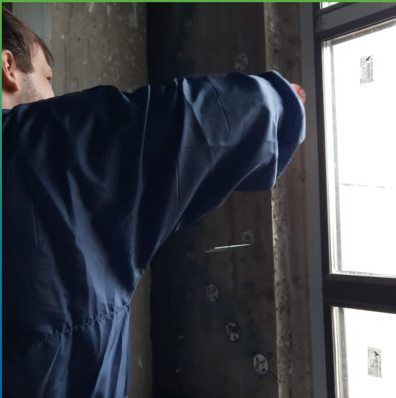
Монтаж адгезионных пакеров БМ 0189
