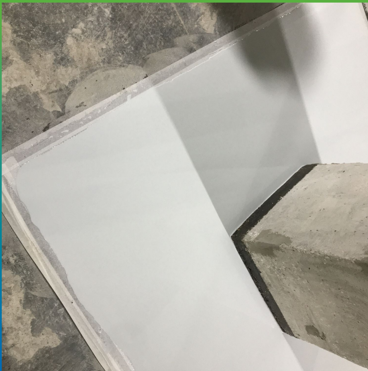
Финишный вид нанесенного покрытия ДенТоп ЭП 500
