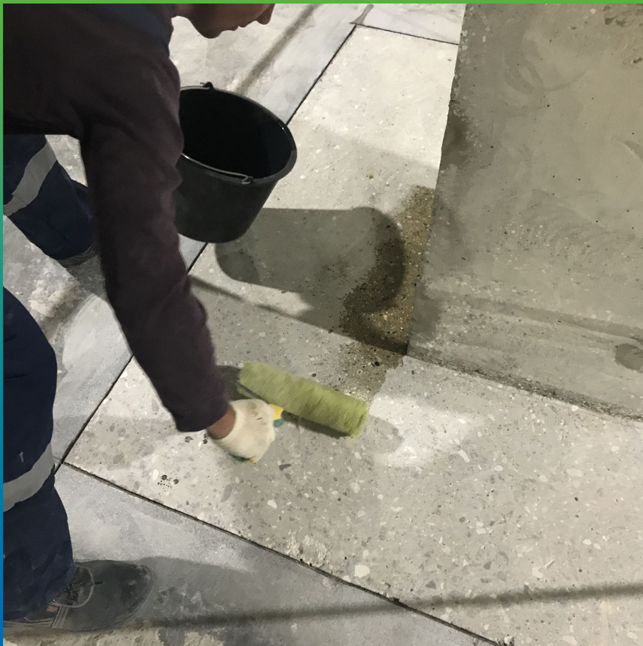
Нанесение грунтовочного состава ДенсТоп ЭП 100
