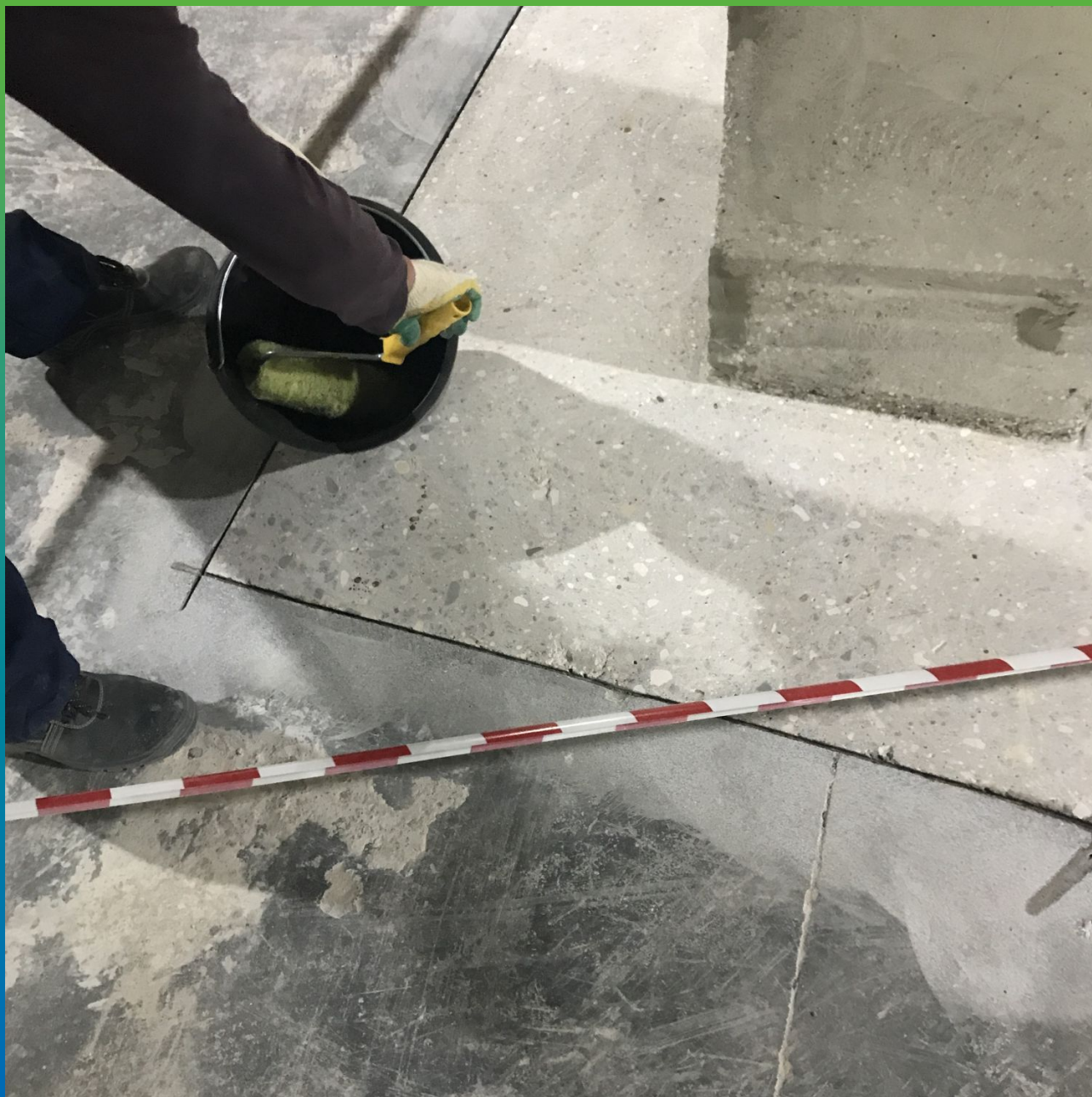
Подготовка основания к нанесению грунтовки ДенТоп ЭП 100
