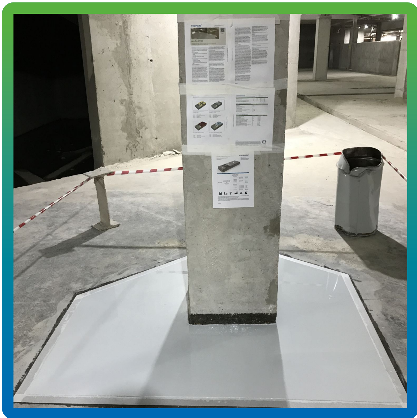
Общий вид покрытия ДенсТоп ЭП 500
