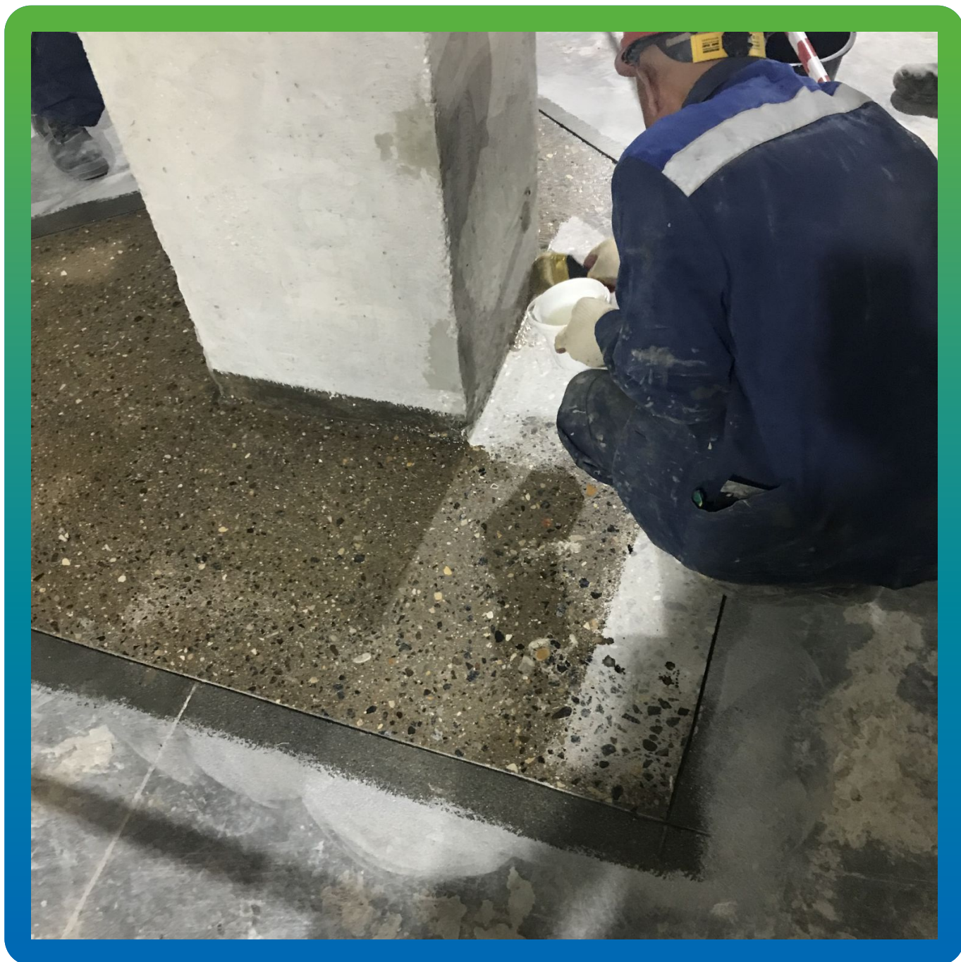
Нанесение основного слоя ДенсТоп ЭП 500
