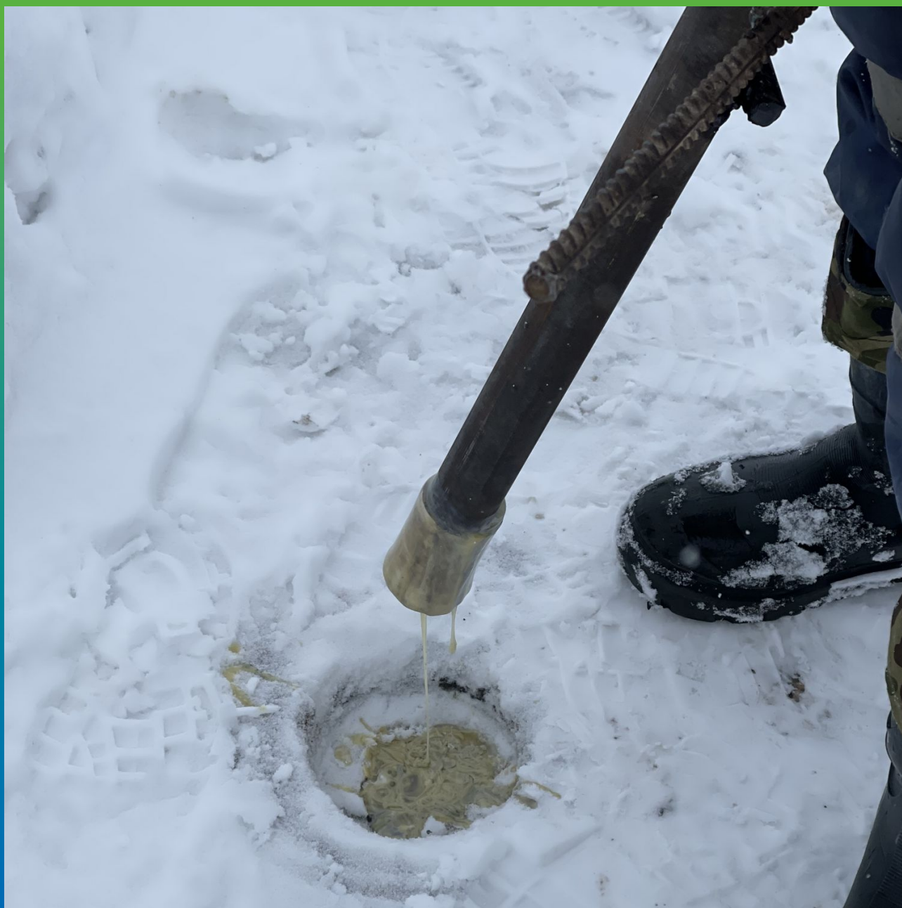
Извлечение инъекционного пакера после инъецирования
