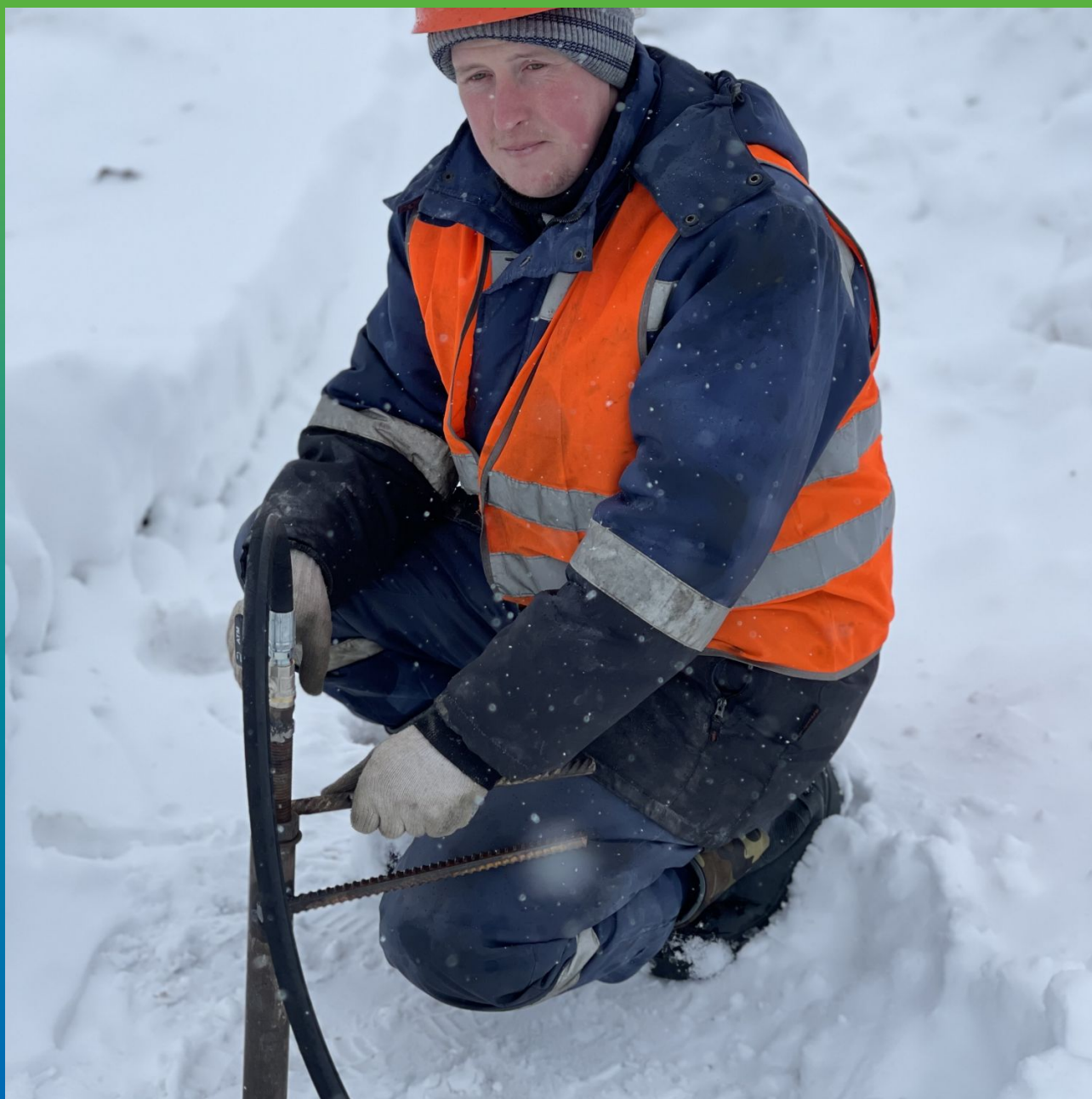
Проведение инъектирования
