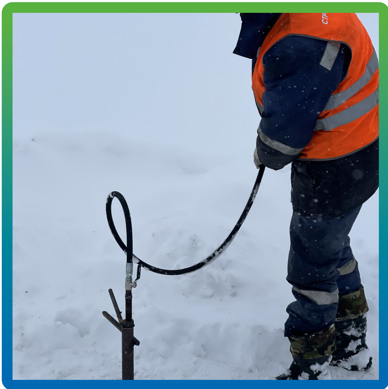
Проведение инъектирования
