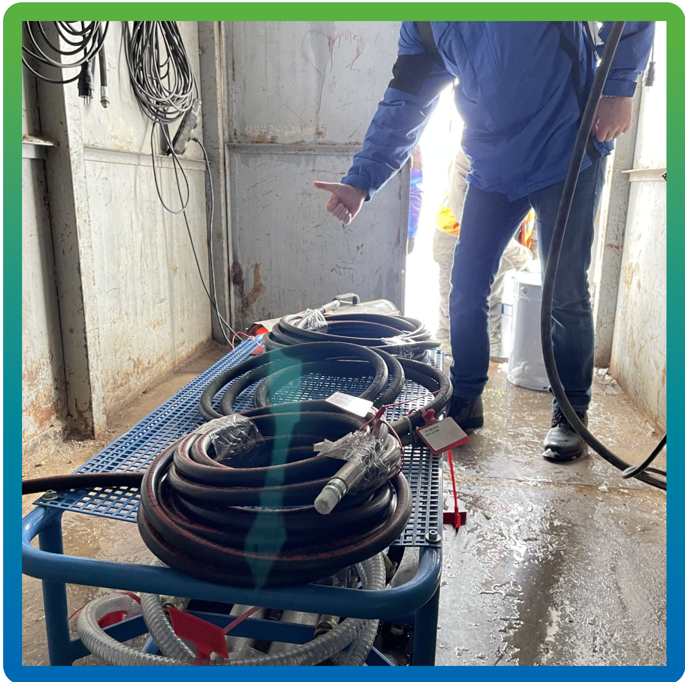
Насос БМ 1429 на объекте
