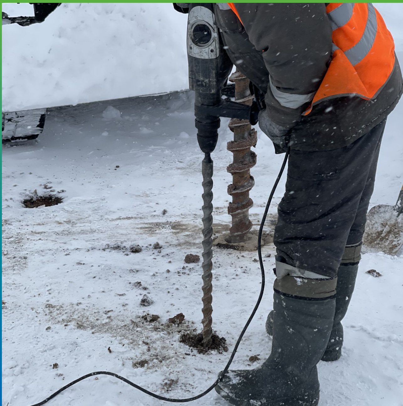
Бурение инъекционных скважин
