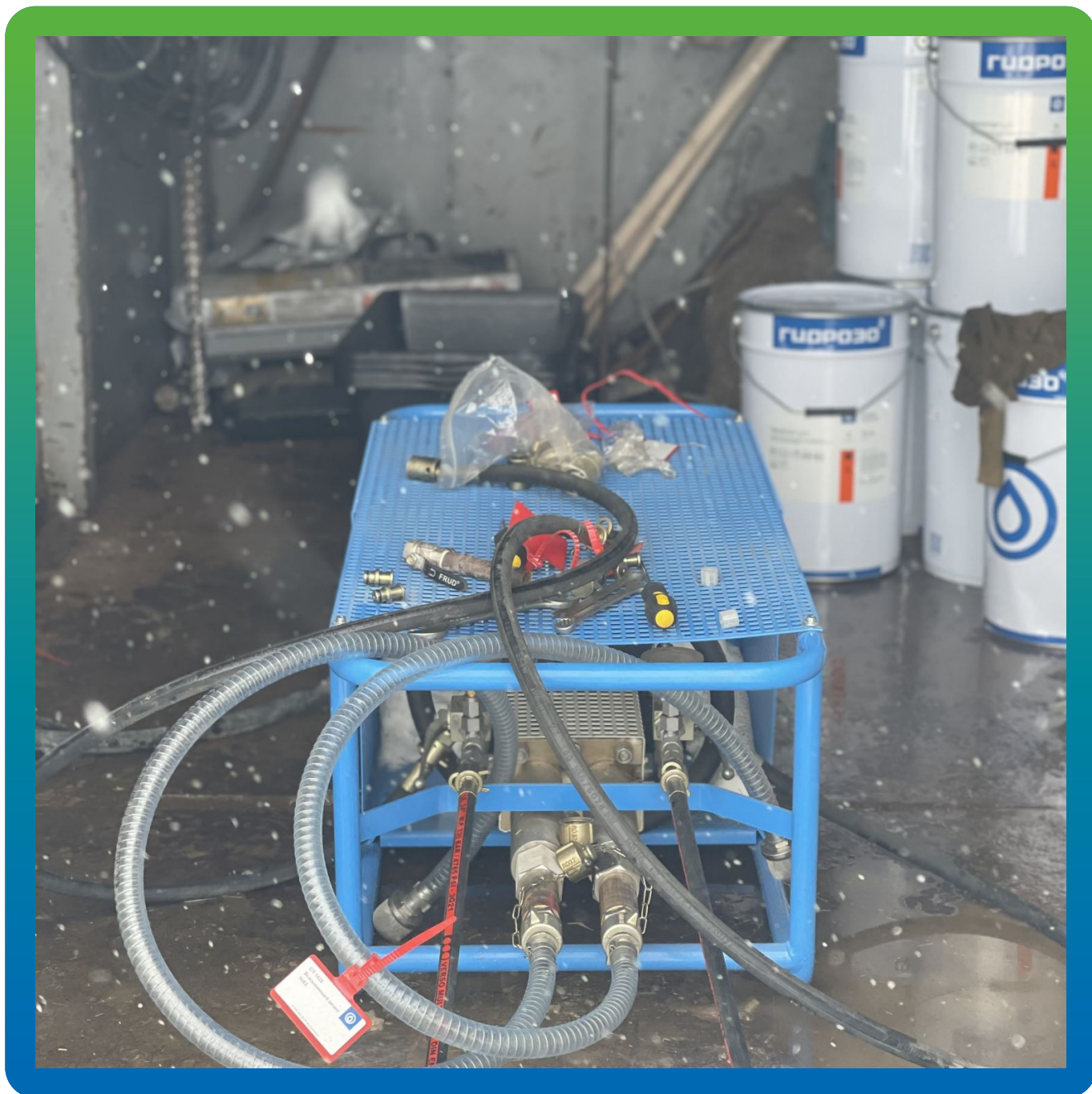
Насос БМ 1429 на объекте
