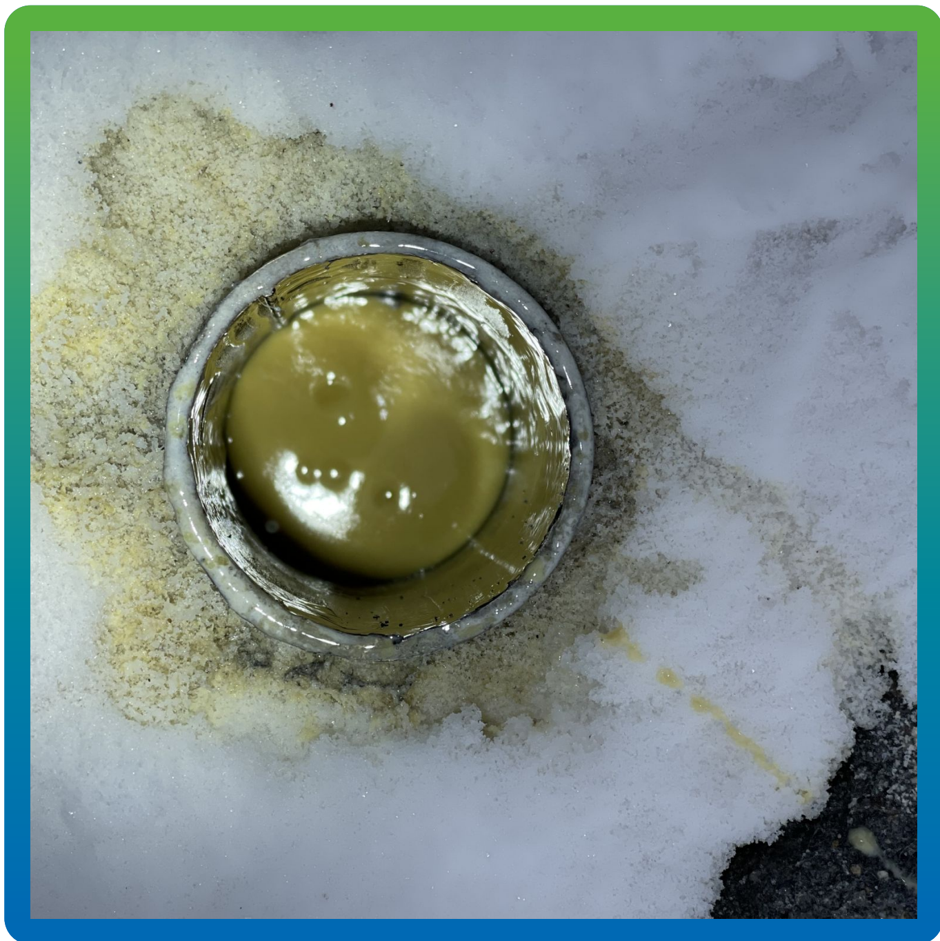
Материал Манопур 127 в инъекционном канале
