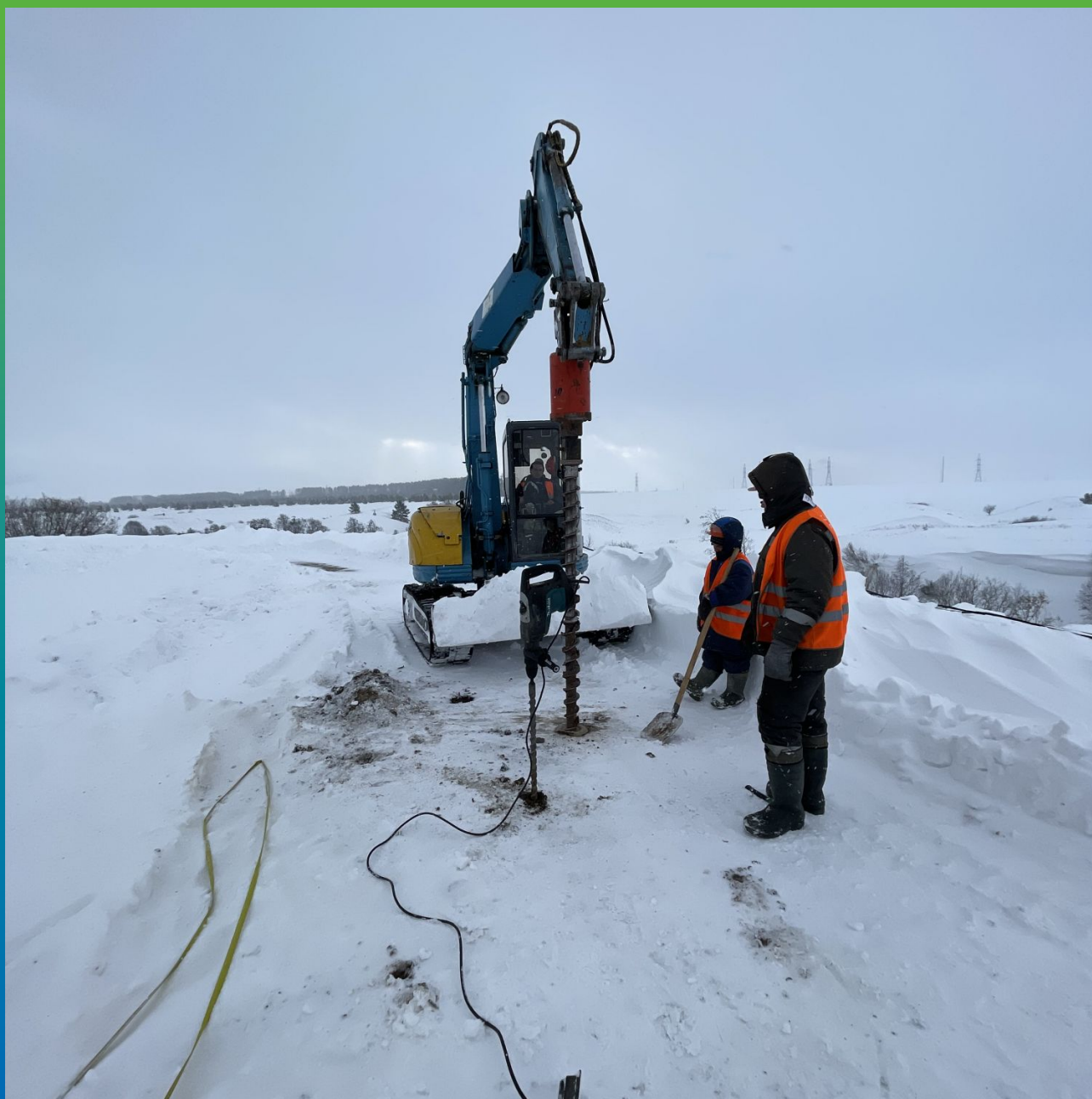
Бурение инъекционных скважин
