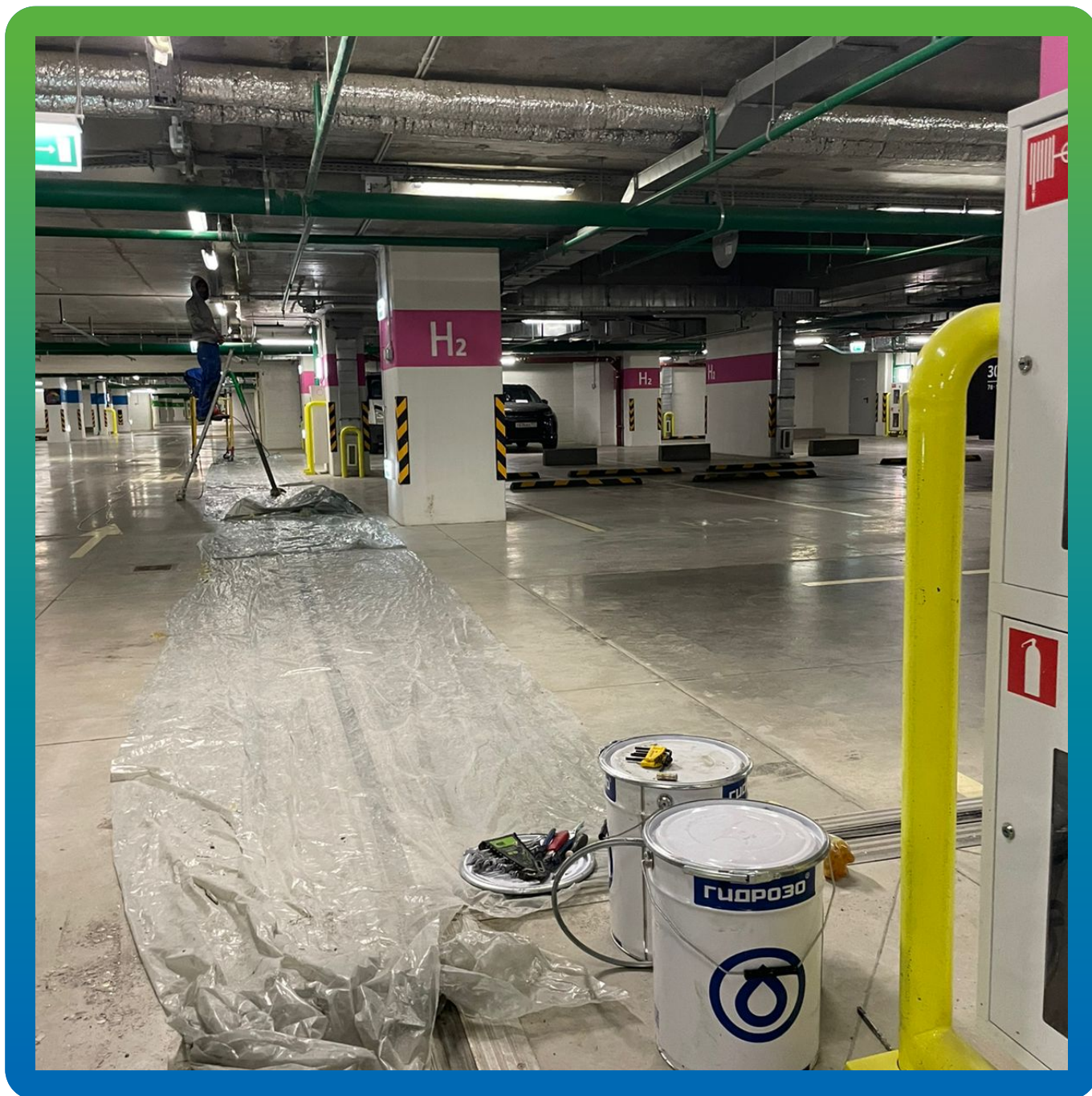
Проведение работ по инъектированию
