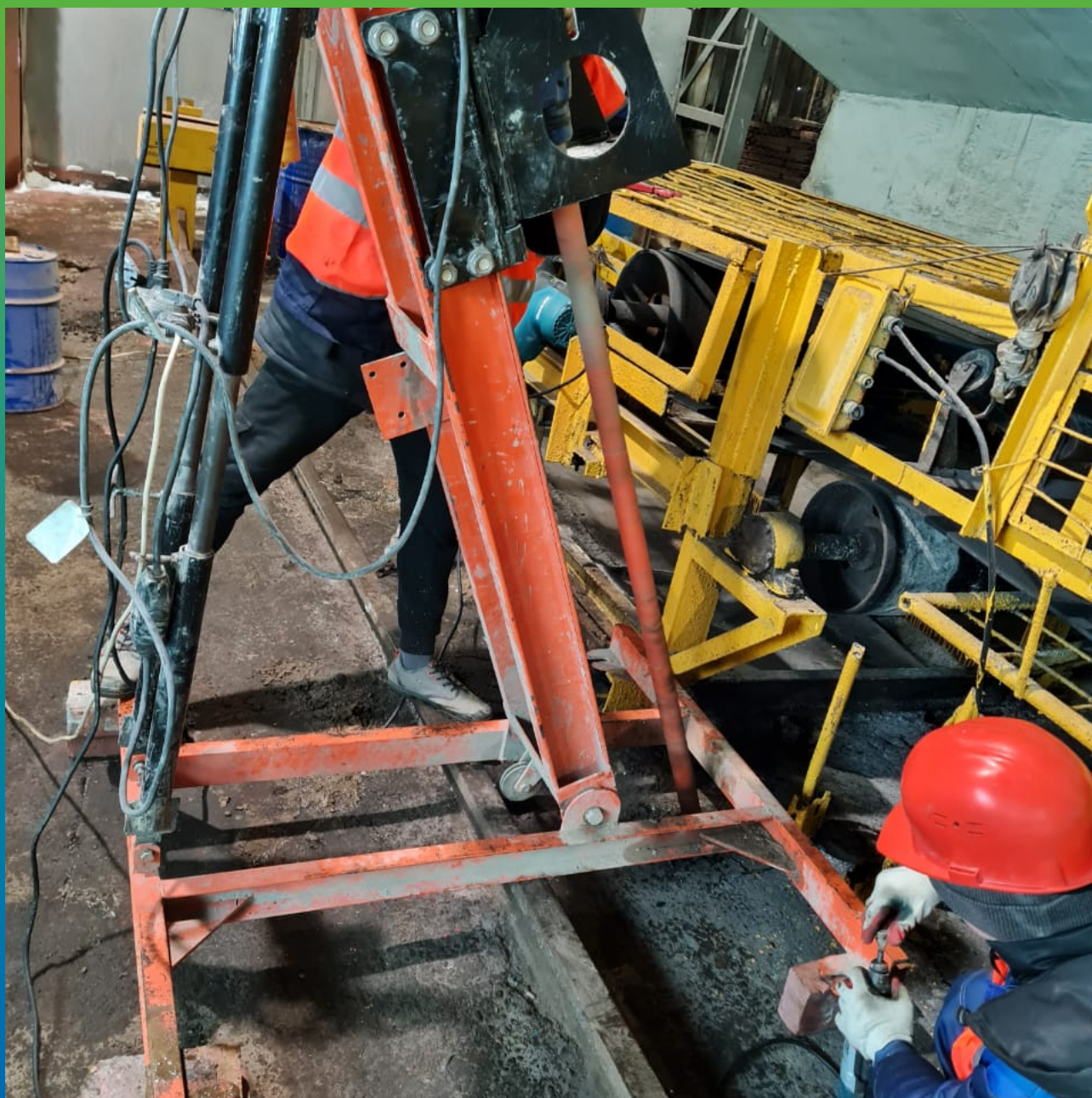
Бурение каналов для подачи инъекционного состава Маноцем Файн
