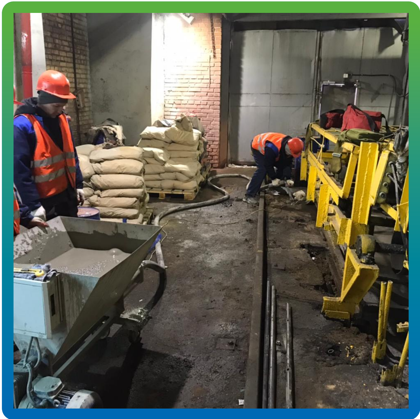
Подача состава в каналы
