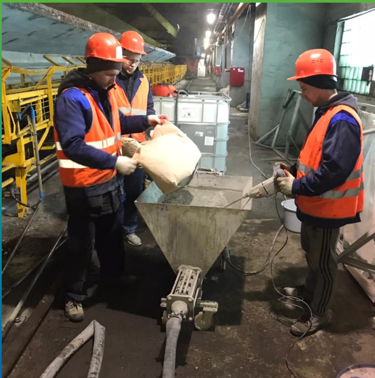
Замешивание инъекционного состава Маноцем Файн
