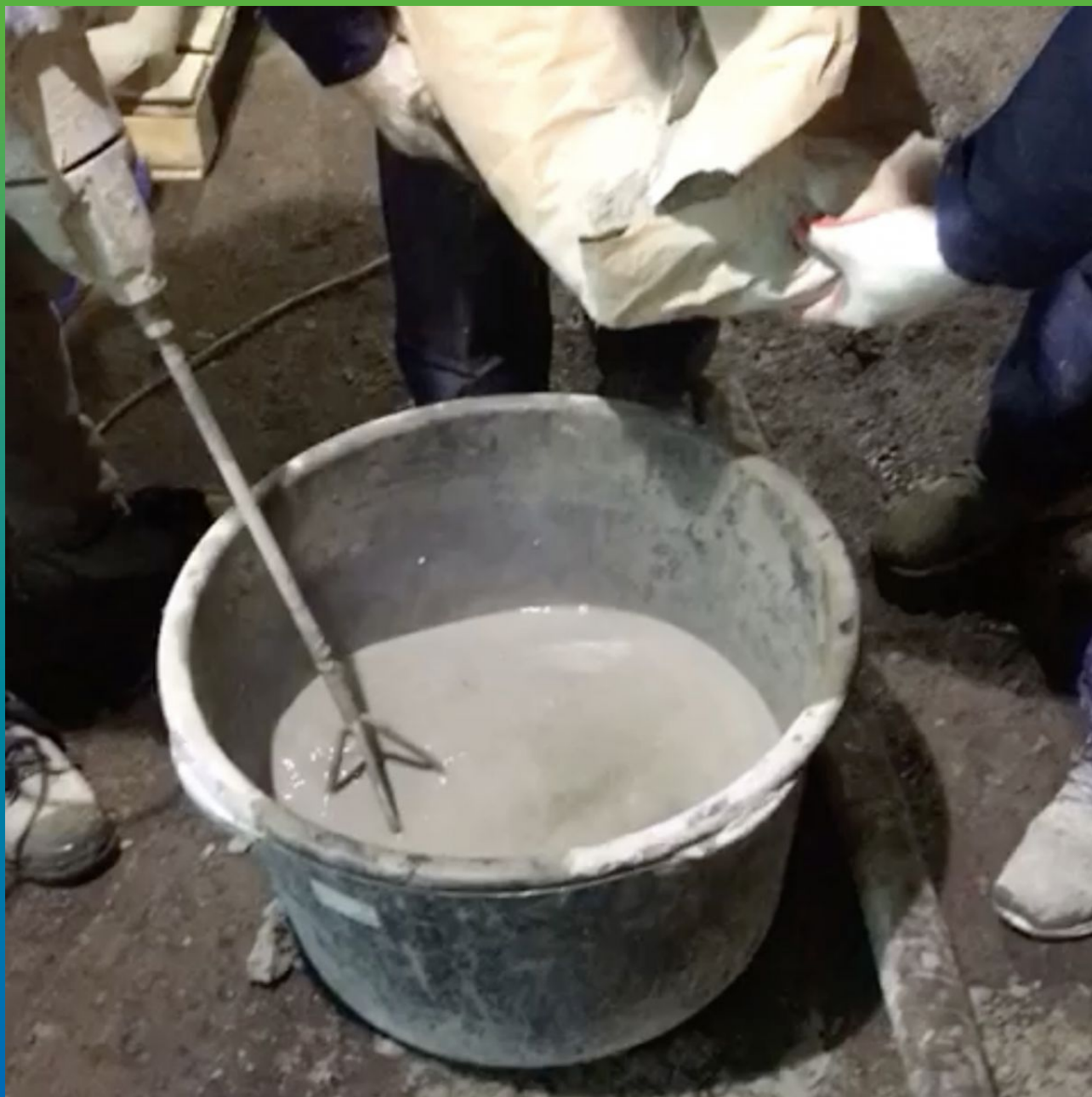
Замешивание инъекционного состава Маноцем Файн
