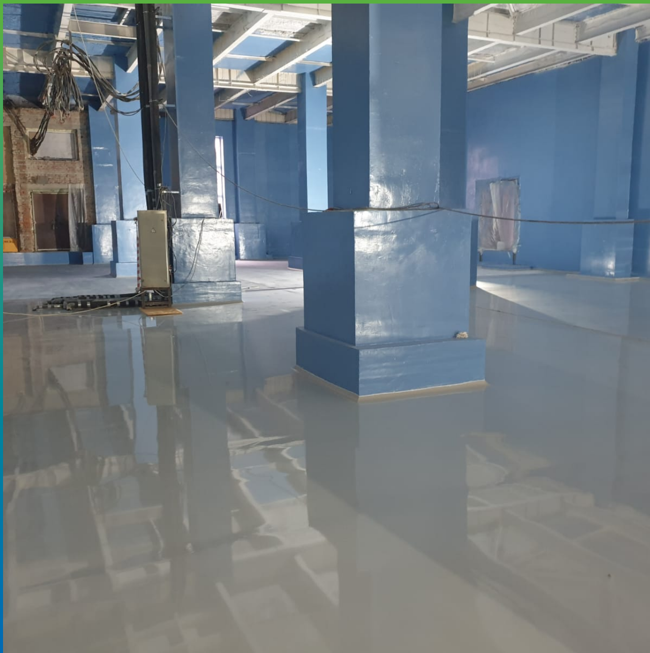
Нанесение грунтовочного состава ДенсТоп ЭП 105
