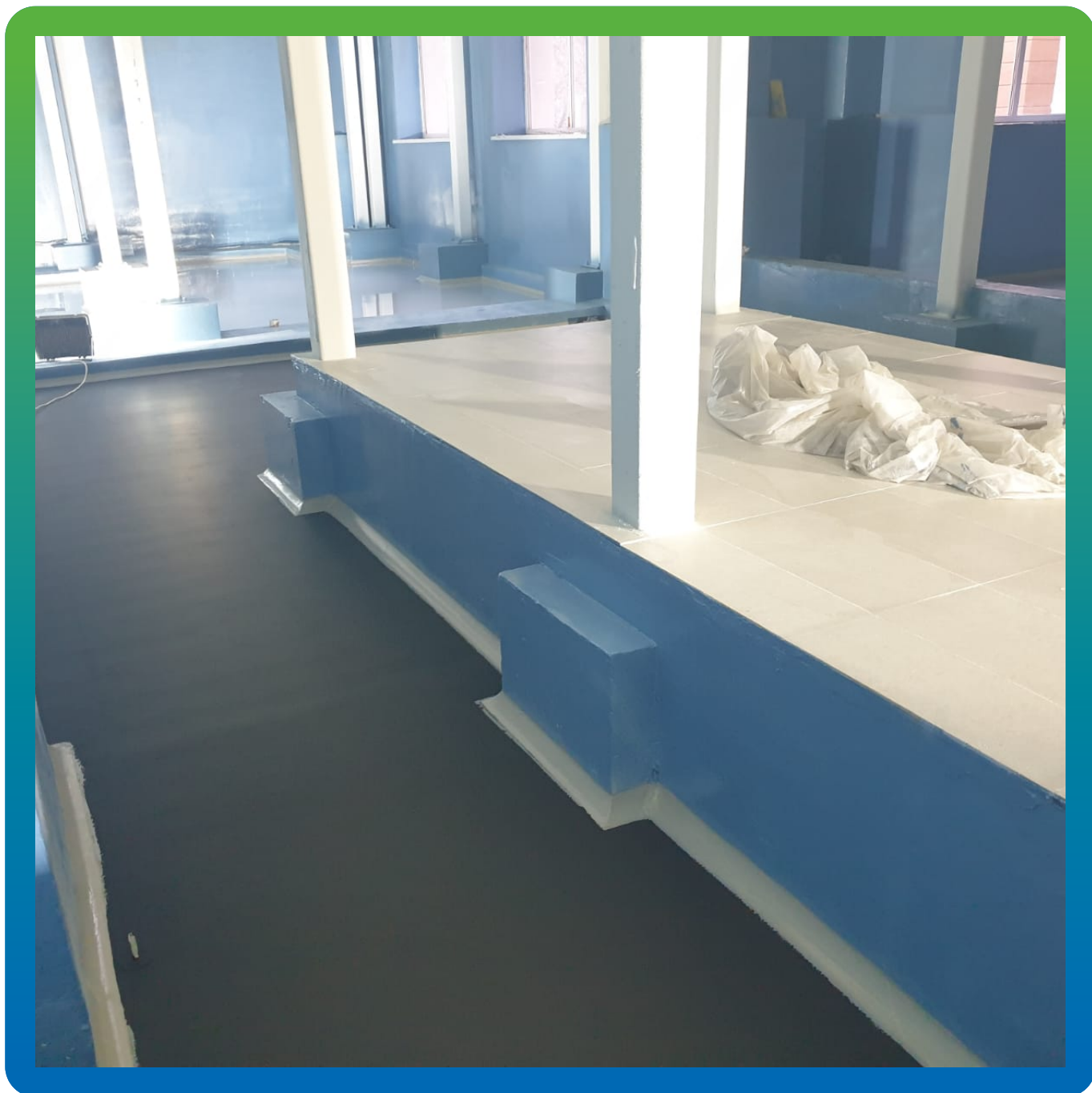
Нанесение токопроводящего грунтовочного состава ДенсТоп ЭП 105 АС
