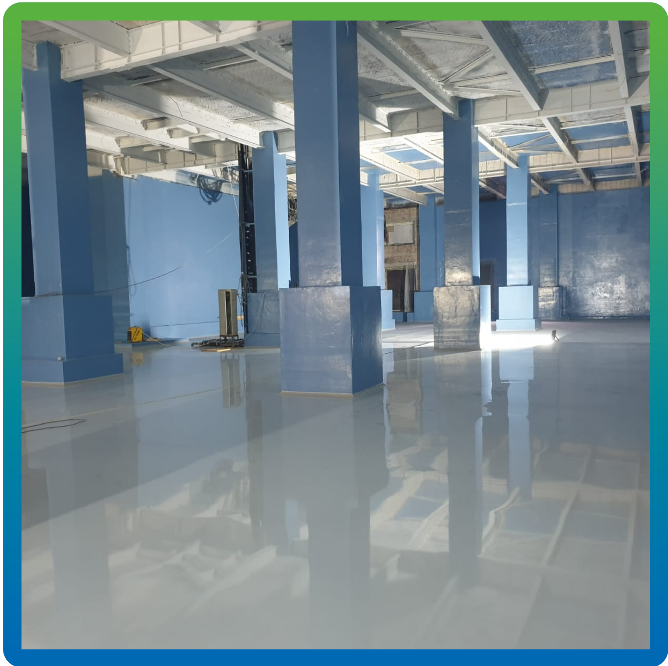
Общий вид после окончания работ
