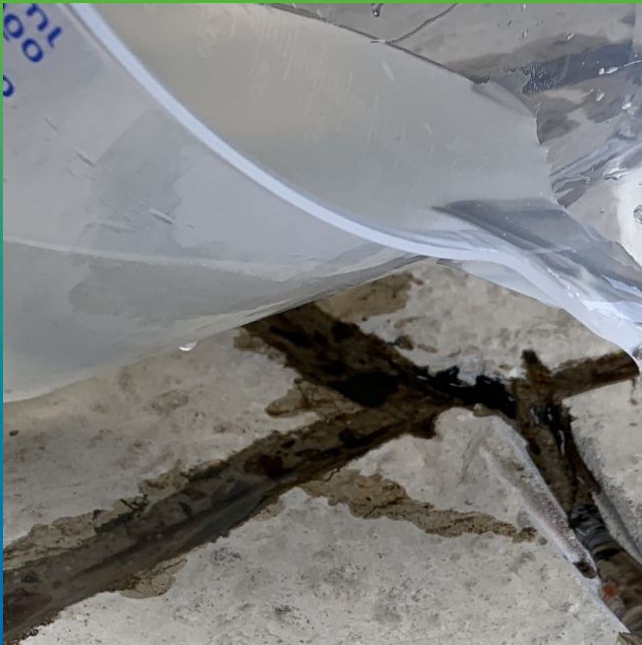
Ремонт трещин методом проливки эпоксидной смолой Манопокс 352 ЛВ
