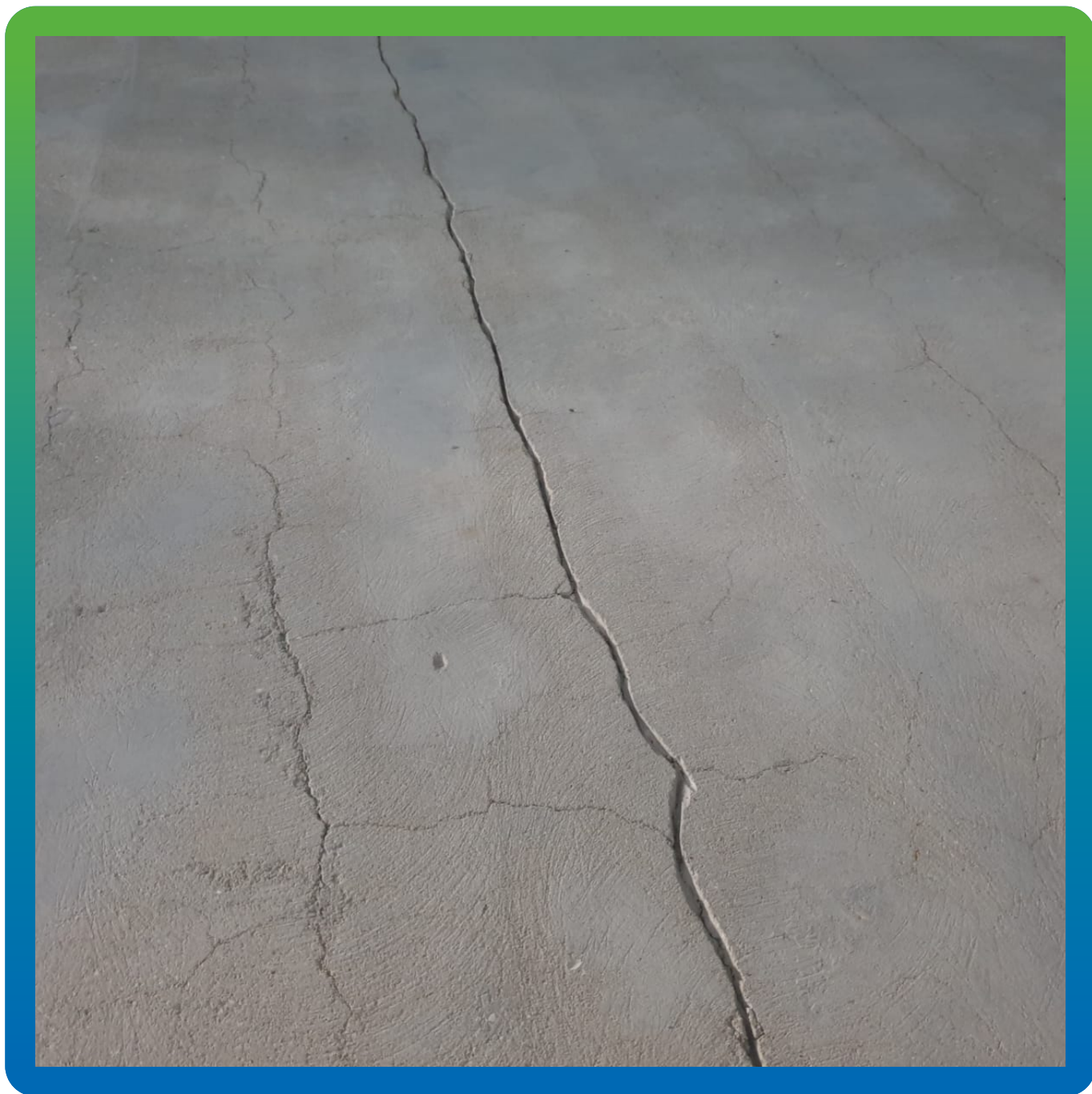
Расшивка трещин в основании бетонного пола
