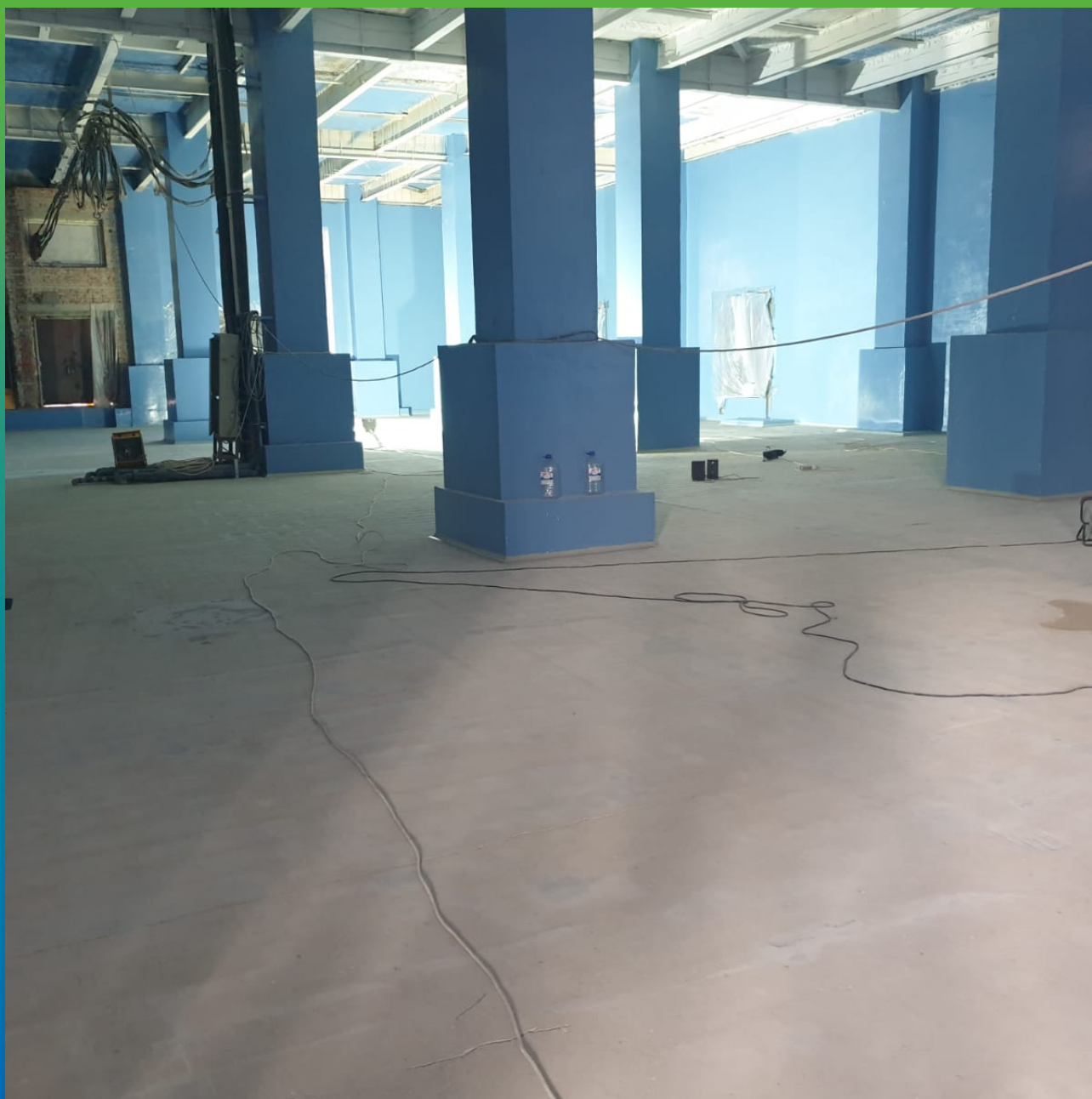
Общий вид цеха до начала работ
