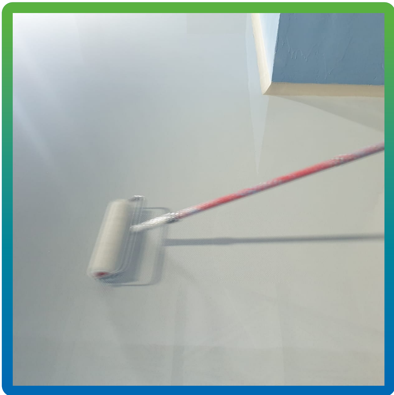
Удаление пузырьков воздуха с финишного покрытия ДенТоп ЭП 500 АС
