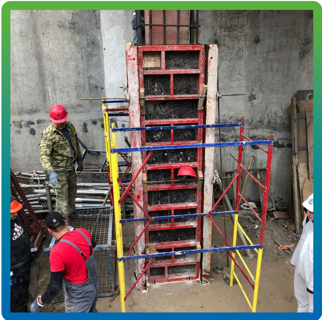
Заливка состава Стармекс ФМ7 в опалубку
