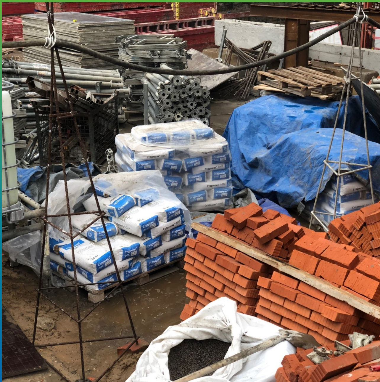
Стармекс ФМ7 на объекте
