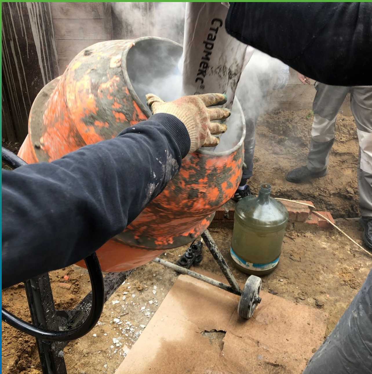
Замешивание состава Стармекс ФМ7
