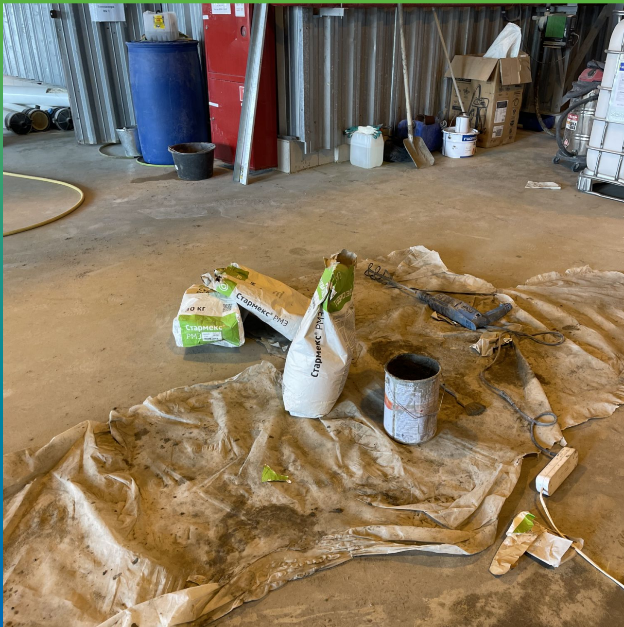
Затворение Стармекс РМЗ водой
