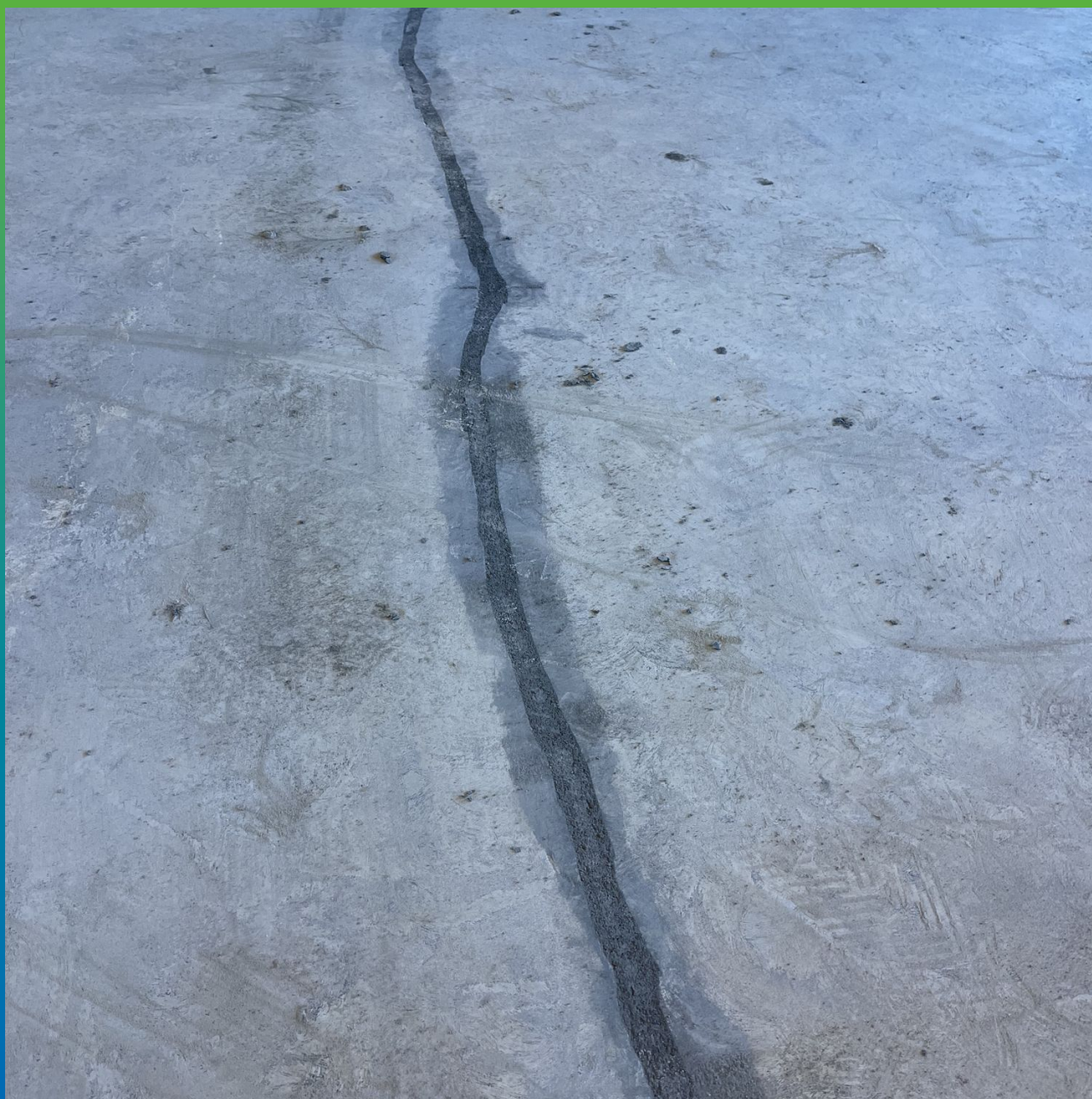
Отремонтированная трещина
