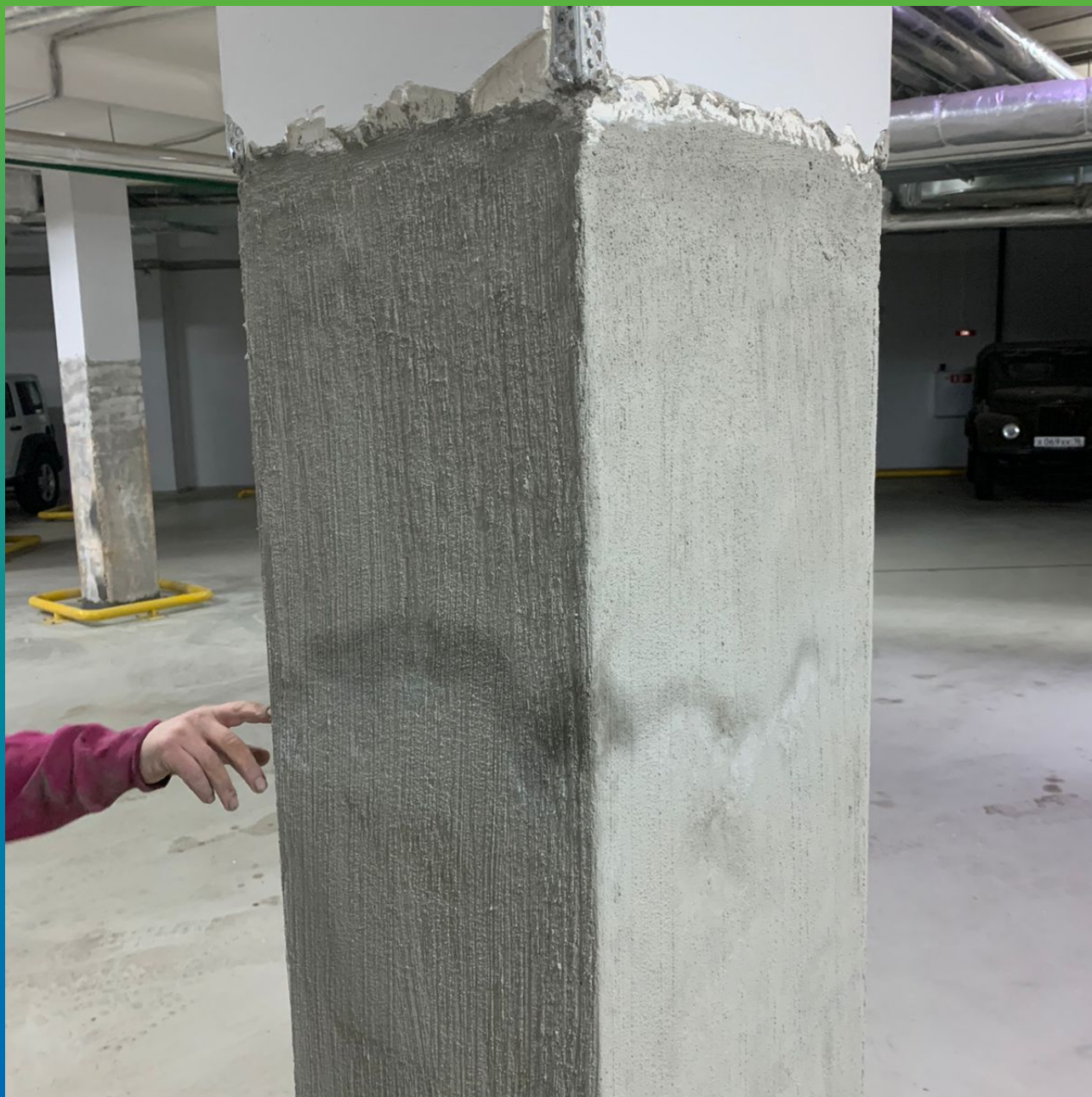
Колонна, покрытая составом Стармекс Сил
