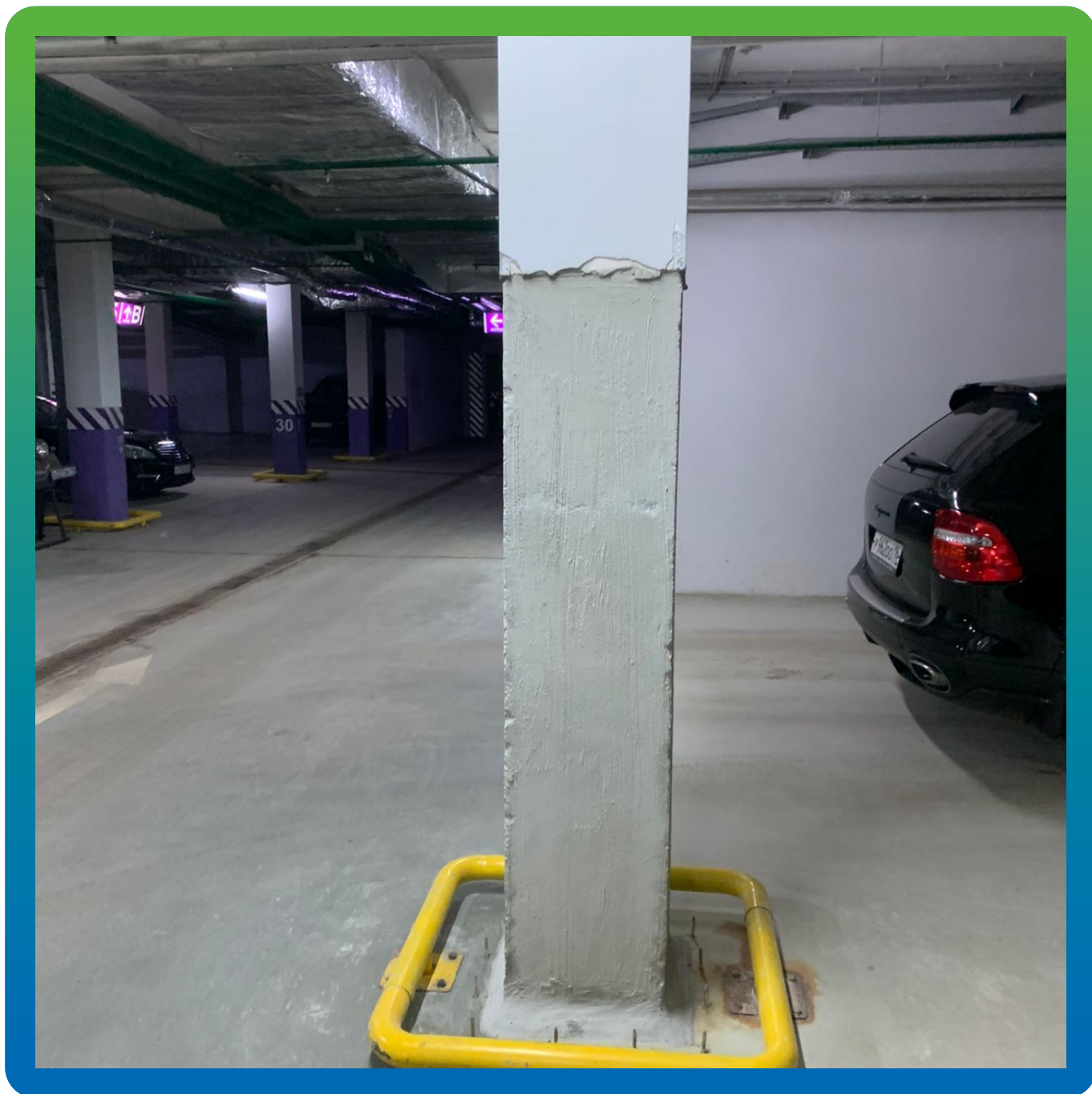
Колонна, покрытая составом Стармекс Сил
