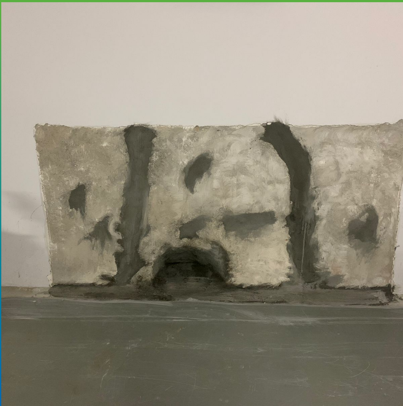
Дефекты стен, отремонтированные составом Стармекс РМЗ
