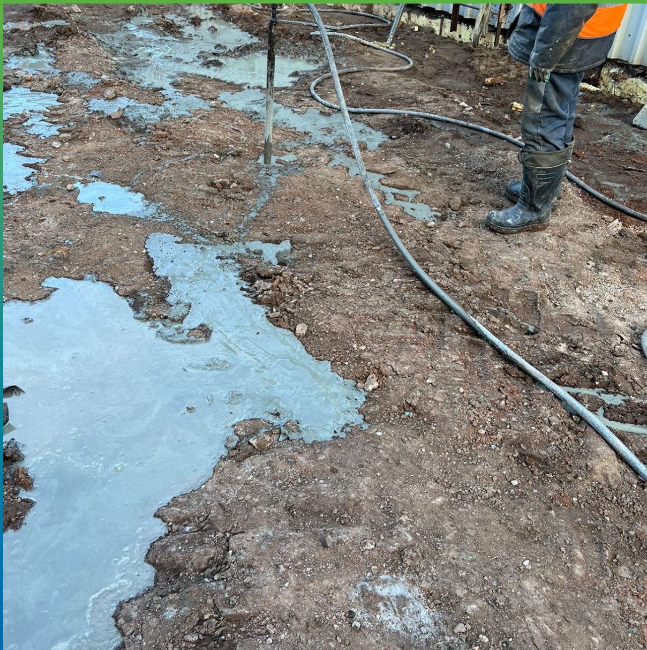
Инъектирование грунта составом Маноцем Файн
