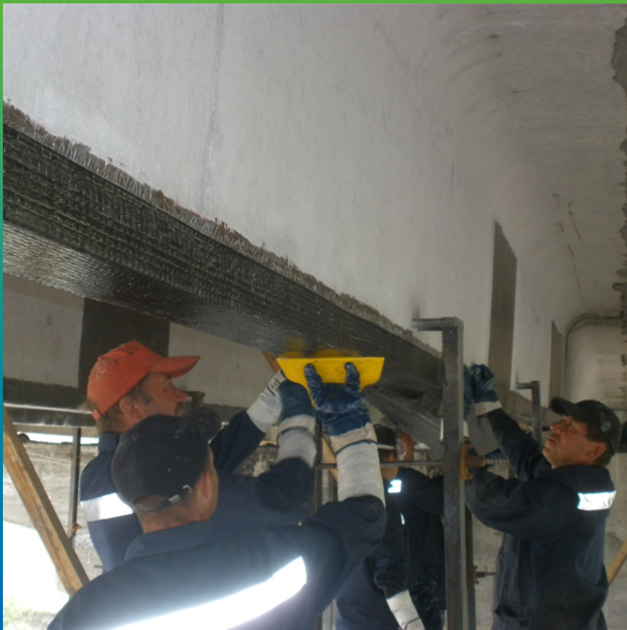
Монтаж системы усиления Тайфо СЦХ-41
