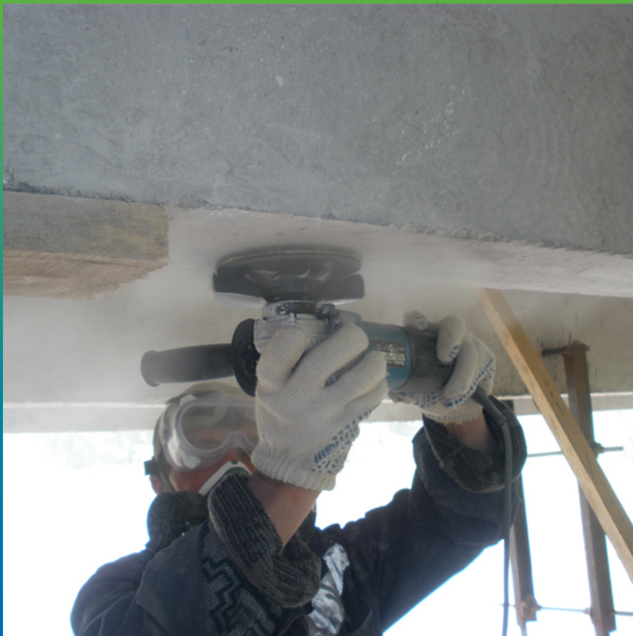
Шлифовка поверхности бетона
