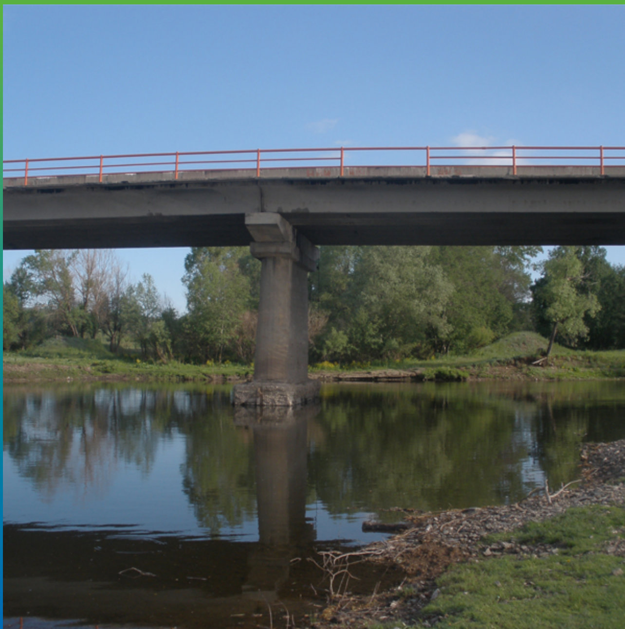
Общий вид объекта до начала работ
