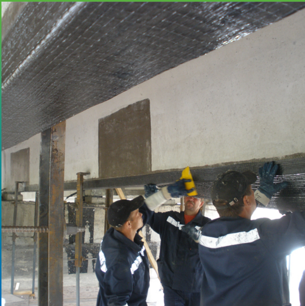
Монтаж системы усиления Тайфо СЦХ-41
