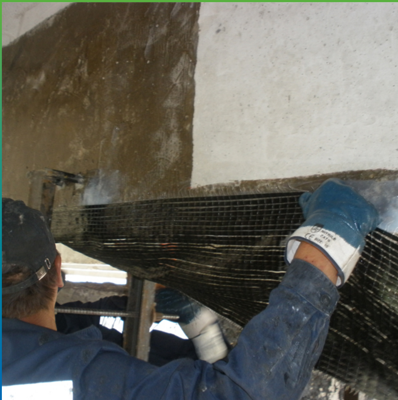
Монтаж системы усиления Тайфо СЦХ-41 (начало)
