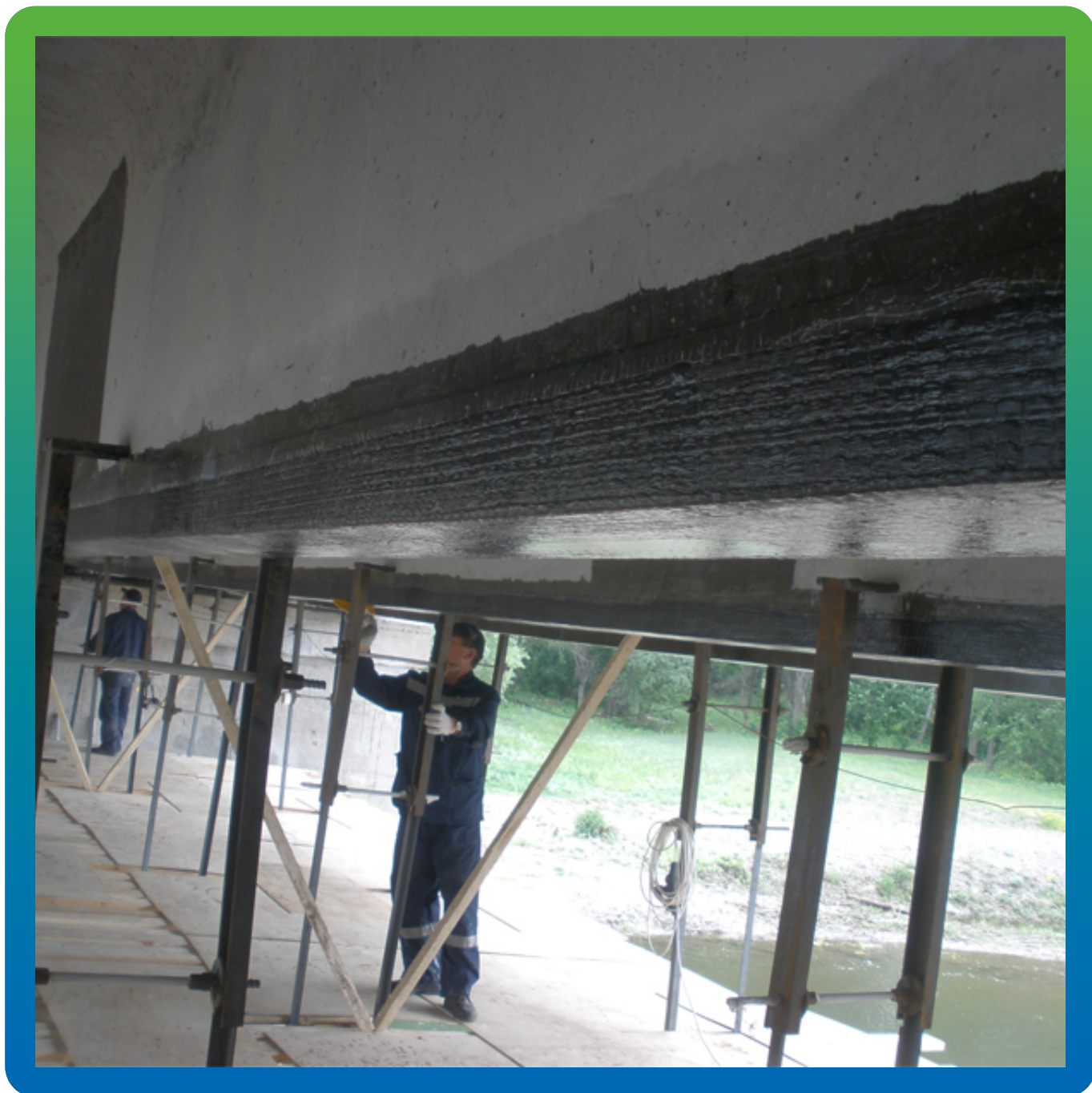
Вид смонтированной системы усиления продольного направления
