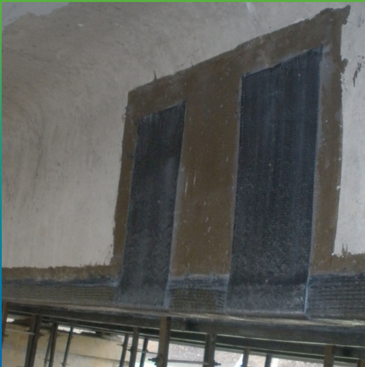
Полотна системы усиления продольного и перпендикулярного направления
