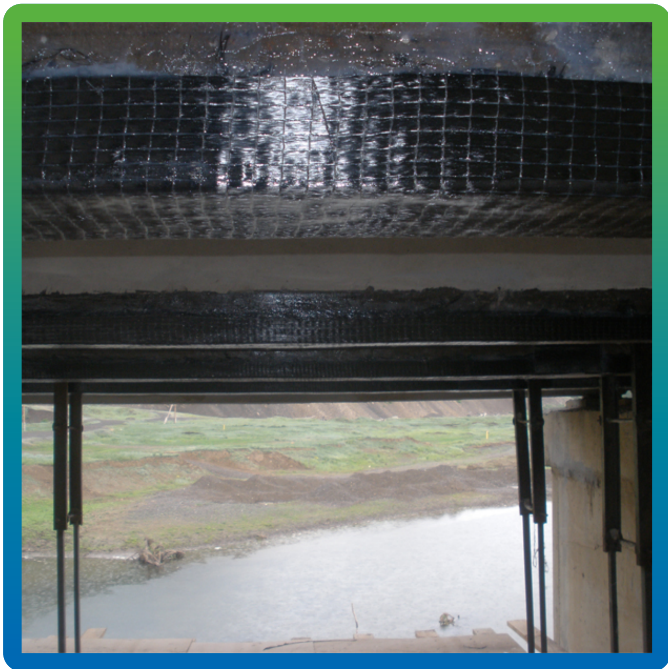
Вид смонтированной системы усиления продольного направления
