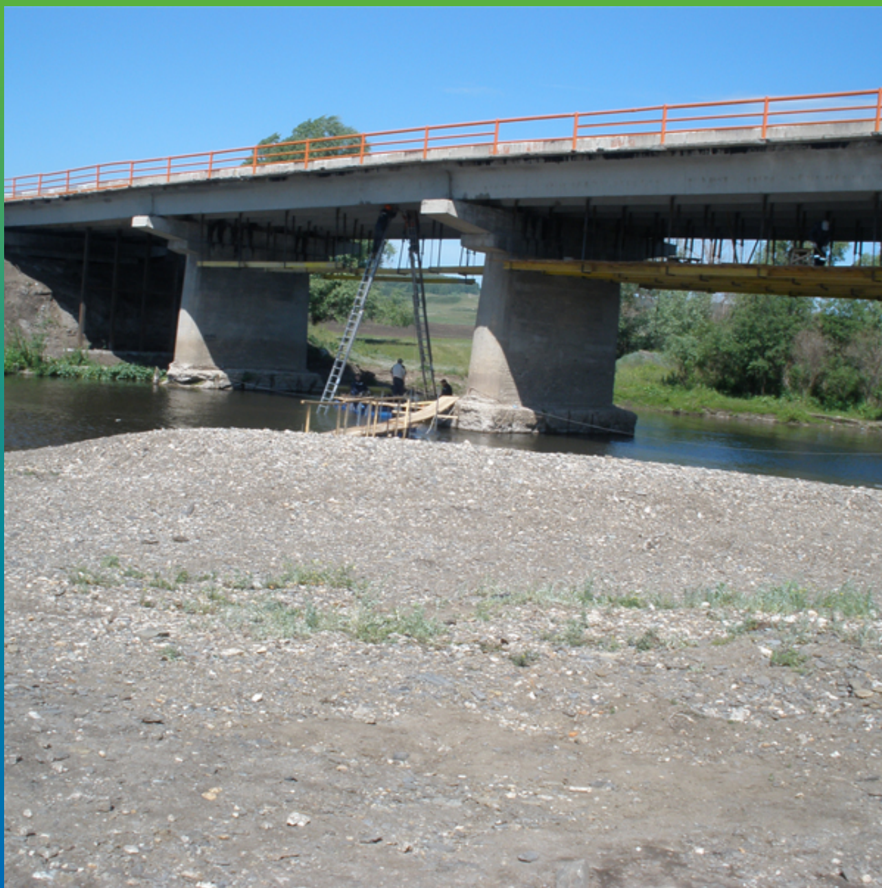
Вид моста до начала работ
