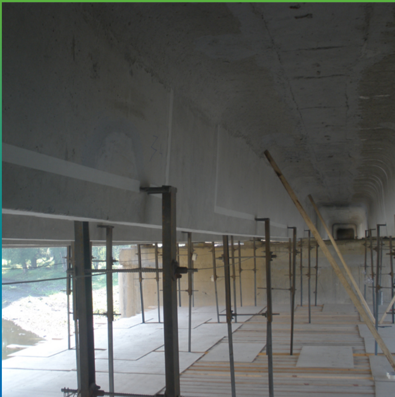
Разметка поверхности бетона
