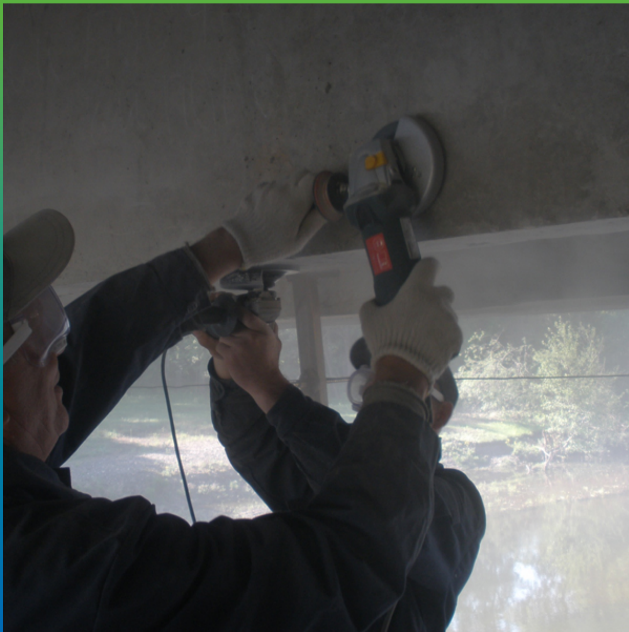
Шлифовка бетона
