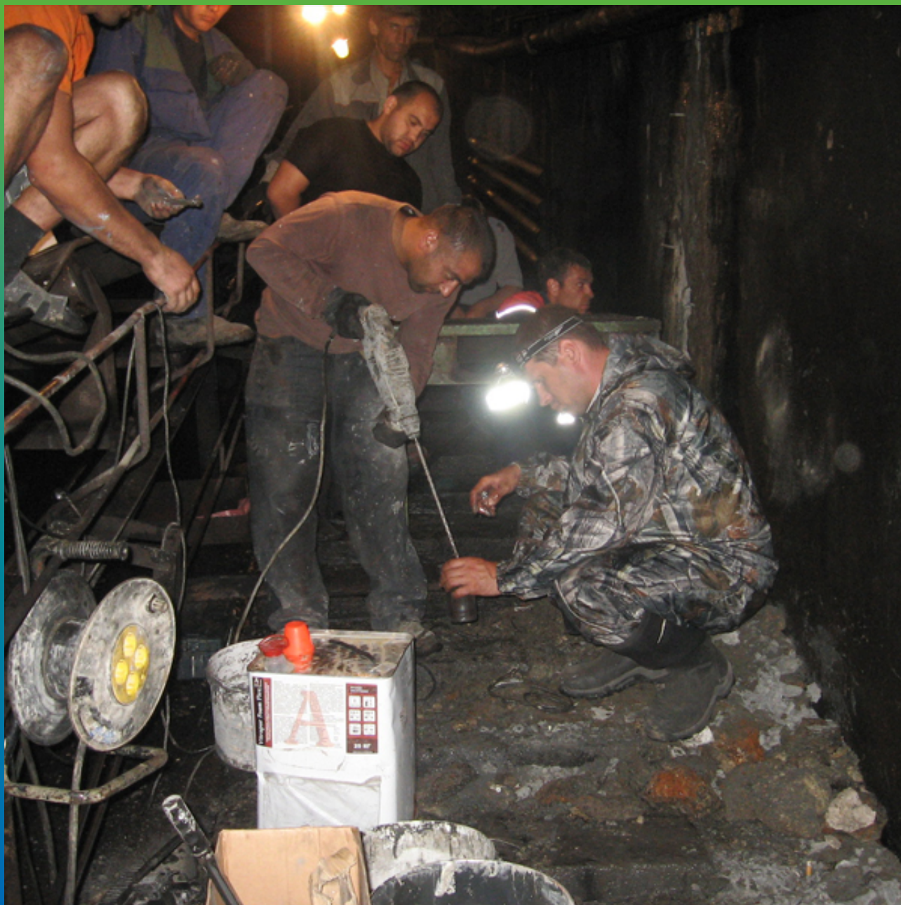
Приготовление инъекционного состава Витрапур Фоам Флекс
