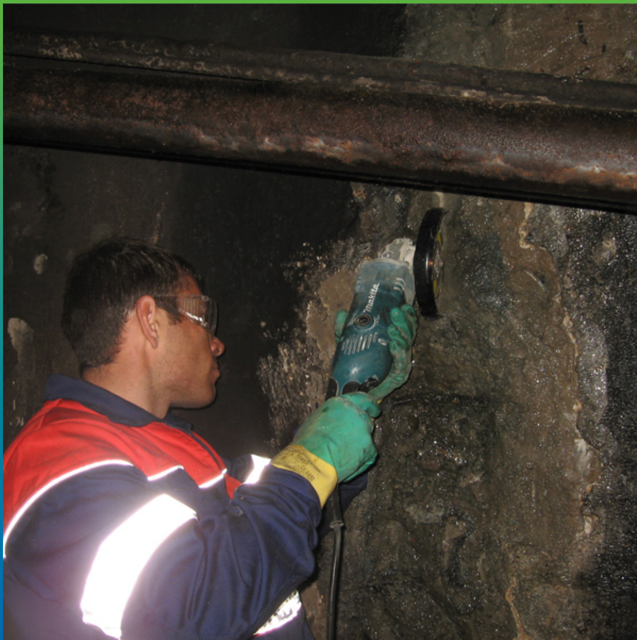
Подготовка шва перед началом инъектирования
