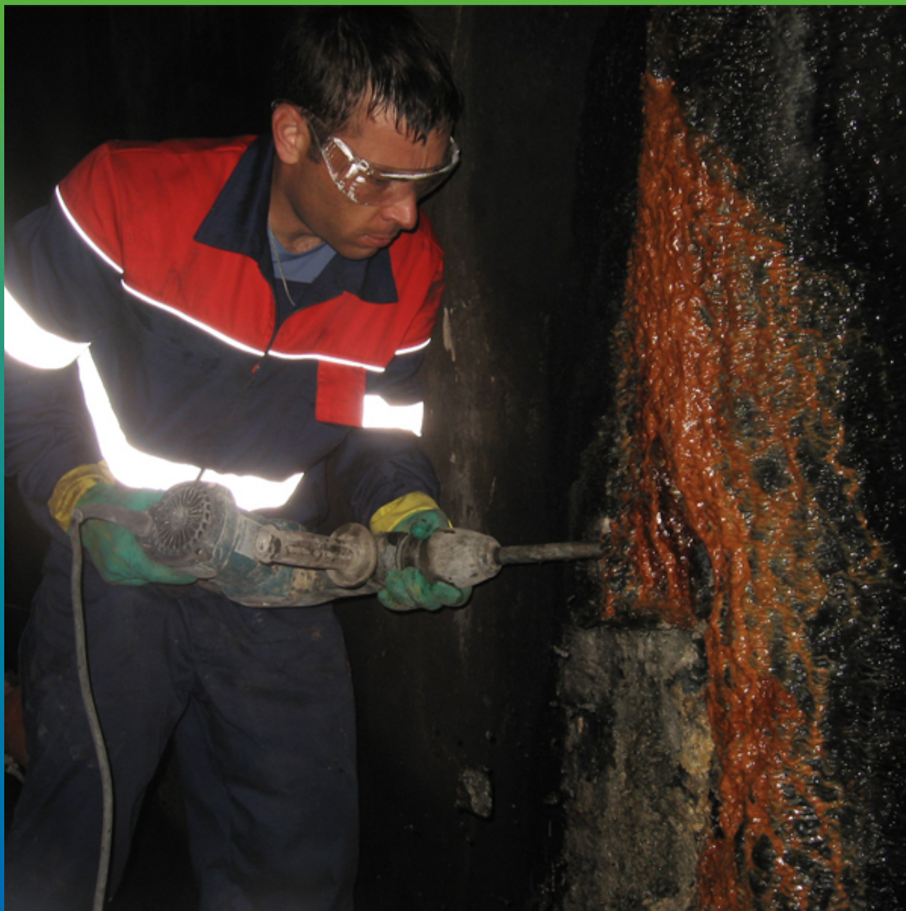
Подготовка шва перед началом инъектирования
