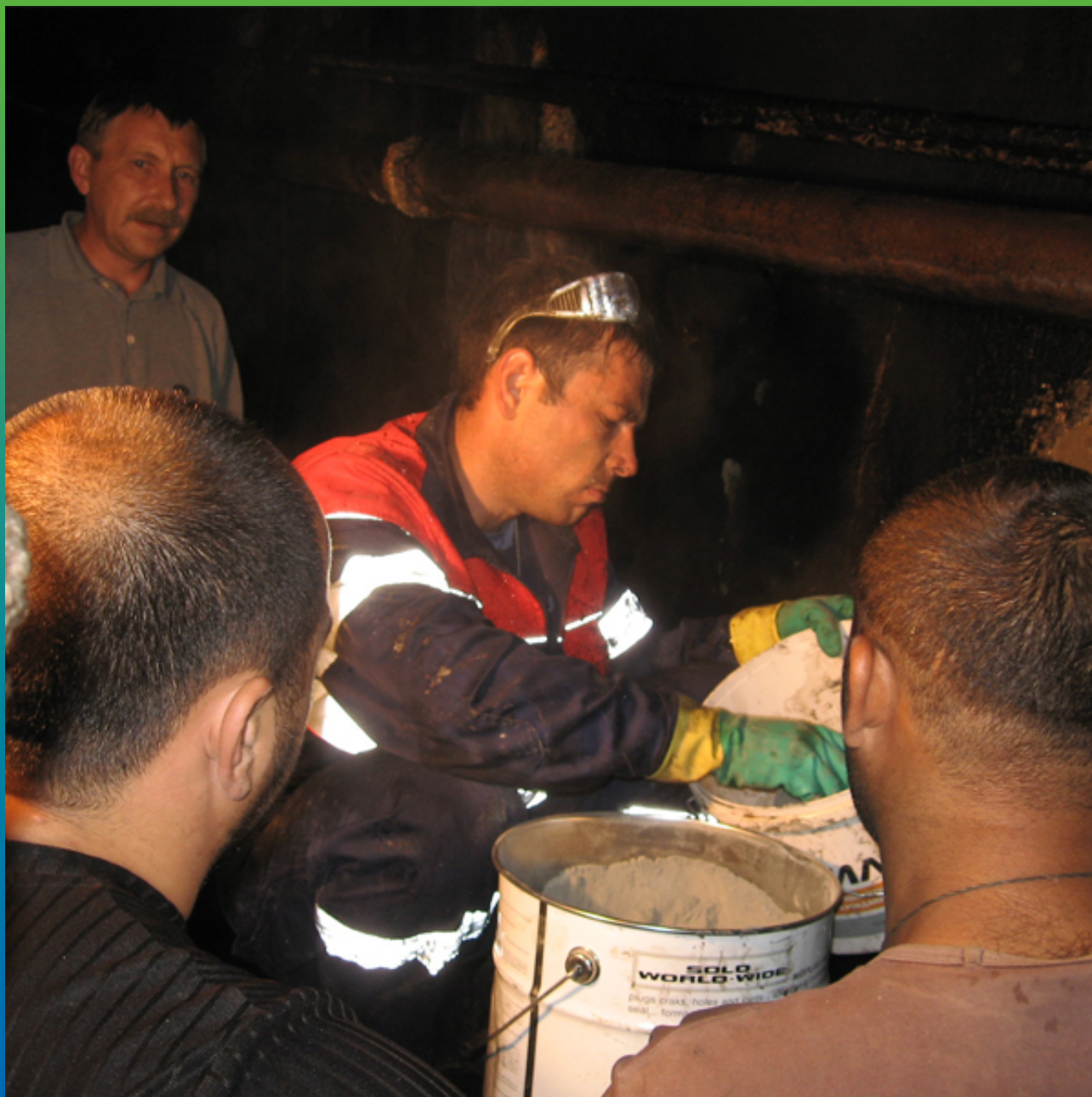
Приготовление гидропломбы Максплаг для зачеканки шва
