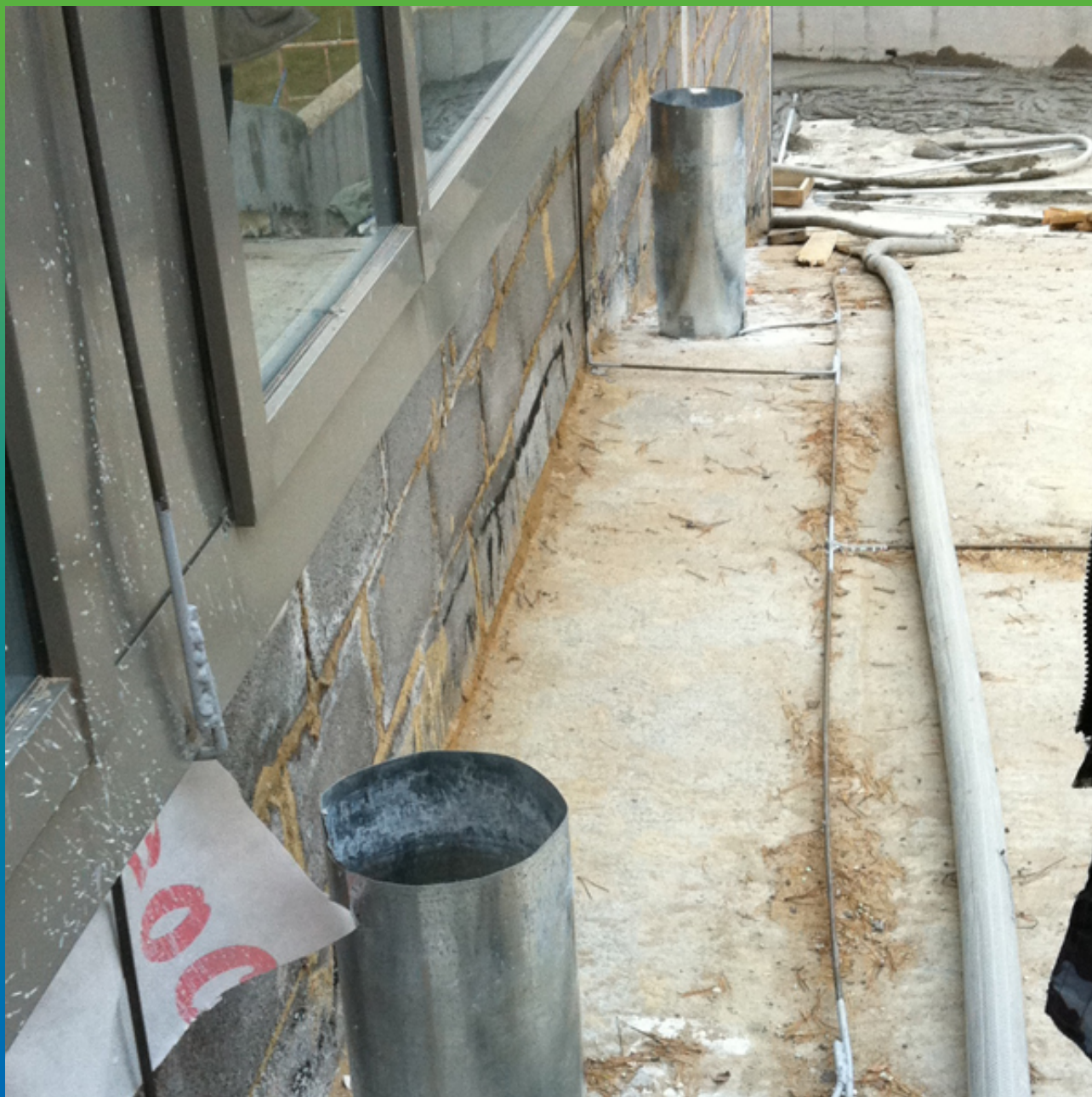
Устройство воронок
