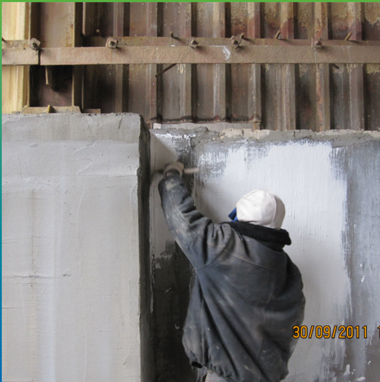
Нанесение Макссил Флекс на стены
