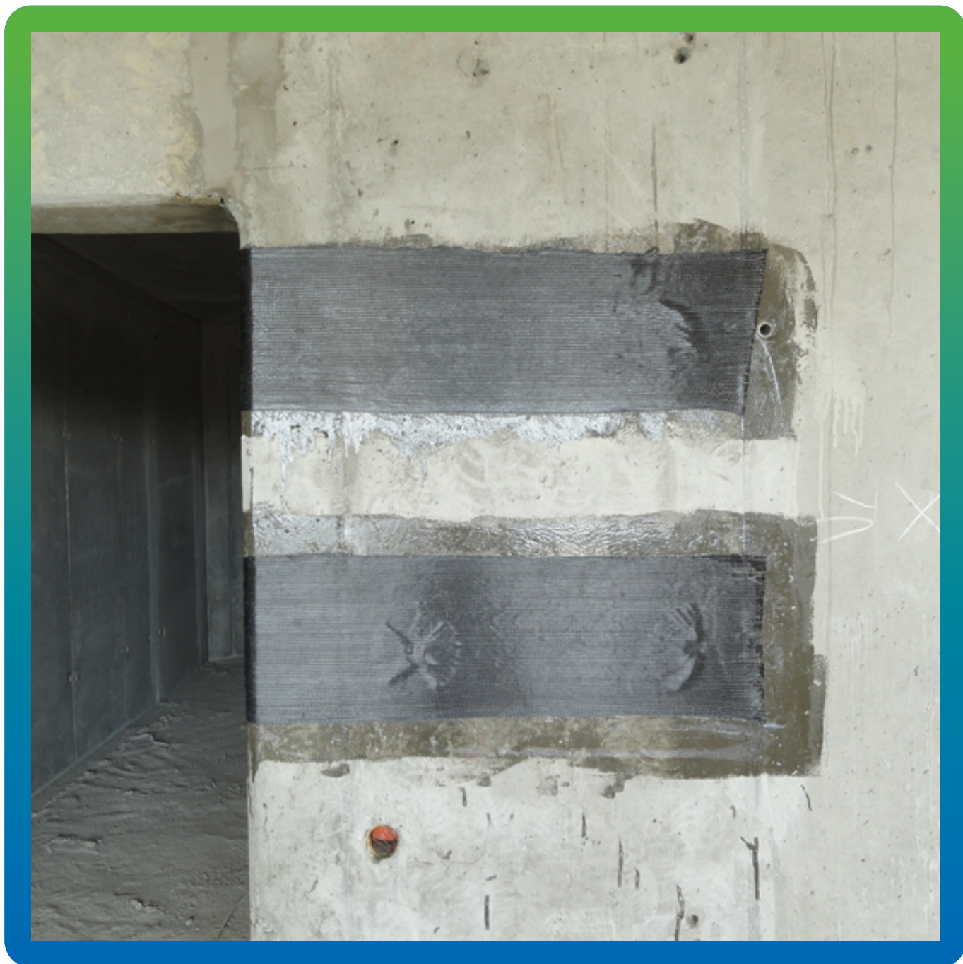
Вид усиленной конструкции
