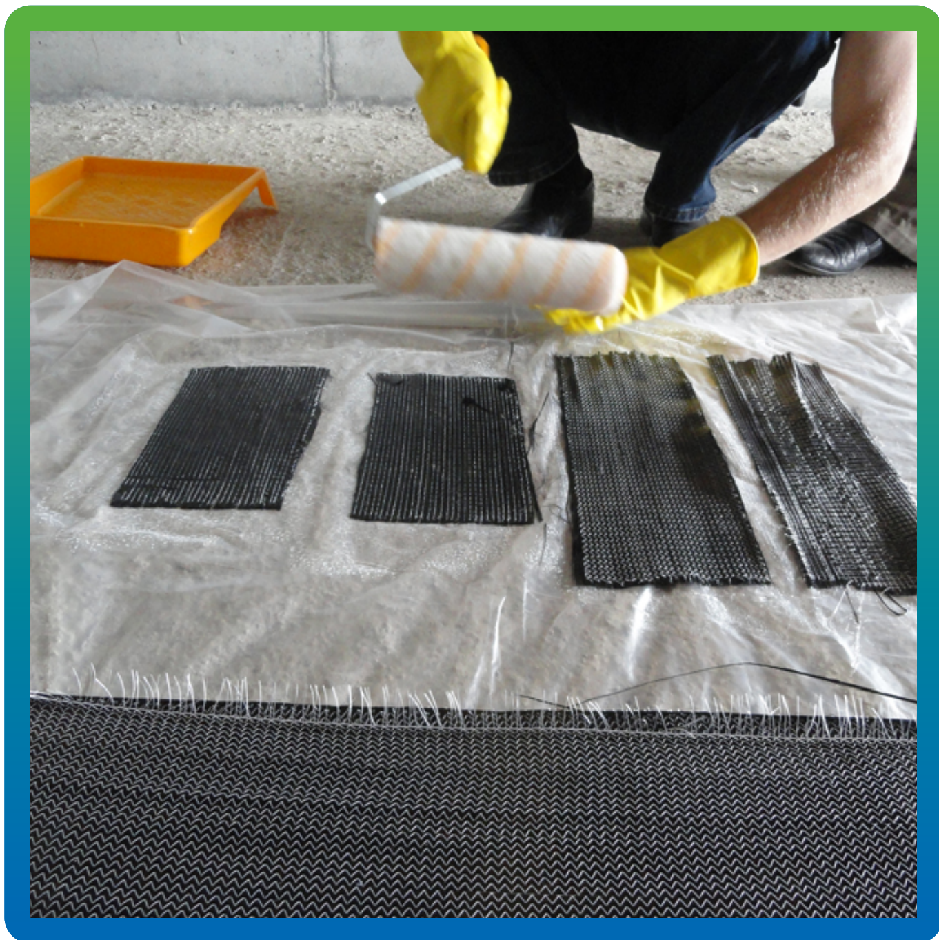
Пропитка холстового материала Тайфо СЦХ-31АП-Н, пропитка анкеров
