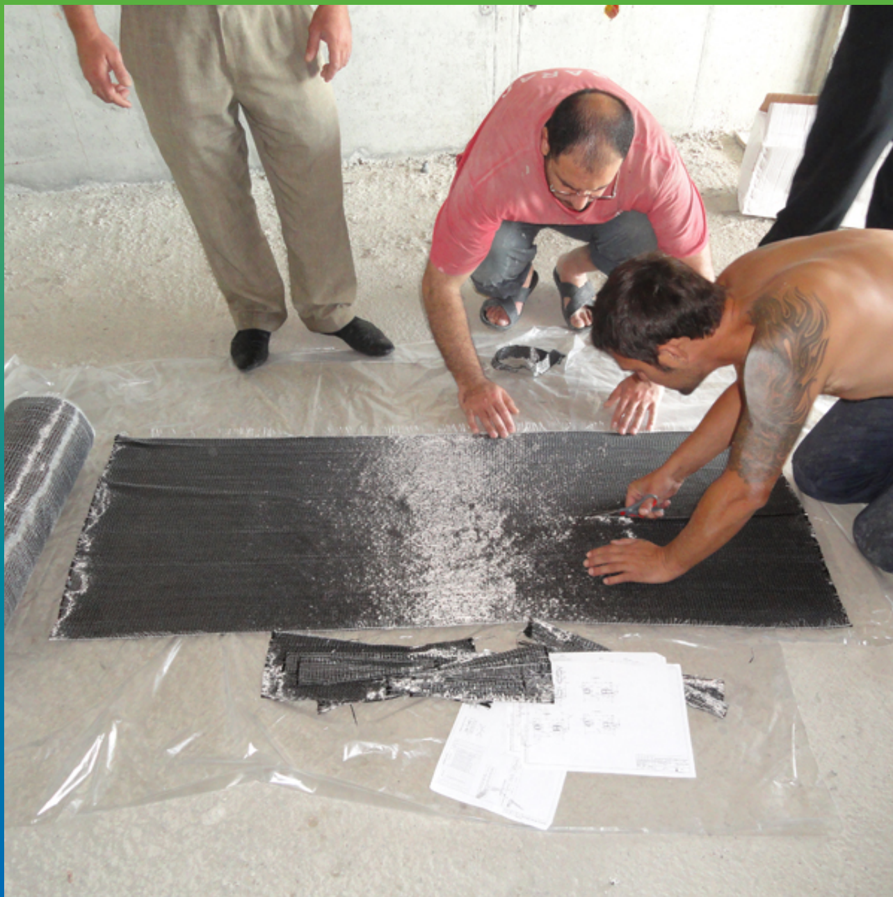
Нарезка холстового материала Тайфо СЦХ-31АП-Н перед укладкой
