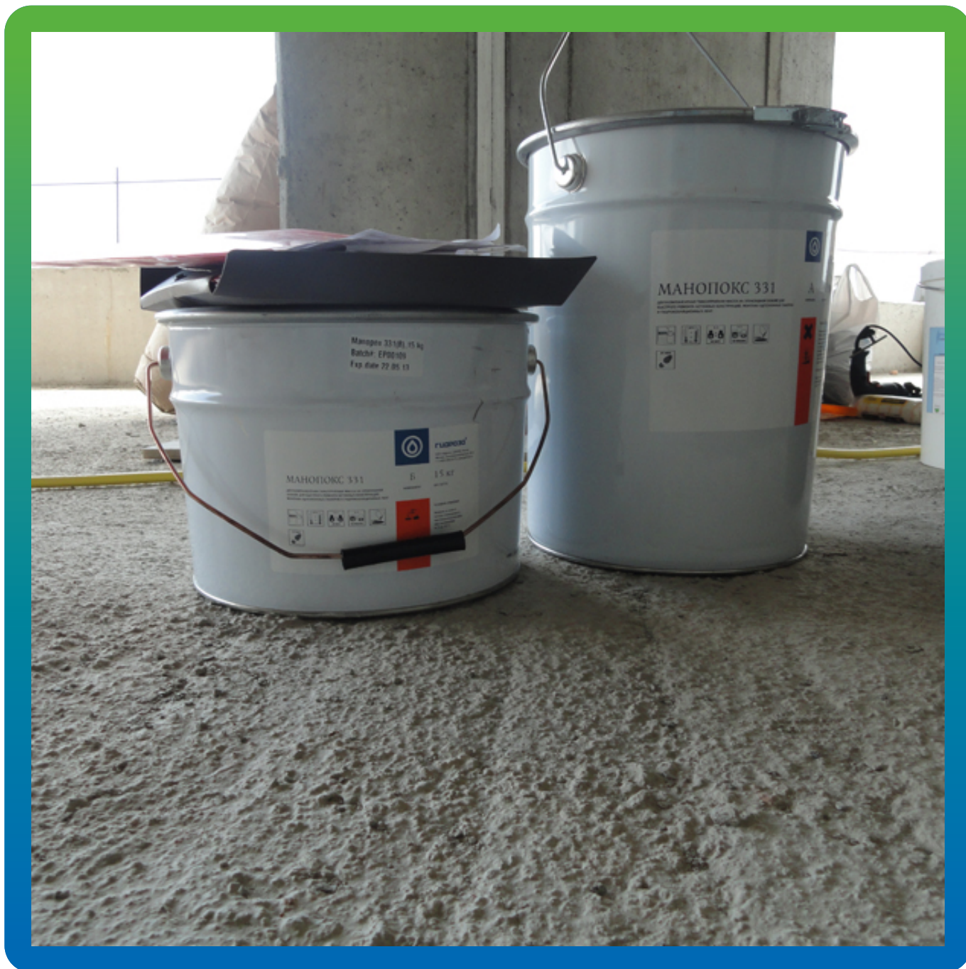
Материал Манопокс 331 перед замешиванием на площадке
