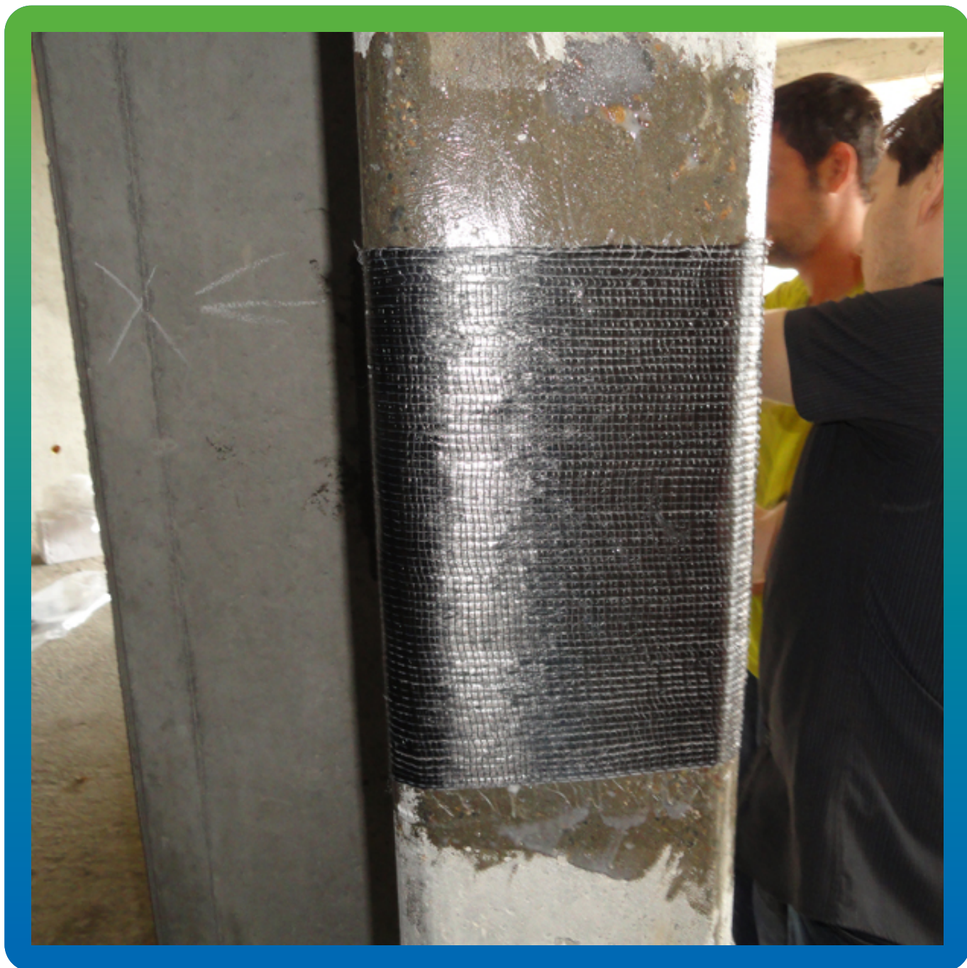
Процесс наложения холстового материала Тайфо СЦХ-31АП-Н
