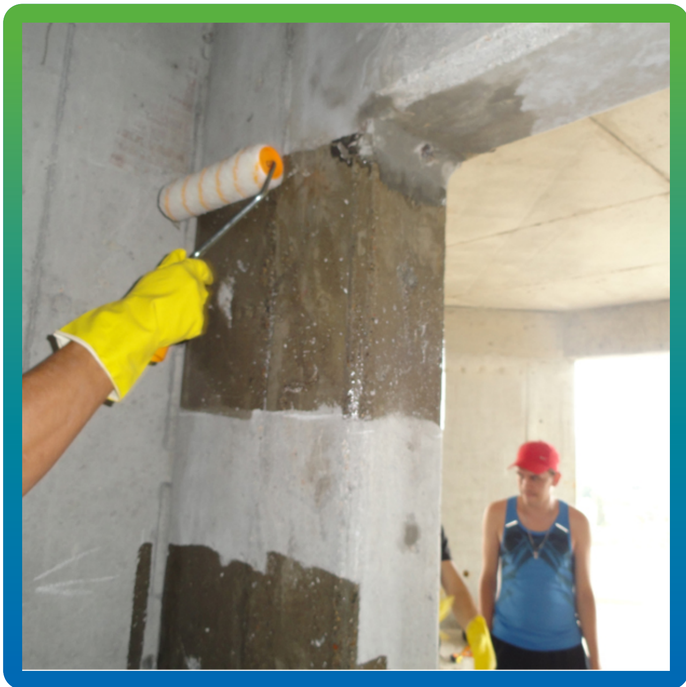
Грунтование подготовленной поверхности составом Тайфо С
