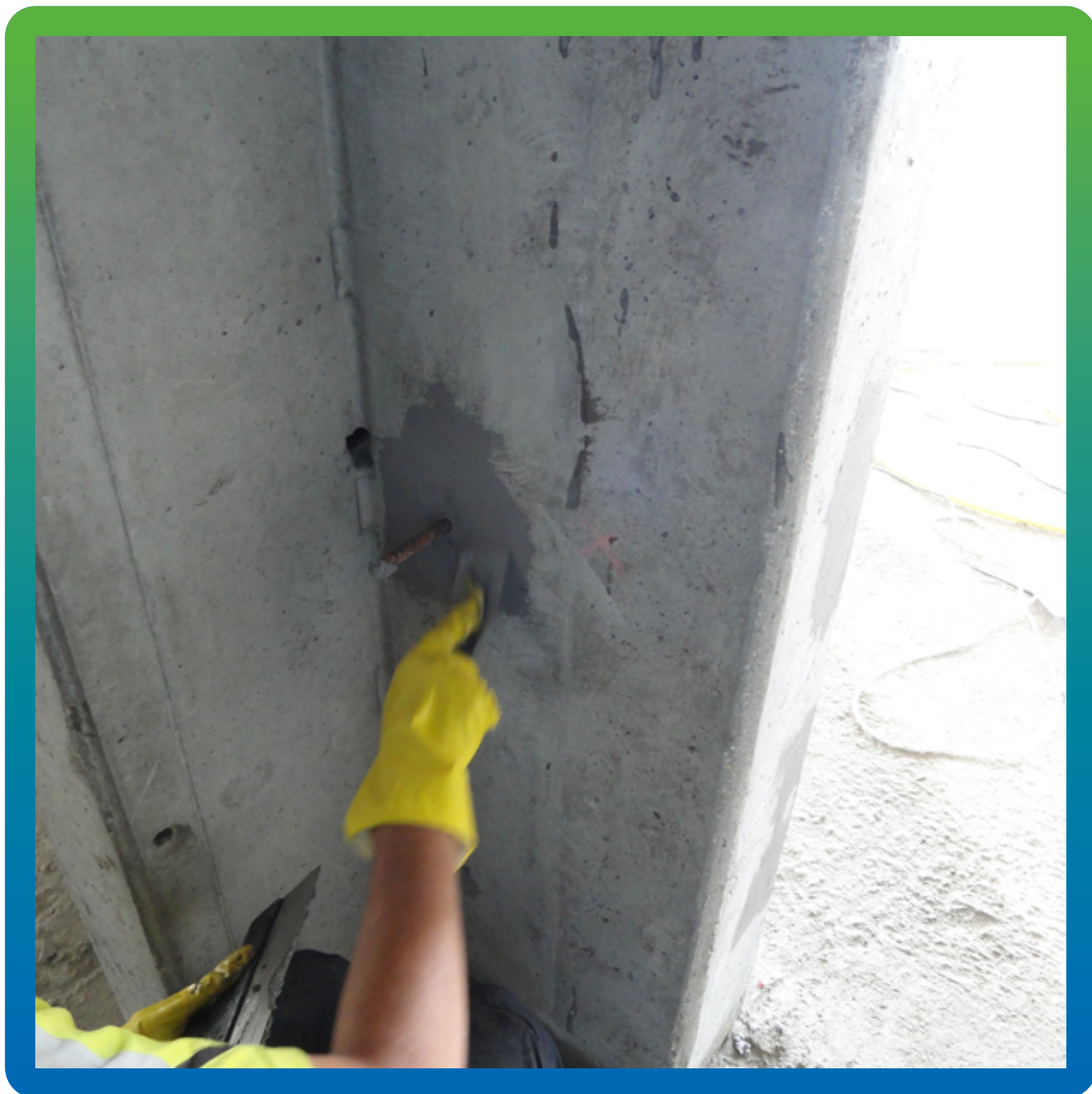
Ремонт поверхности перед усилением, материалом Манопокс 331
