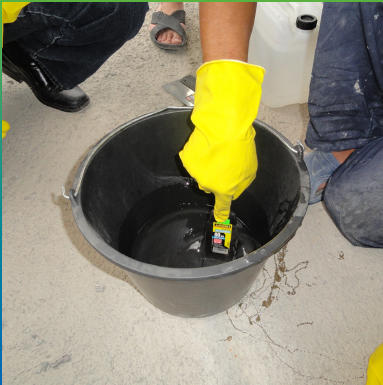
Замешивание состава Тайфо С
