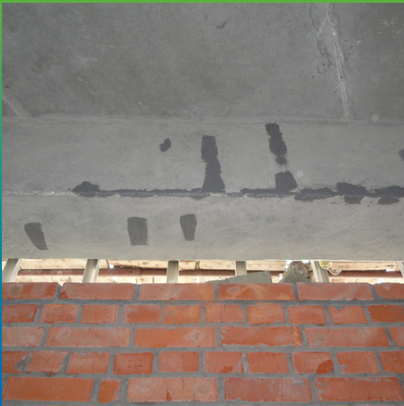
Подготовленная поверхность перед усилением
