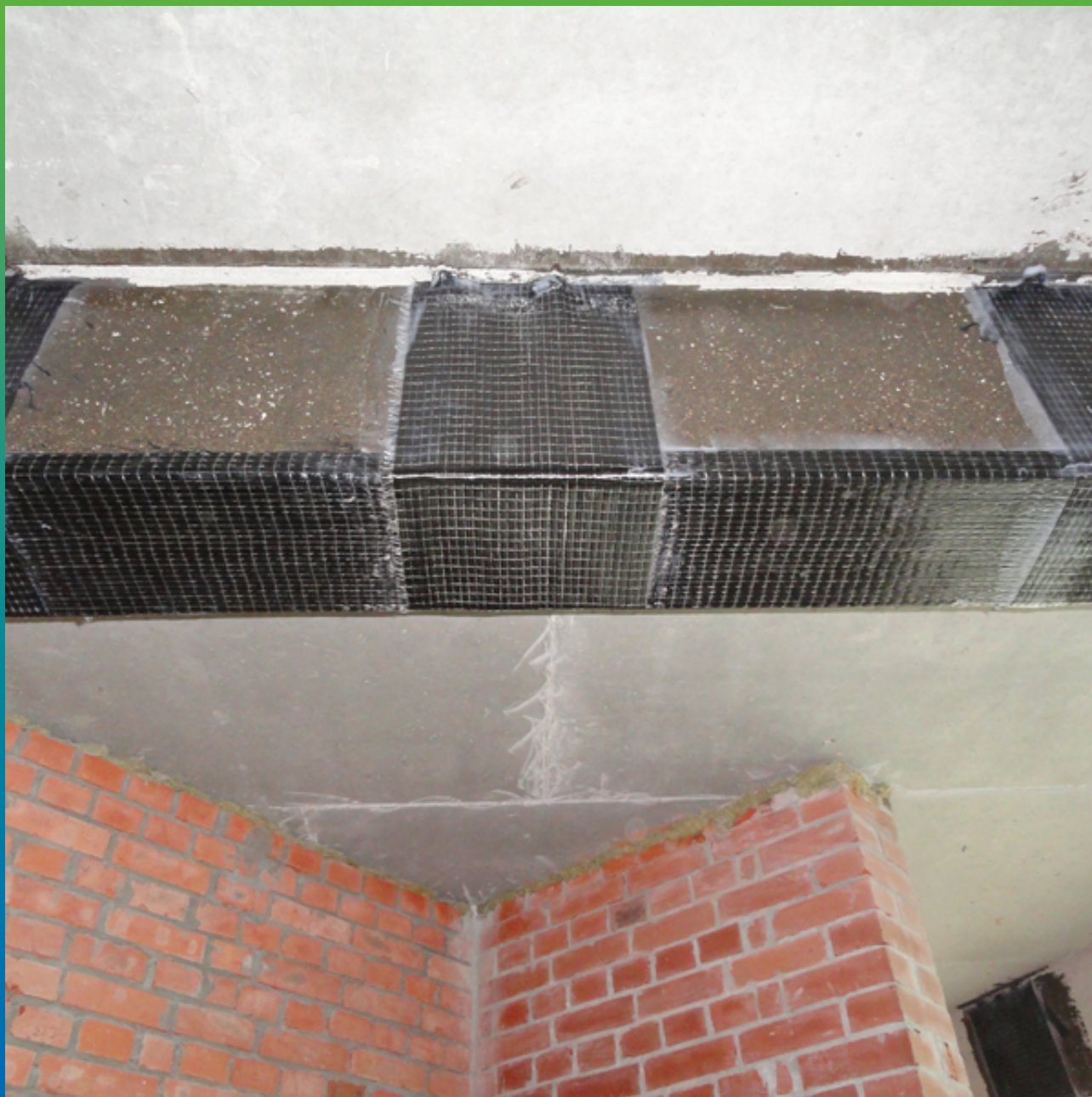
Вид усиленной конструкции, 9-й этаж
