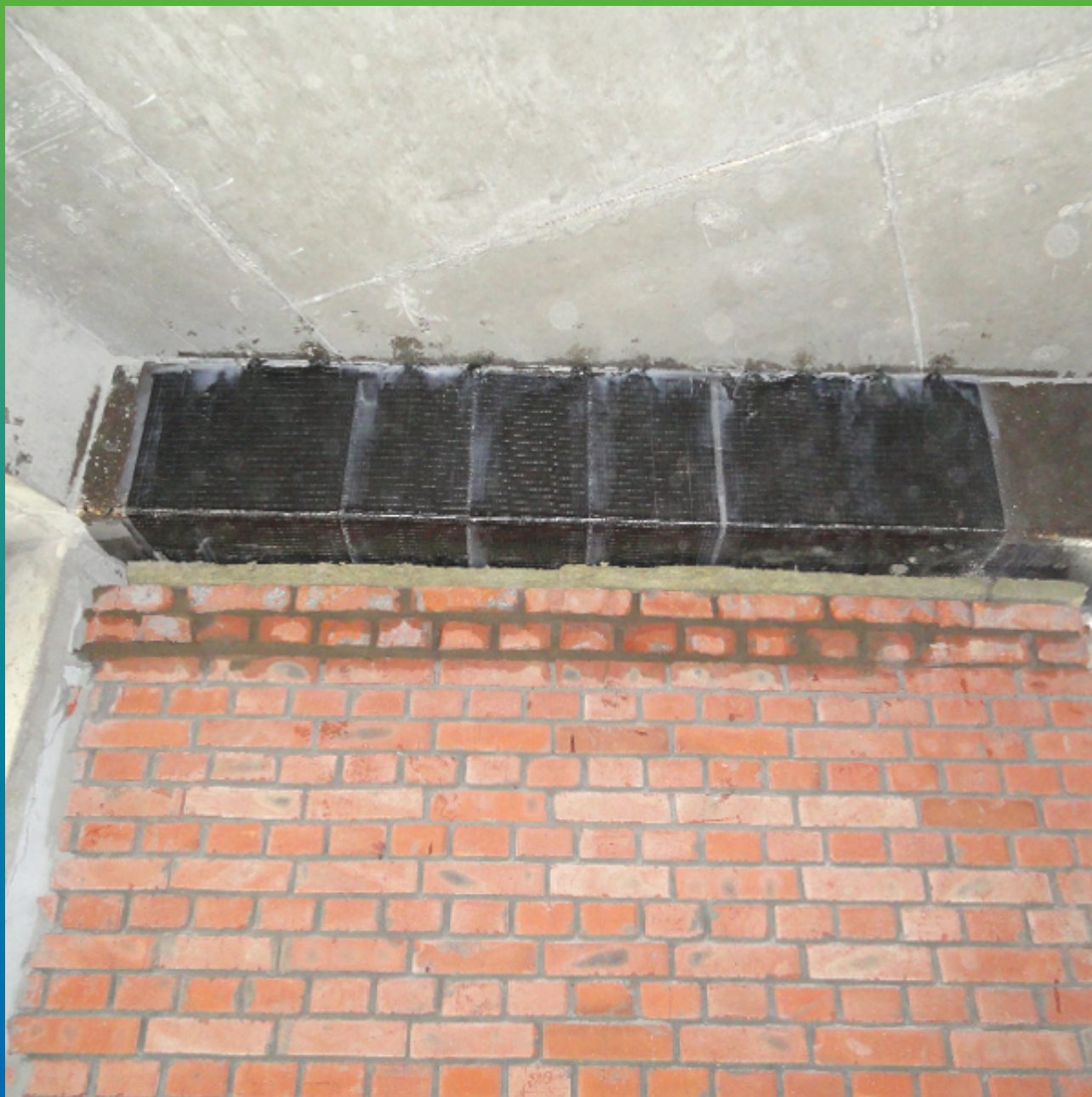
Вид усиленной конструкции, 8-й этаж
