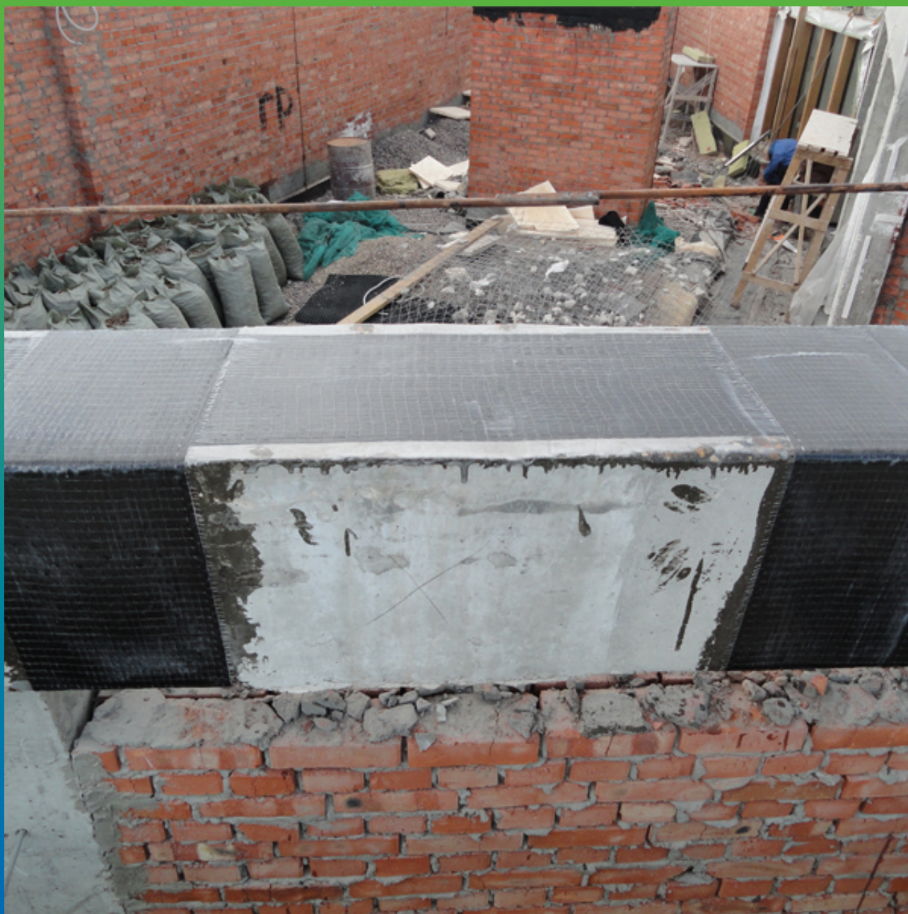
Вид усиленной конструкции, уровень кровли
