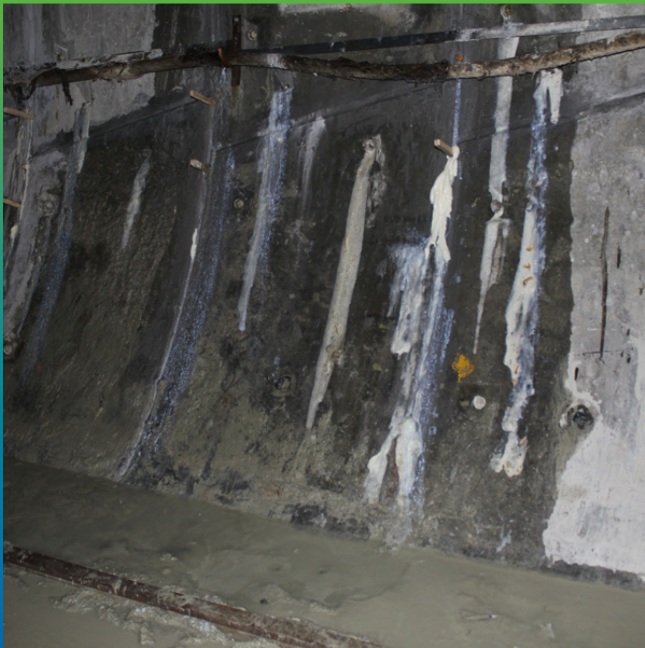
Полимеризация инъекционного состава Манопур 11
