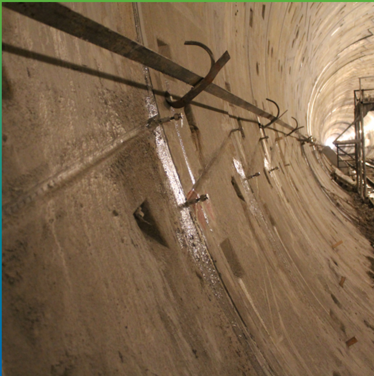
Установка инъекционных пакеров с плоской головкой
