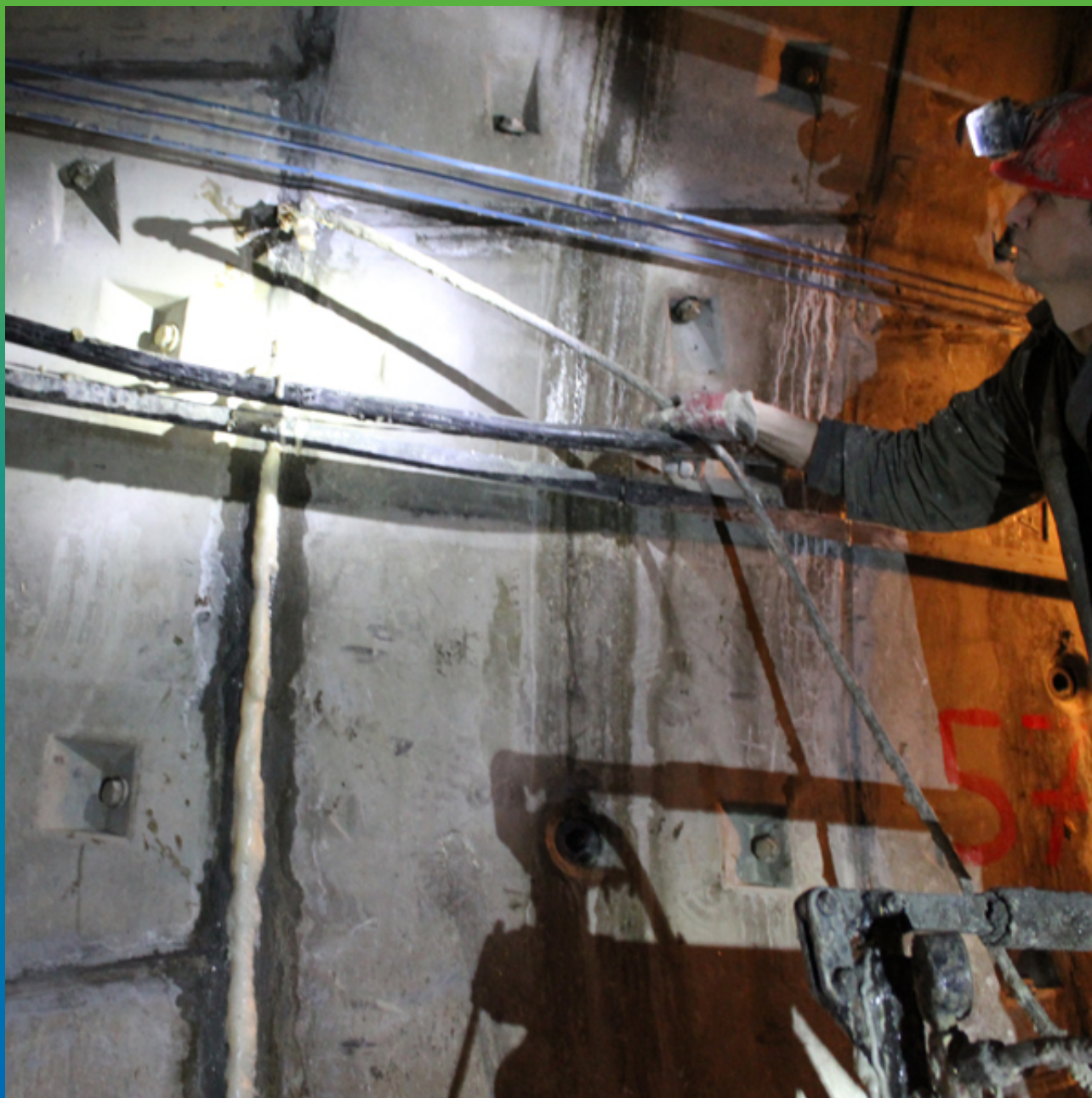
Инъектирование полиуретановой смолой 2-го назначения Манопур 11
