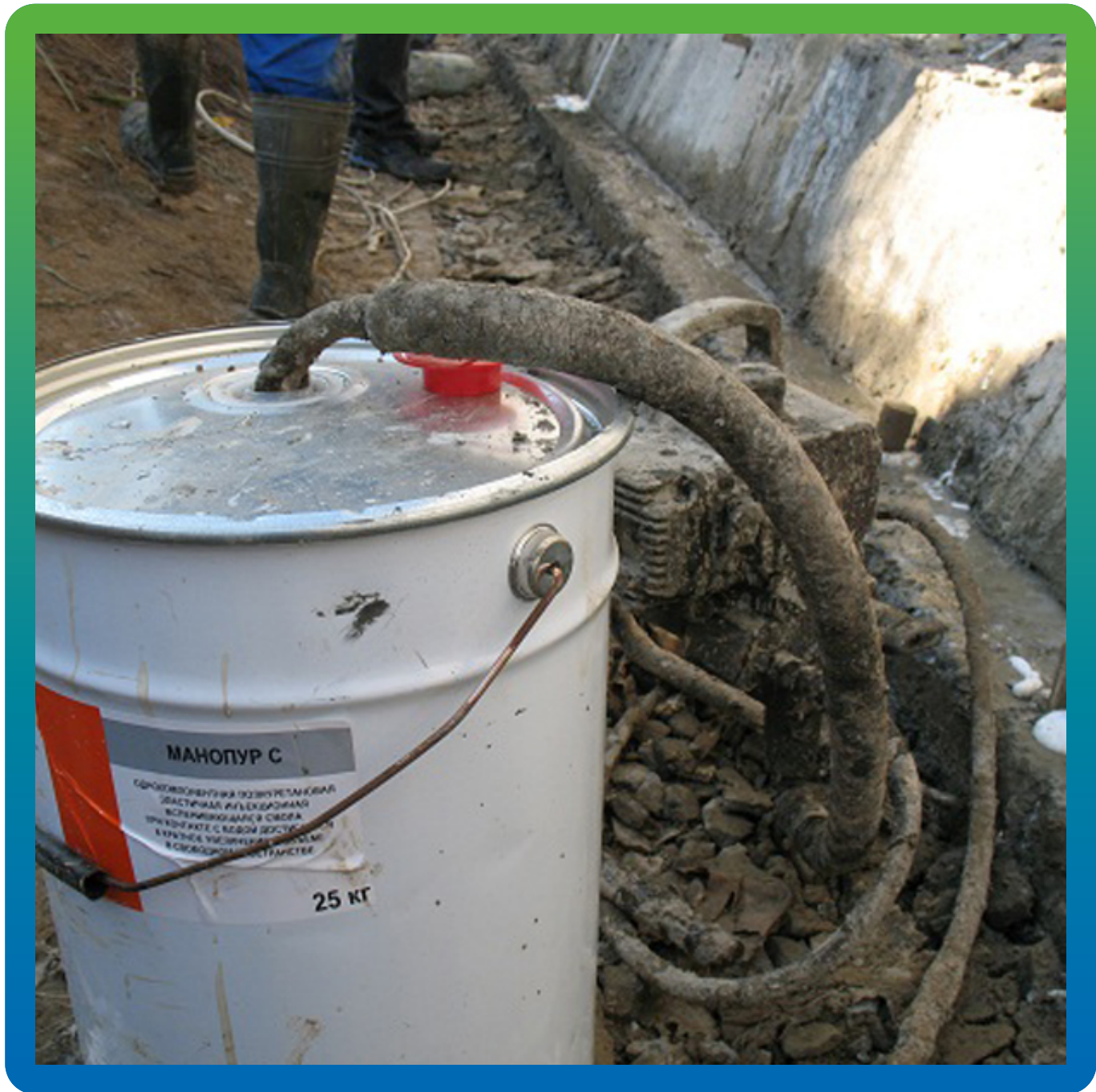
инъекционная смола Манопур С на объекте
