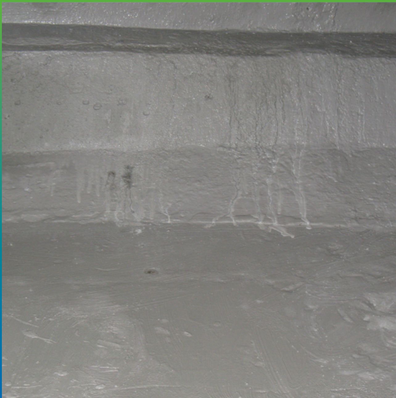
Вид покрытия во время набора прочности
