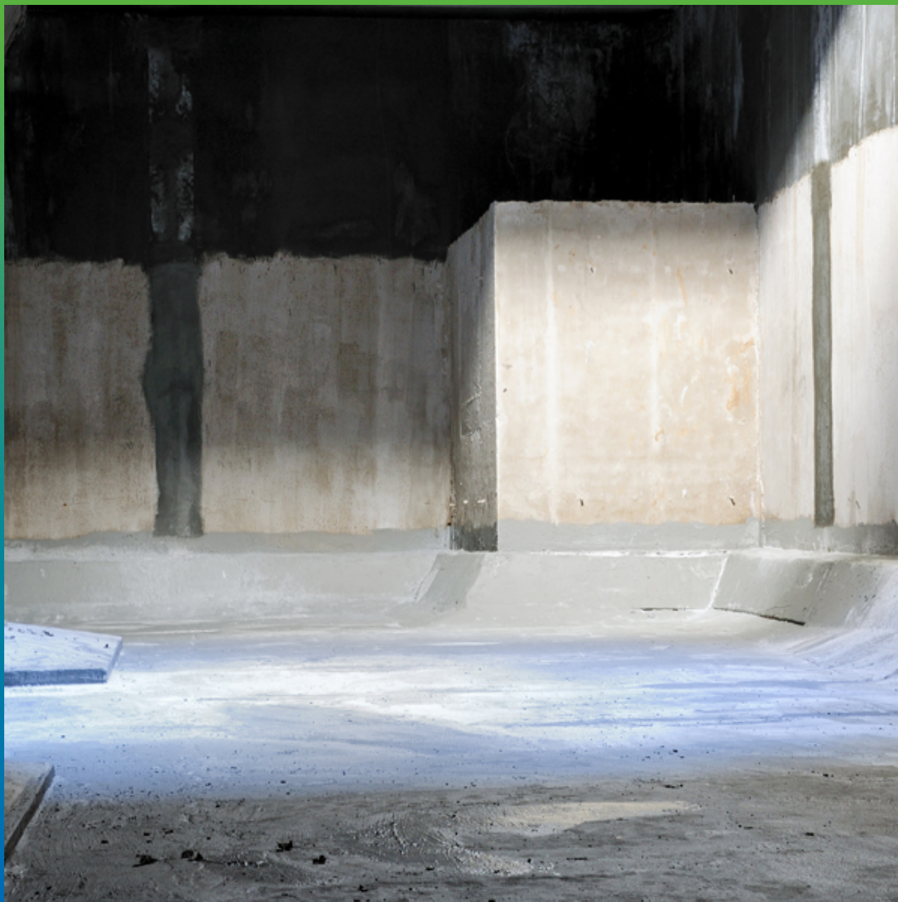
РЕЗЕРВУАР ГИДРОТЕХНИЧЕСКОГО СООРУЖЕНИЯ РЧВ №1
