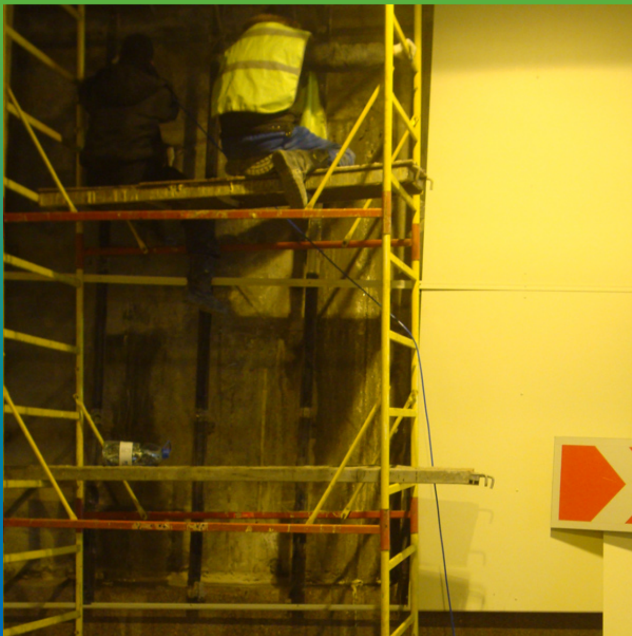
Монтаж инъекционного оборудования (пакеров) в стену
