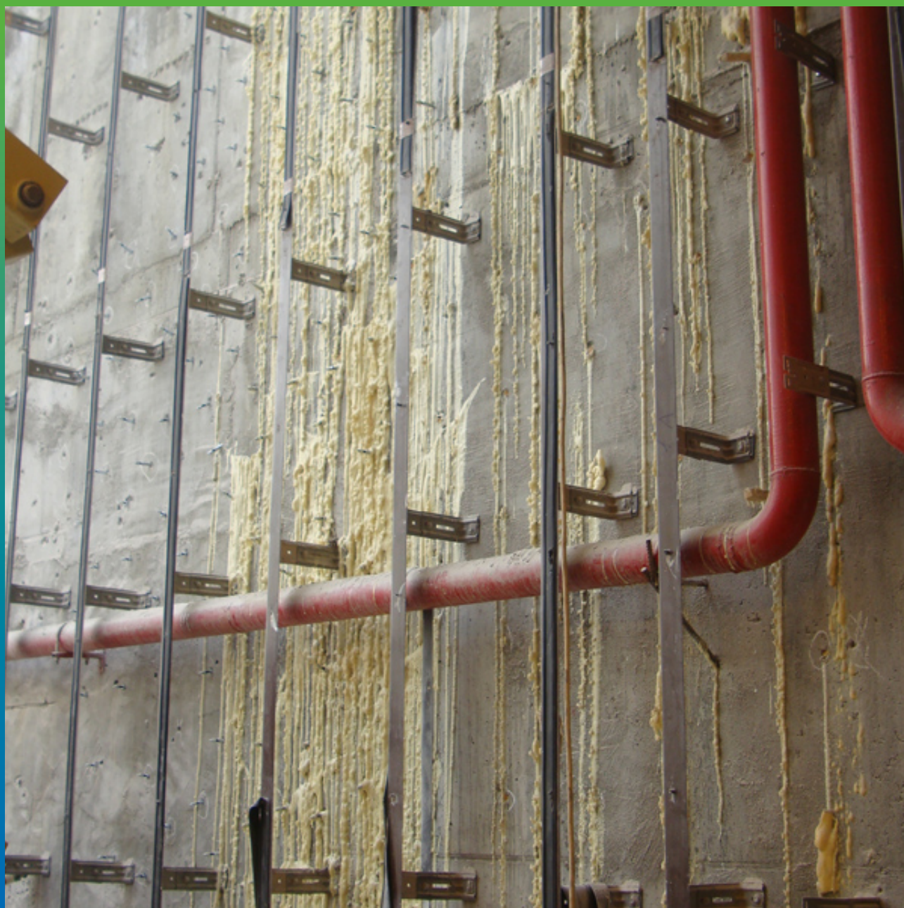
Стена тоннеля после проведения инъекционных работ
