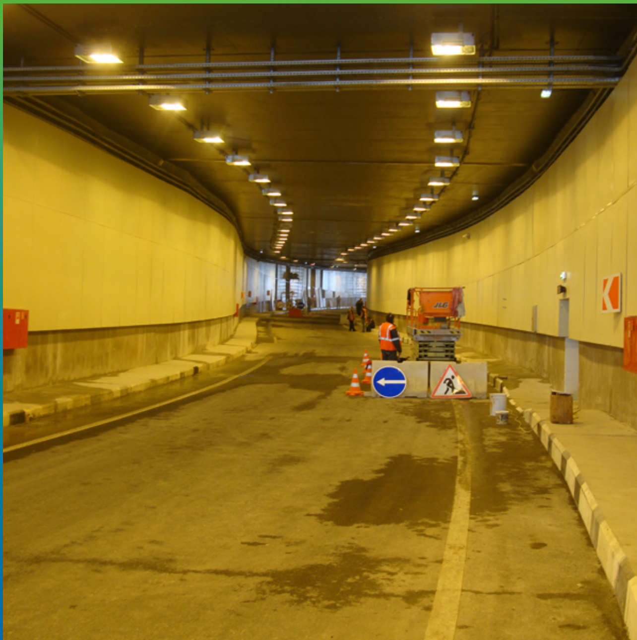
Объект после завершения работ
