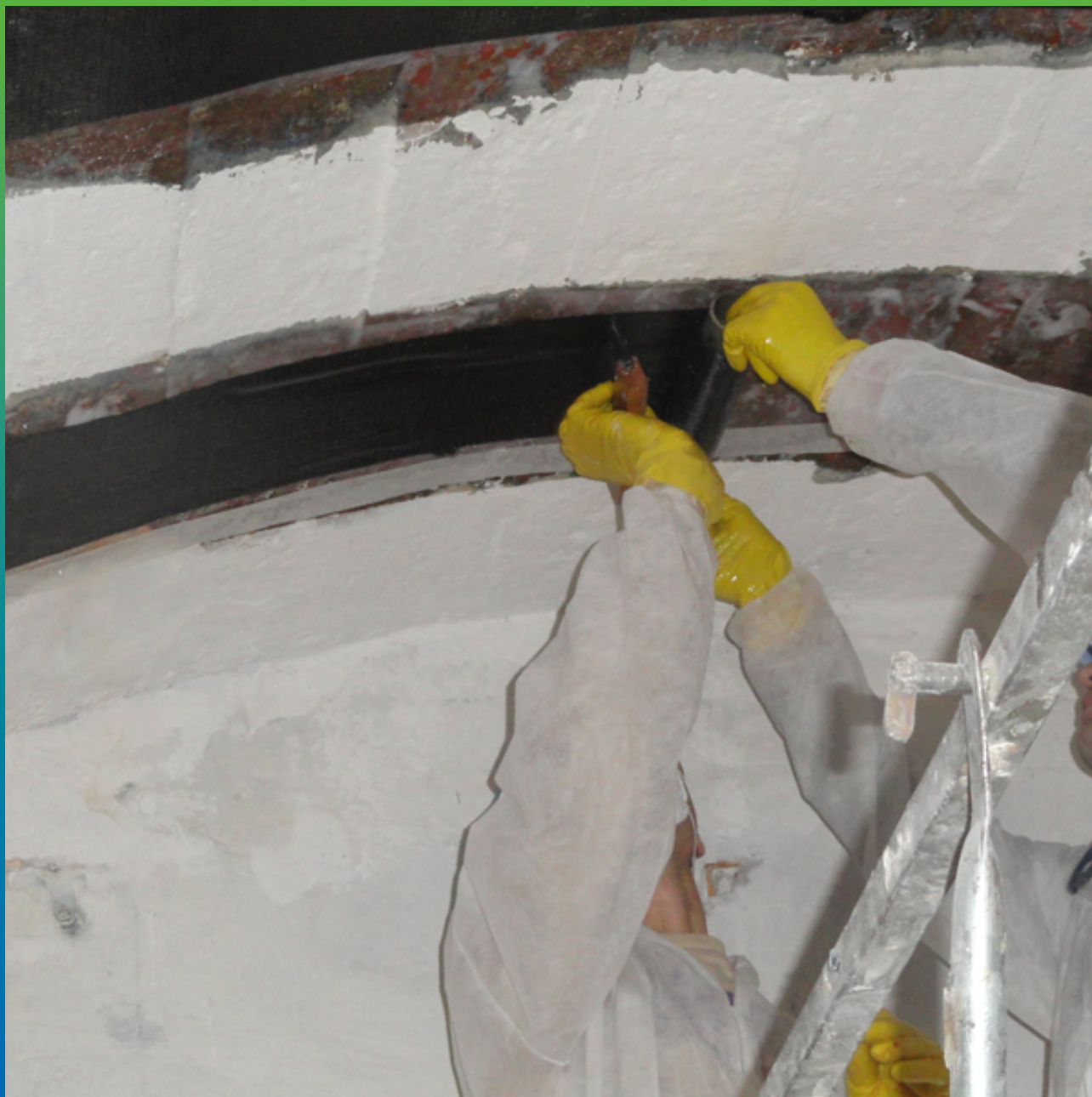
Нанесение материала Армошел КВ 200
