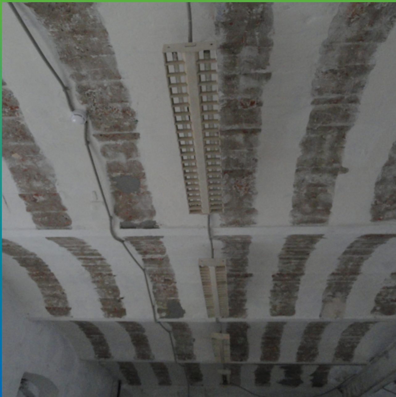
Подготовка поверхности для следующего этапа работ
