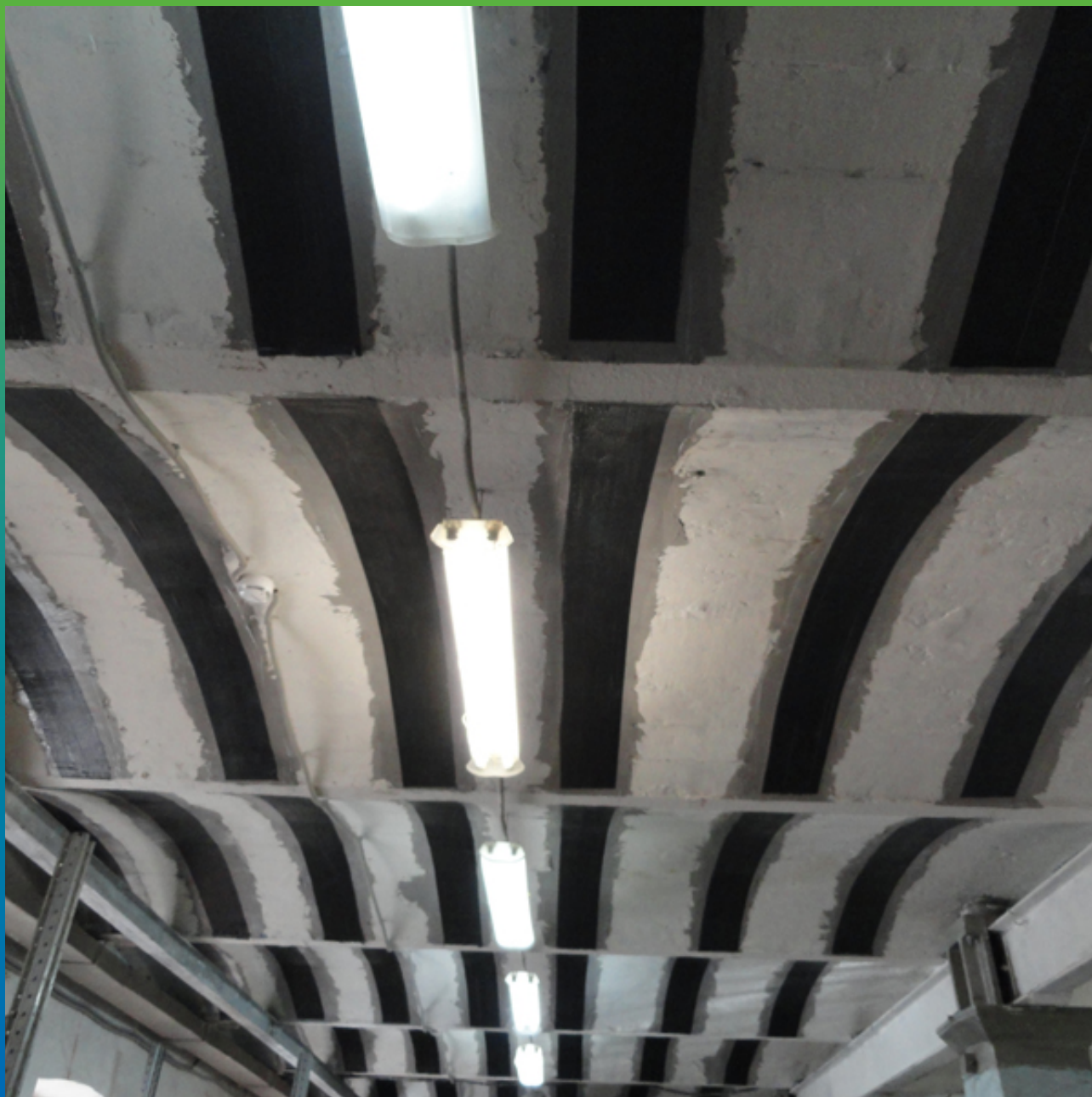
Вид усиленной конструкции, плита перекрытия
