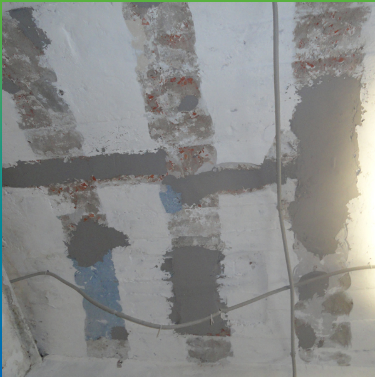
Выравнивание поверхности материалом Манопокс 331
