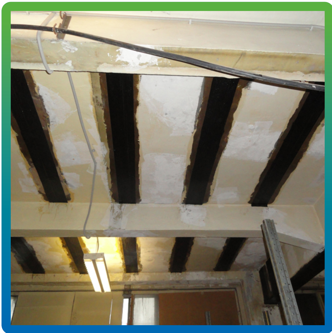
Усиление плиты перекрытия между второстепенными балками
