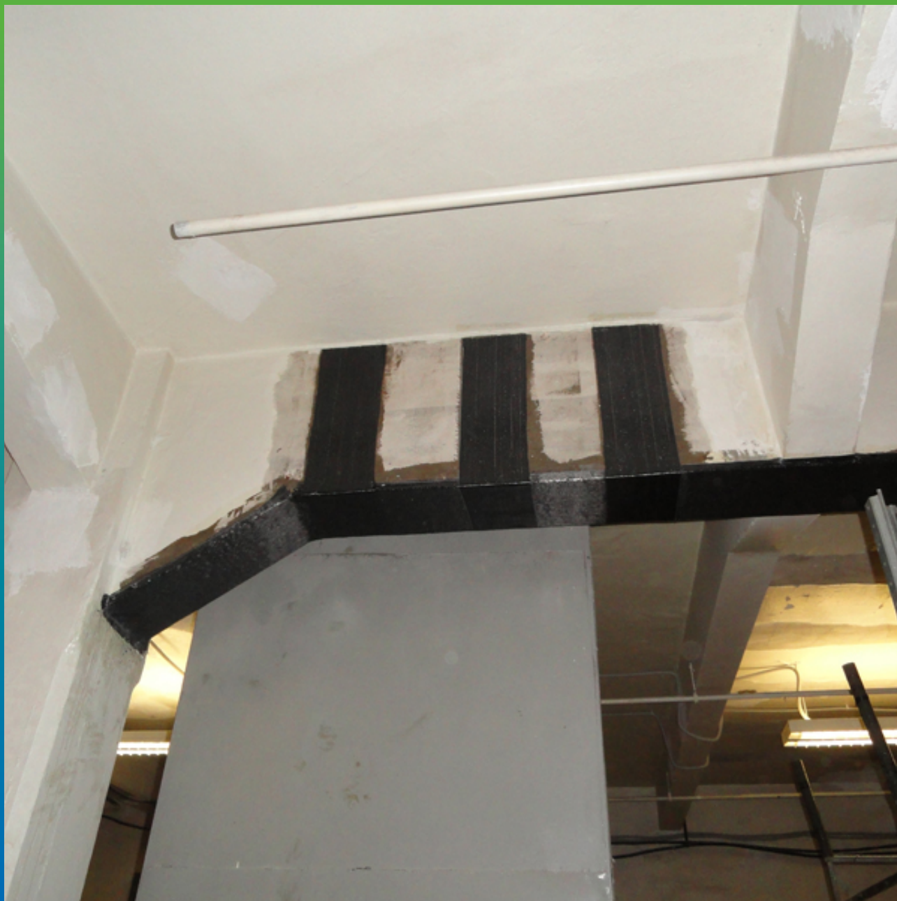
Усиление главной балки с хомутами
