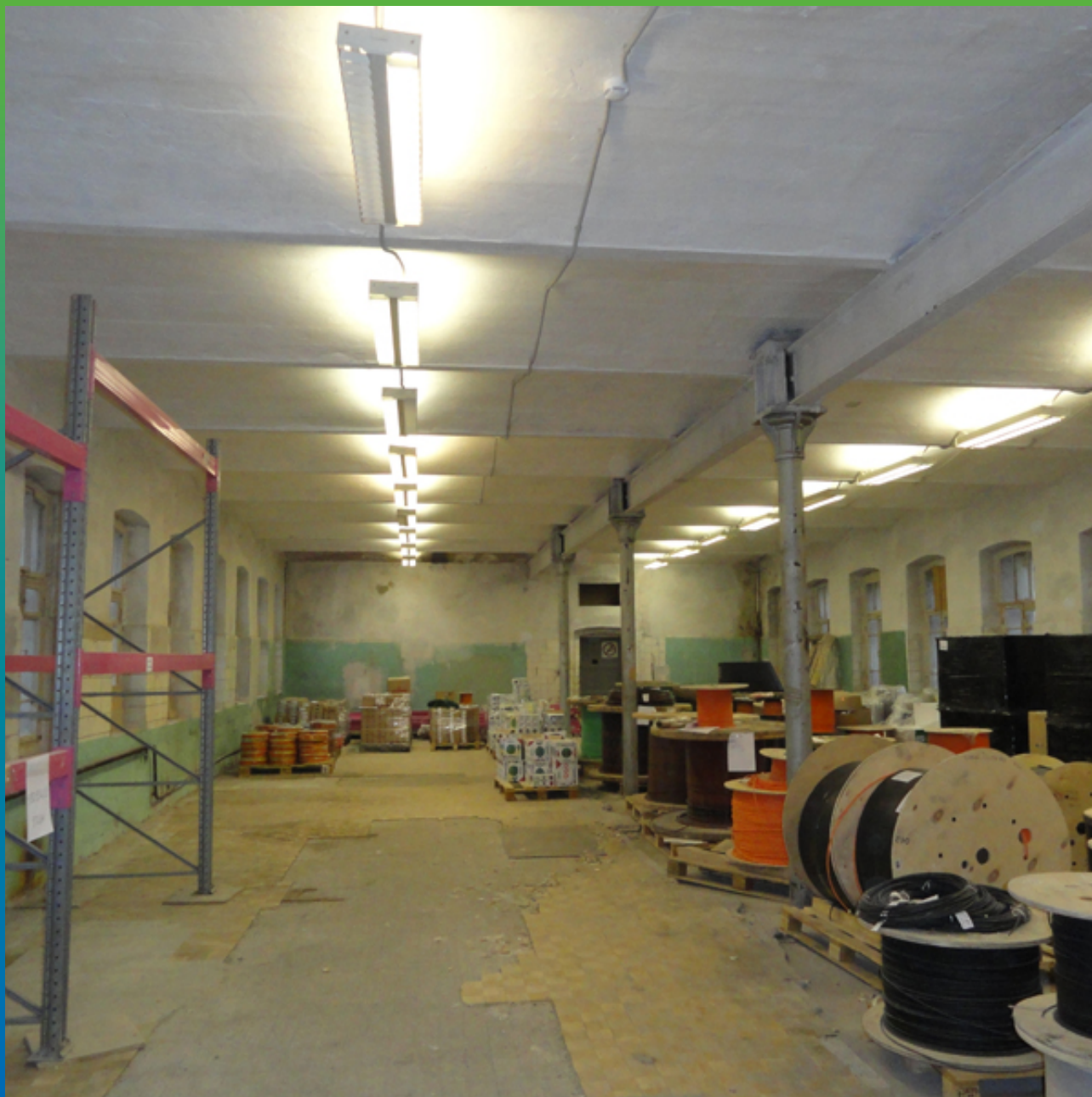
Общий вид следующего этапа работ
