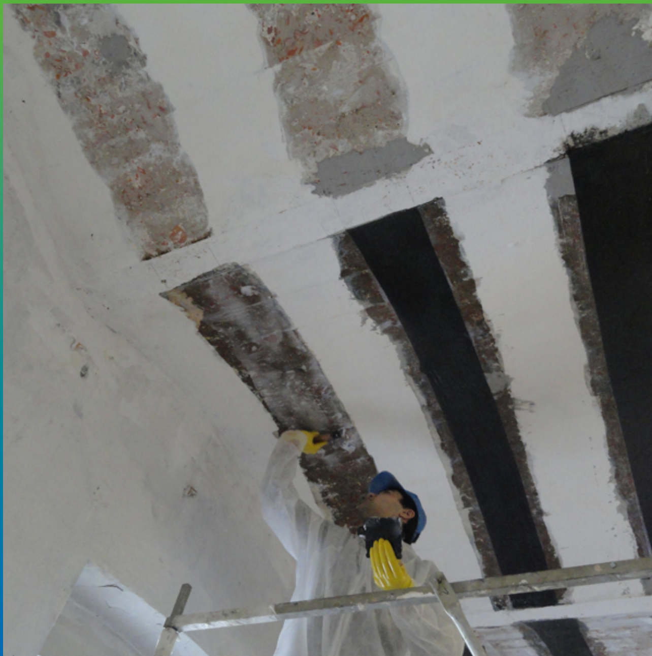
Нанесение промежуточного слоя. Материал Манопокс 372, Манопокс Тикс.
