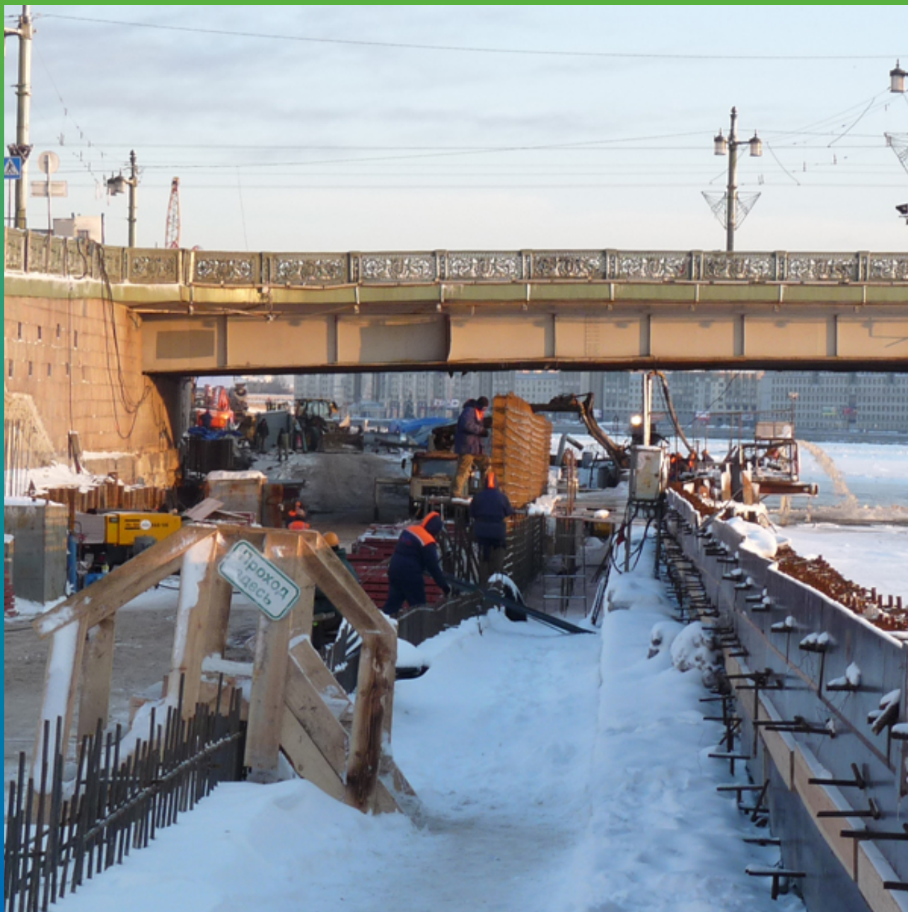
Вид объекта - декабрь 2011. Выставляется опалубка для заливки стен тоннеля
