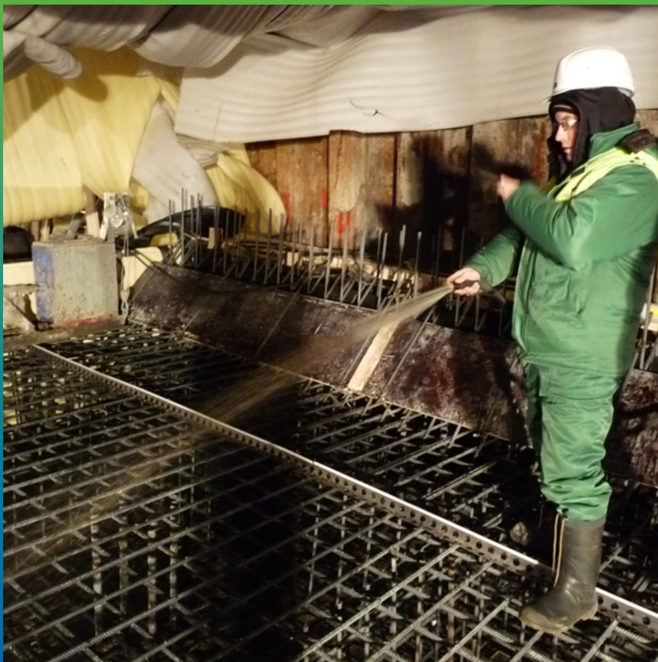
Подготовка поверхности перед просыпкой – увлажнение.
