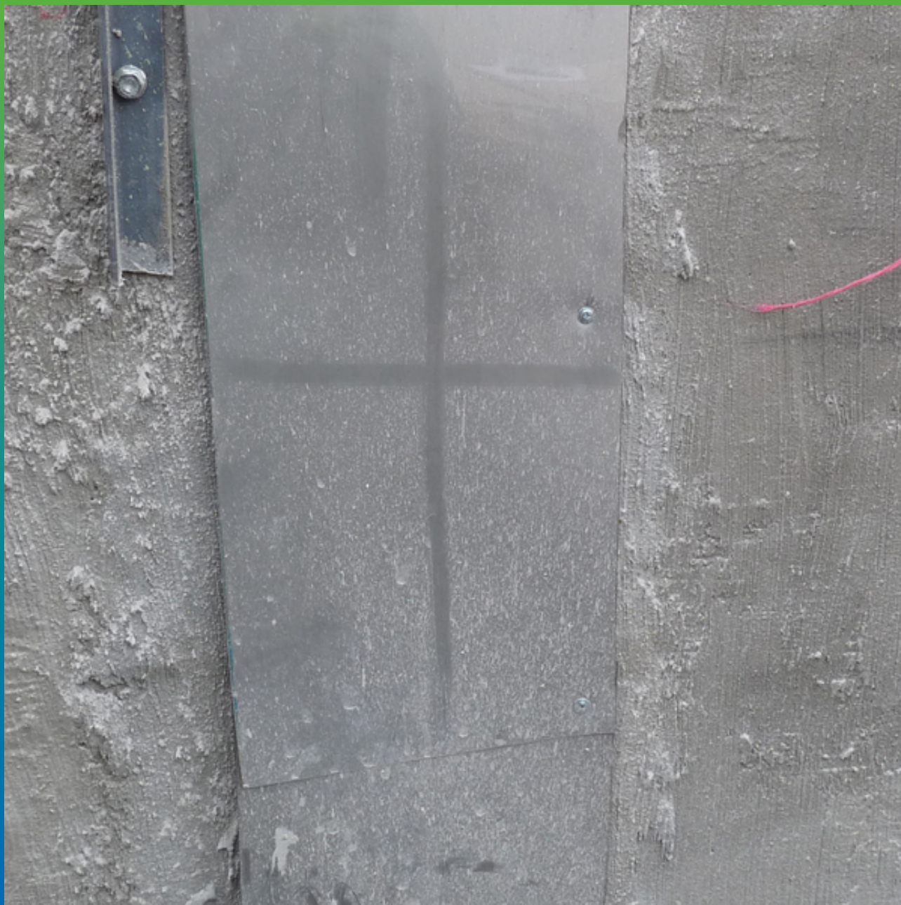
Готовый деформационный шов
