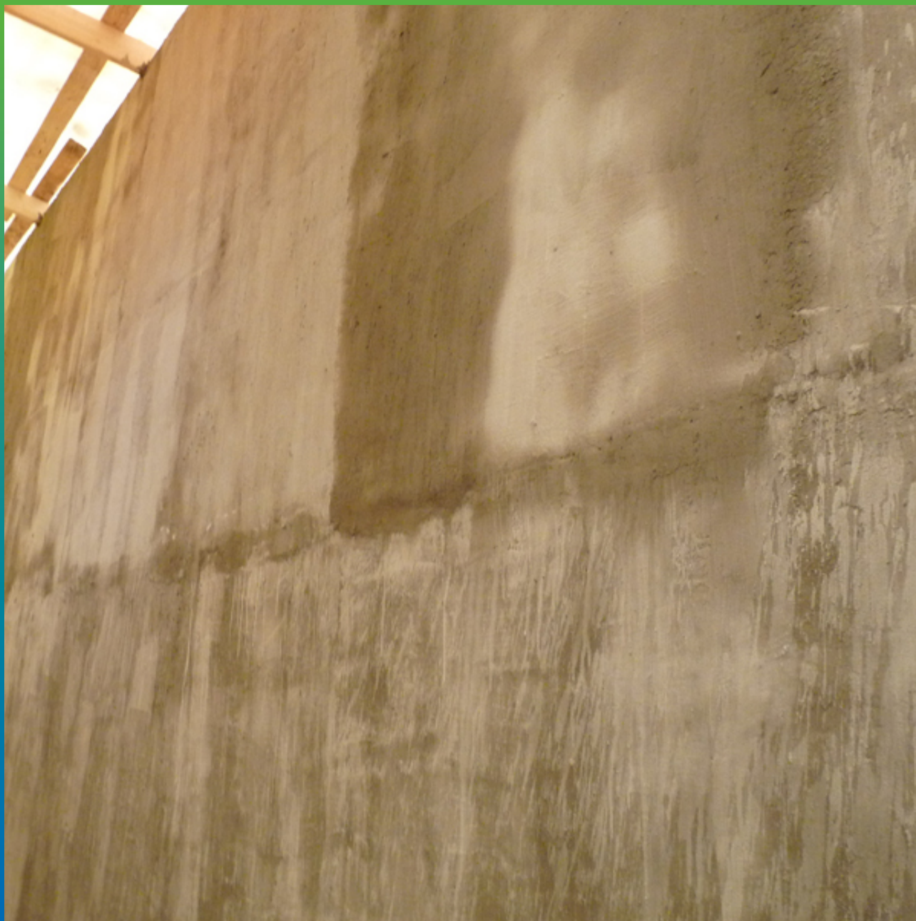
Гидроизоляция стены тоннеля Макссил Супер
