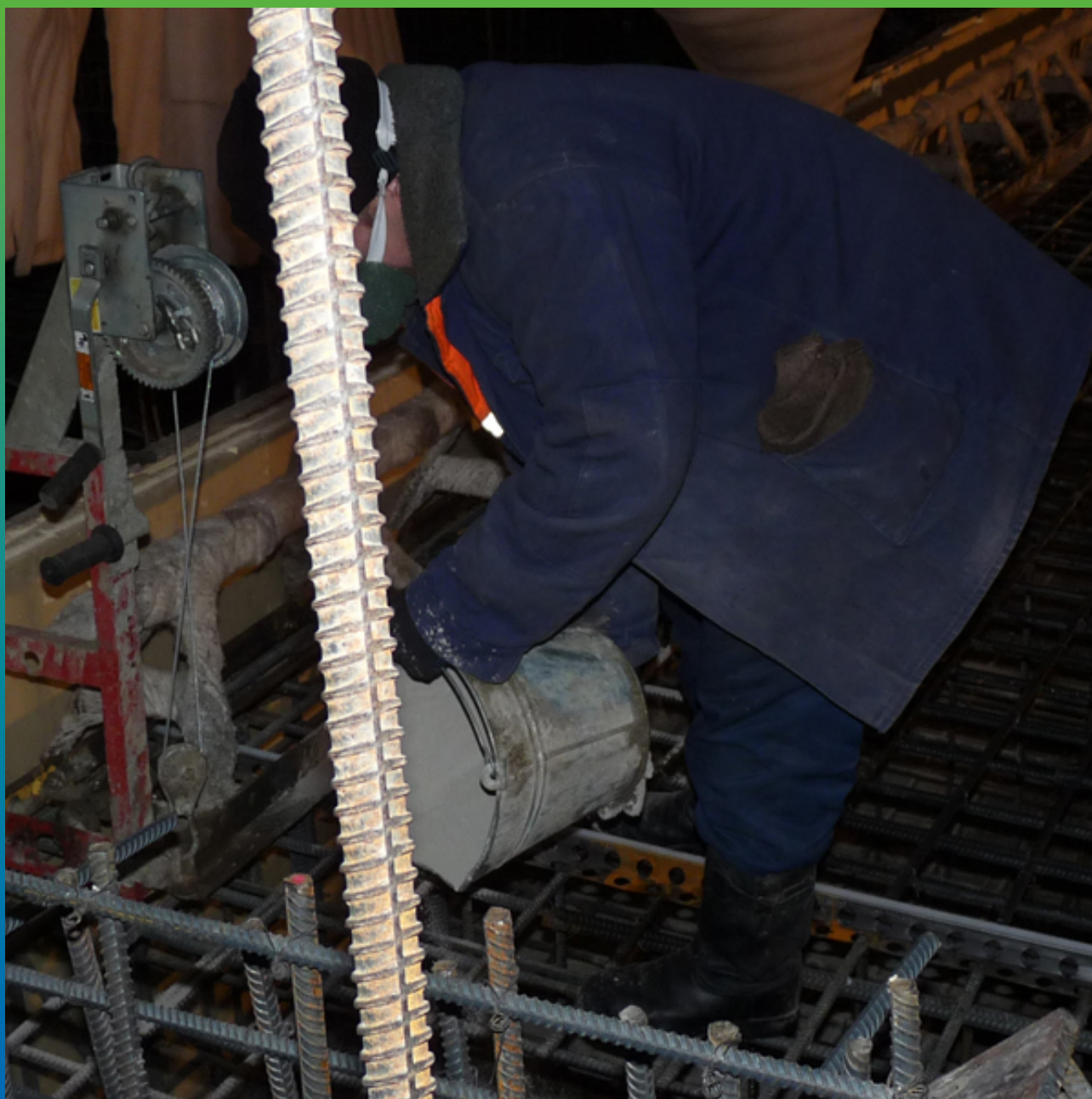
Просыпка бетонной подготовки Макссил Супер перед заливкой плиты.
