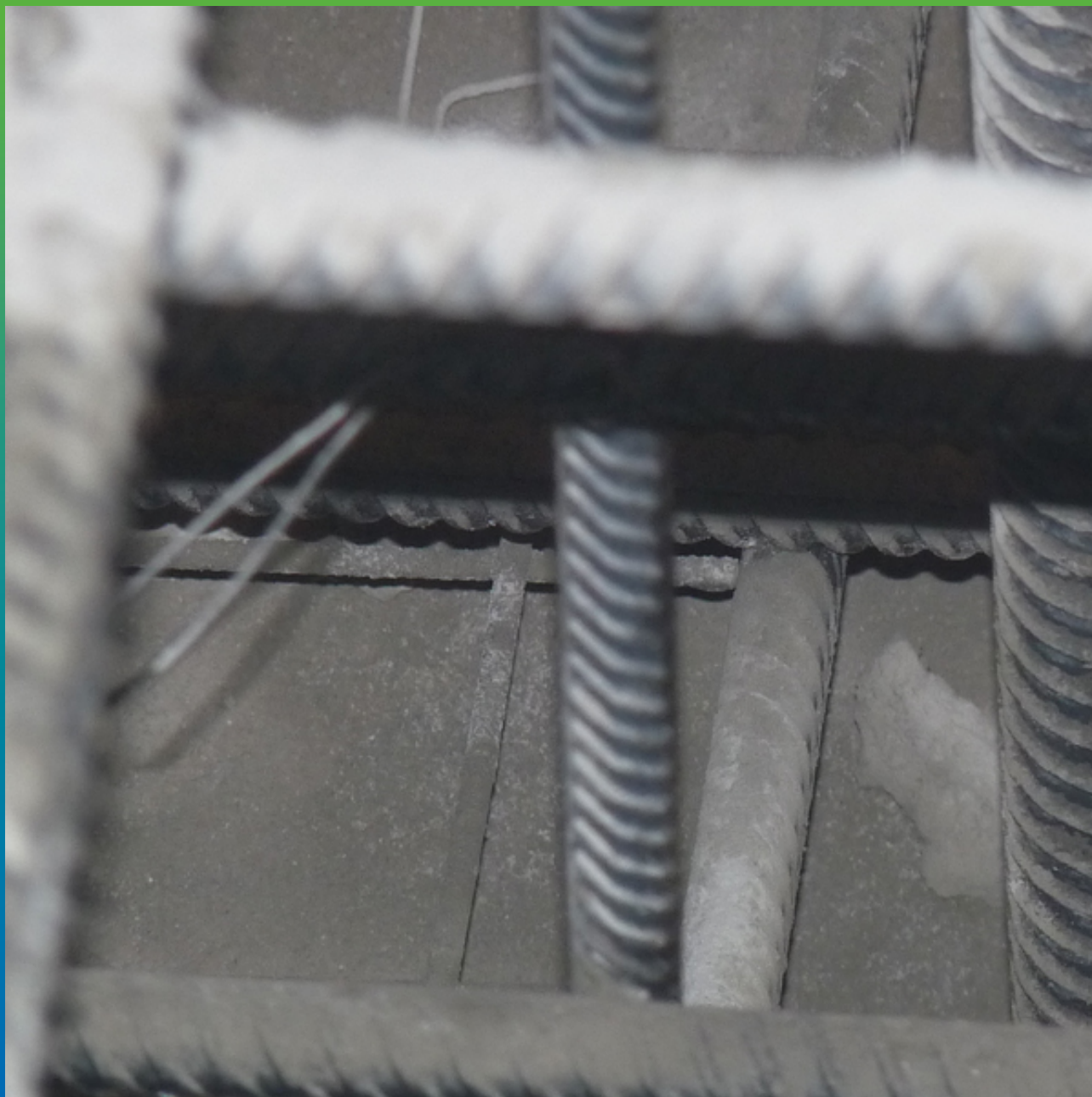
Слой Макссил Супер на бетонной подготовке.
