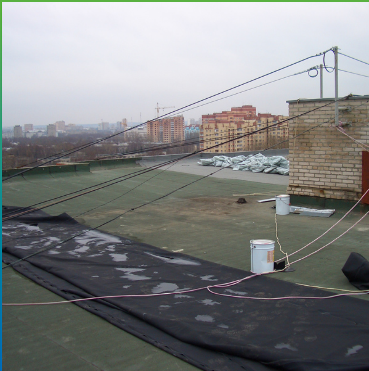
ЭПДМ мембрана Эластосил Флекс Т 1,2 мм перед началом монтажа
