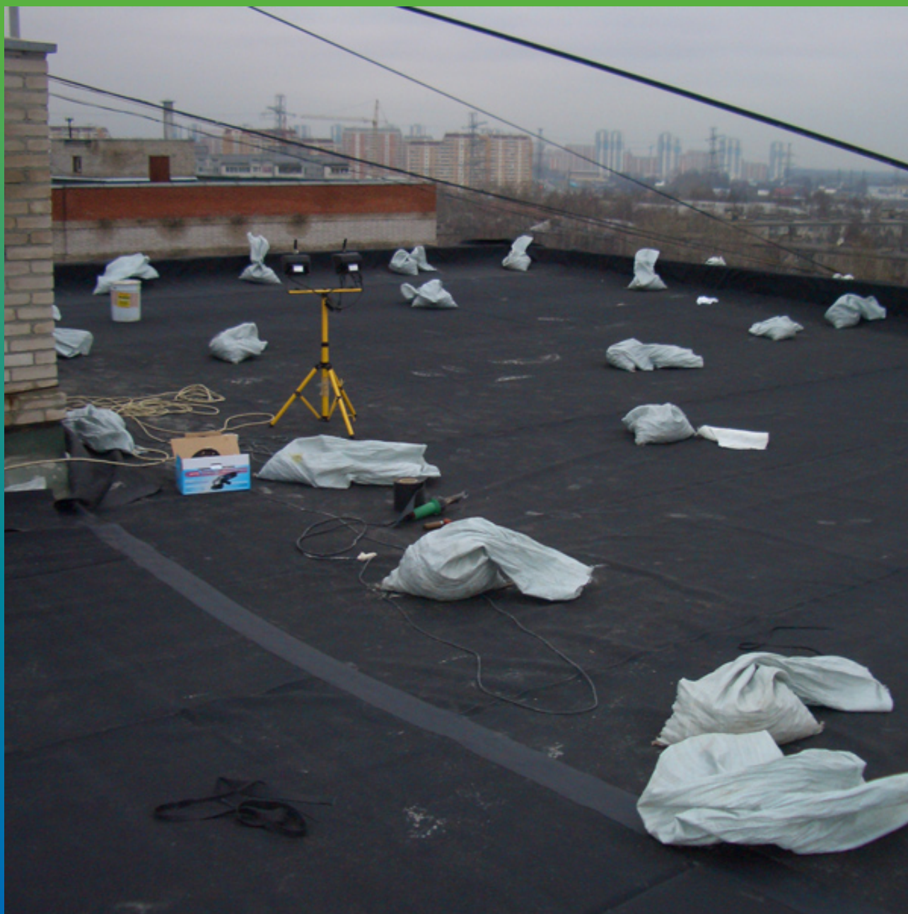
соединение ЭПДМ мембраны полосой Термобонд
