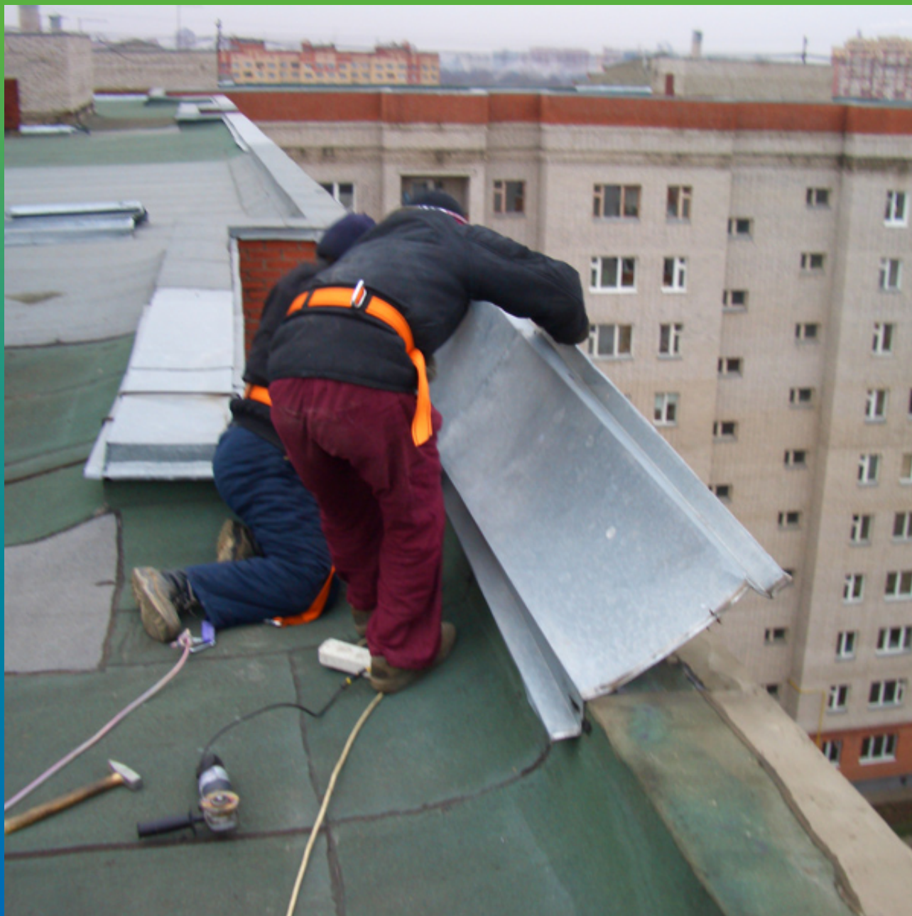
Демонтаж оцинкованного фартука парапета
