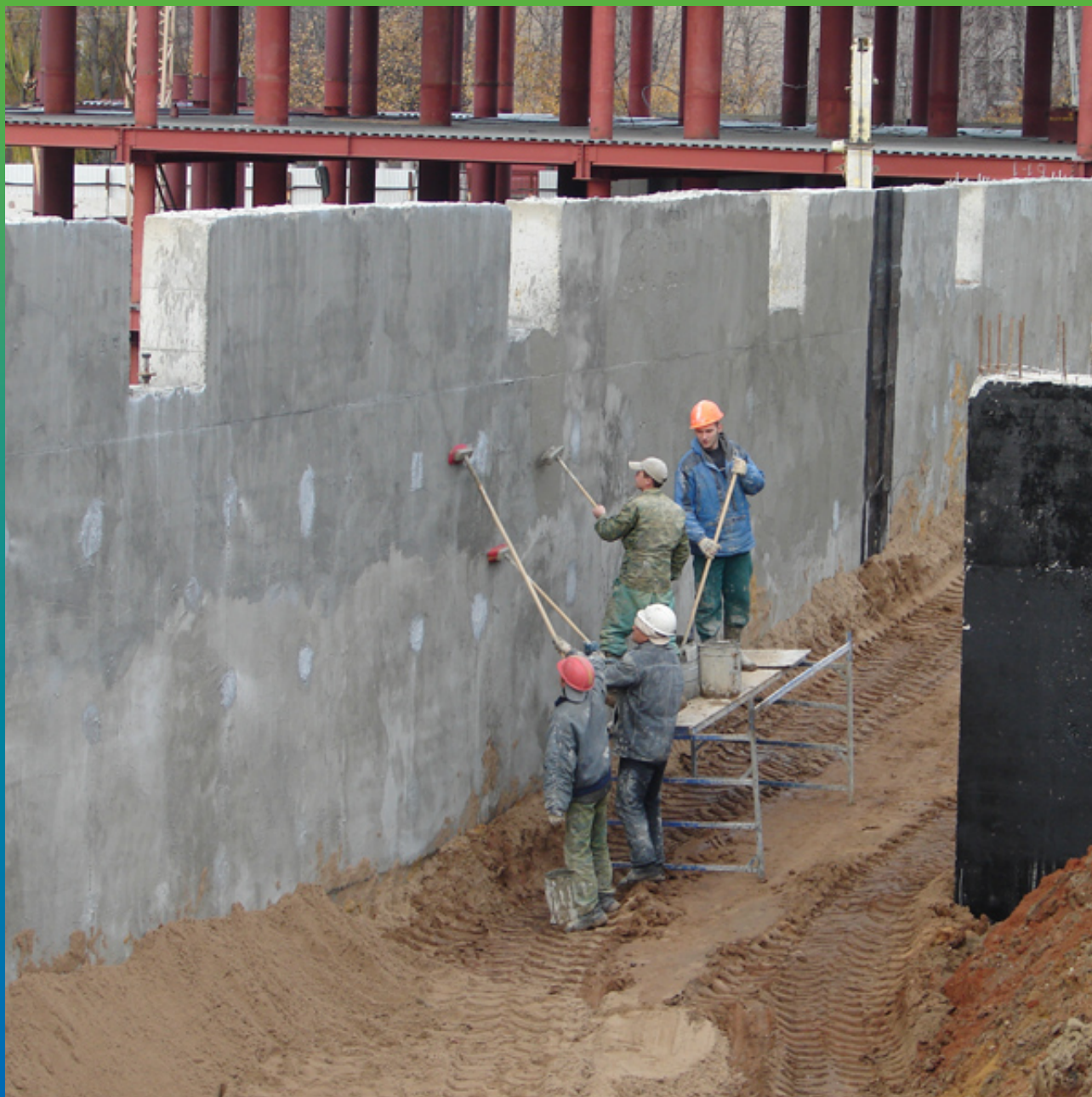
Нанесение материала Максил Флекс
