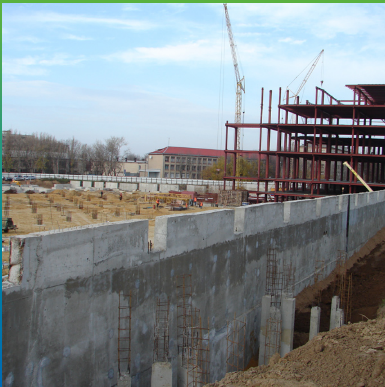
Общий вид фундамента до начала работ
