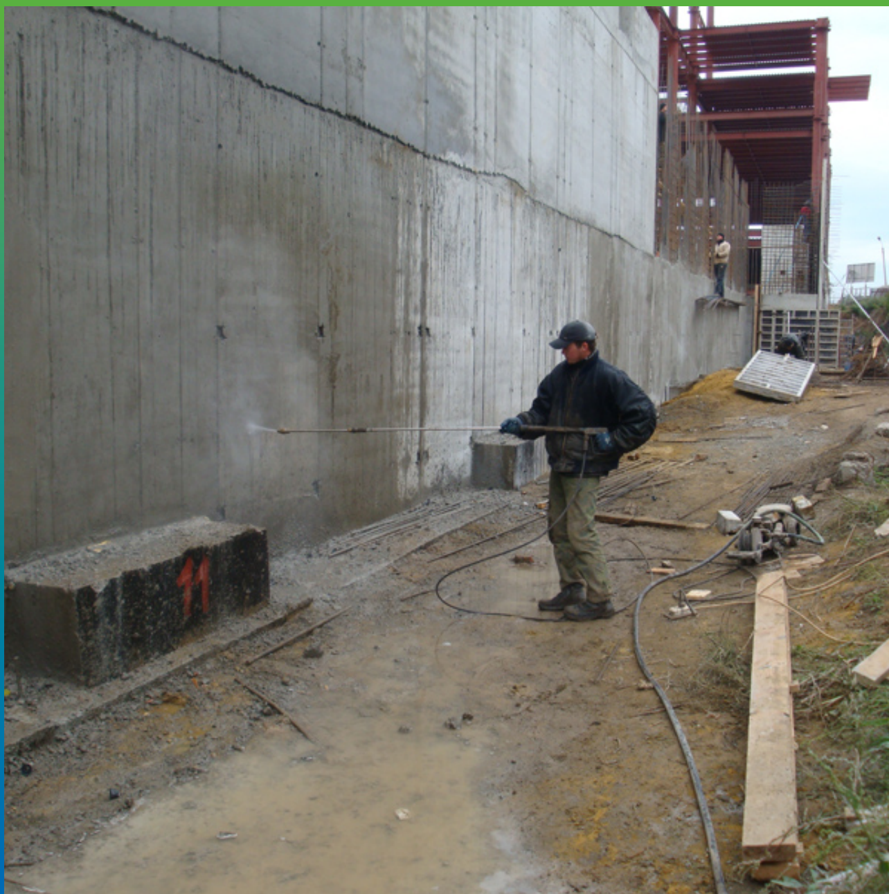
Подготовка основания перед нанесением материала
