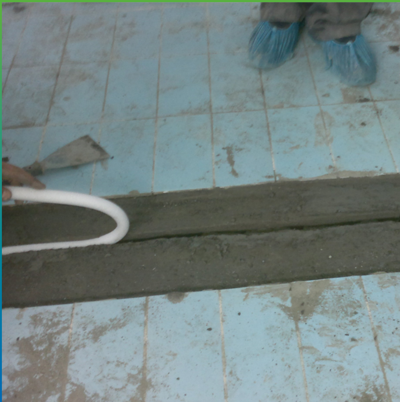
Бурение шпуров, укладка Вилотерм
