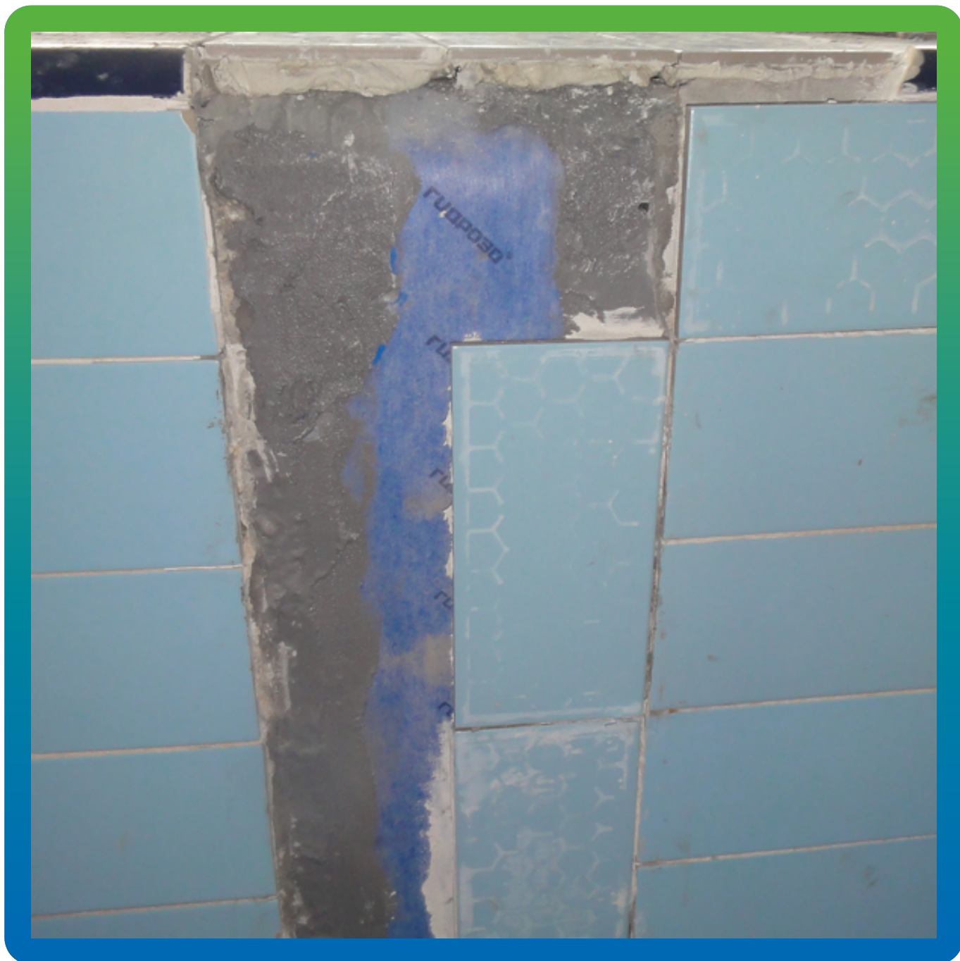
Приклеивание плитки на Макскола Флекс
