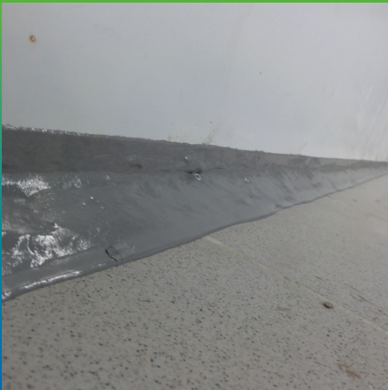
Устройство галтели с применением Манопокс 331
