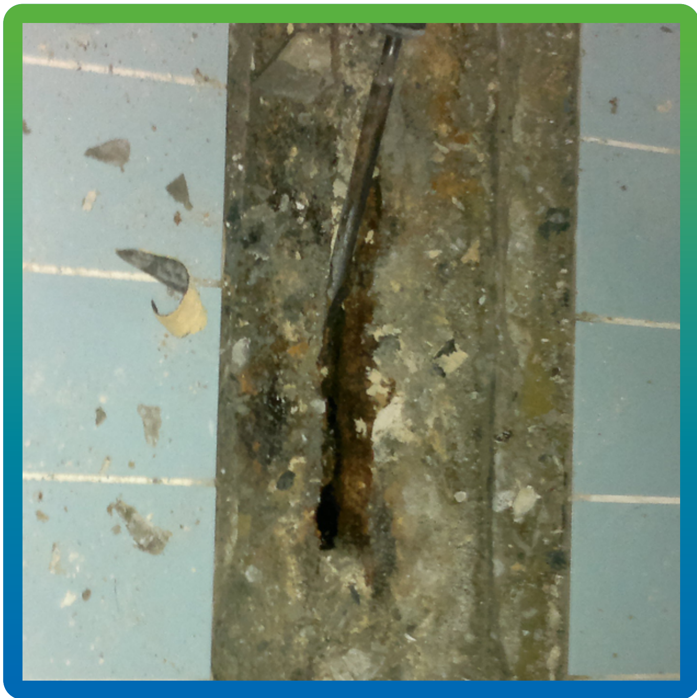
Прочистка шва от старого заполнителя
